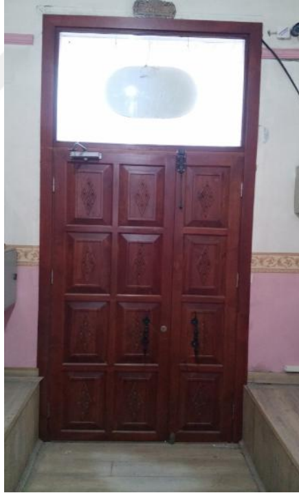
c. Ahşap giriş kapısı
