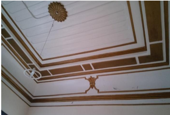
d. Ahşap kaplamalı tavan
