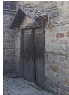
e. Üçgen saçaklı giriş kapısı
