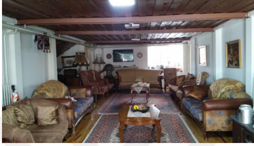
c. Çelik profillerle güçlendirilmiş kat
