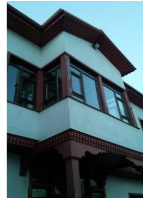
e. Arka cephe cumba görünüşü
