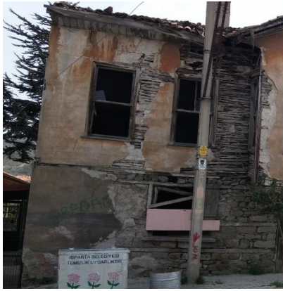
a. Bağdadî sıvalı dış cephe
