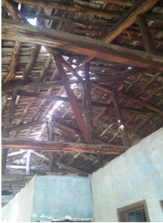
Şekil 4.35. Ahşap iskelet çatı üzerine kurulan çatı
