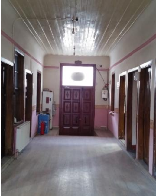
Şekil 4.29. İç sofalı bina görünüşü
