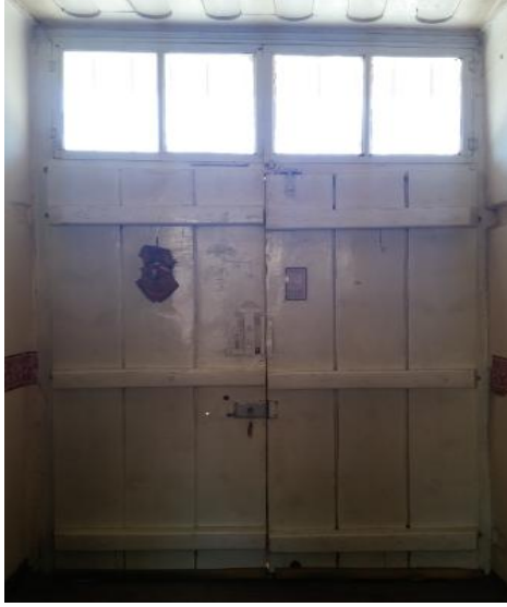
a. Çift kanatlı ahşap kapı
