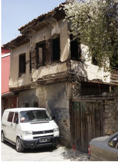
a. Güney cephe
