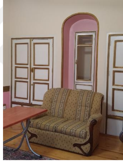
ç. Duvarda gömme dolaplar
