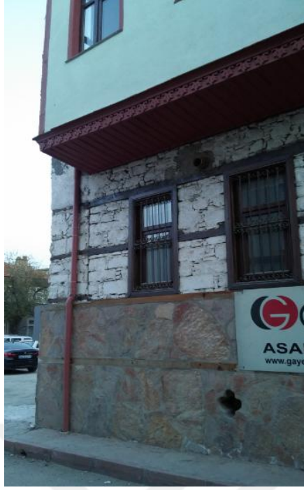
a. Ahşap hatıllı cephe görünüşü
