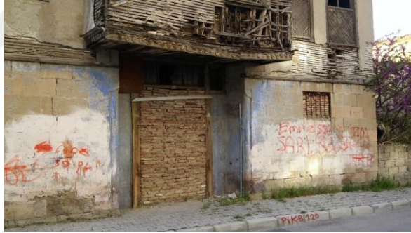
a. Yol cephesinden düz ayak giriş kapısı
