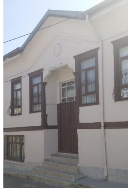
Şekil 4.34. Cephedeki yatay ve düşey silmeler
