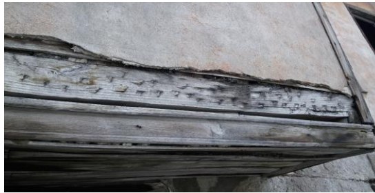
c. Sıva öncesi ahşabın kertiklenmesi
