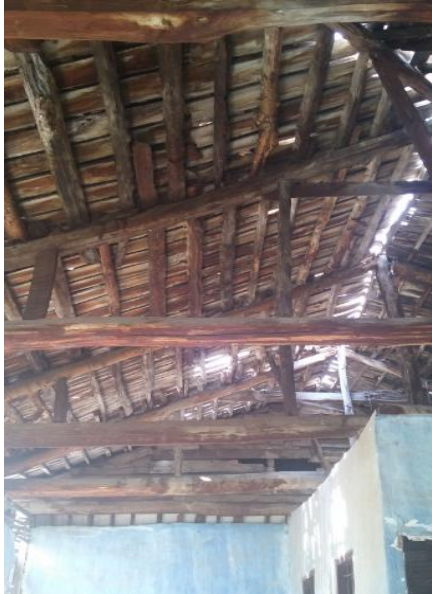
e. Ahşap çatı
