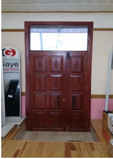
a. Çift kanatlı ahşap giriş kapısı
