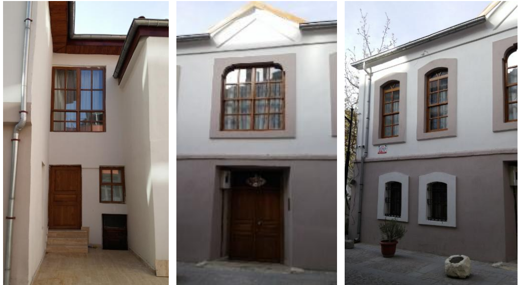
a. Bina dış servis kapısı b. Ana giriş kapısı c. Taş söveli pencereler
