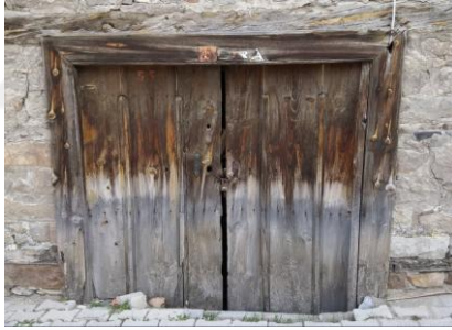
a. Yol kodu altında çift kanatlı ahşap kapı
