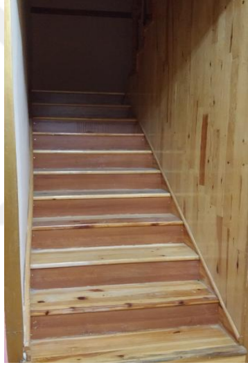
c. Tek kollu ahşap merdiven
