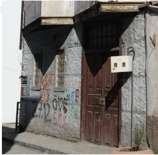
a. Çift kanatlı ahşap giriş kapısı
