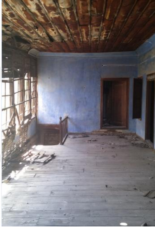
Şekil 4.30. Dış sofalı bina görünüşü
