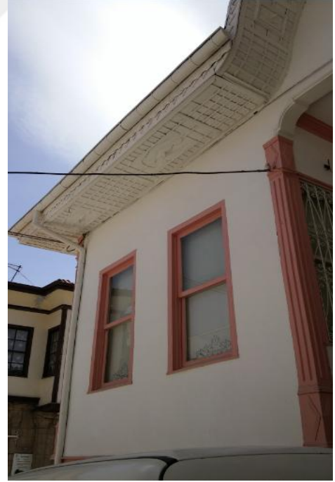
e. Çatı saçağı
