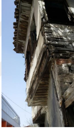
c. Giriş cephesinde çıkma
