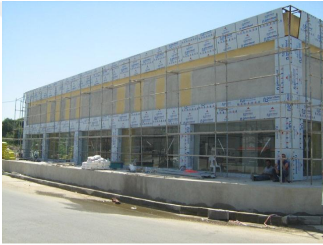
Şekil 6-30: Metal ve cam giydirme cephe uygulaması
