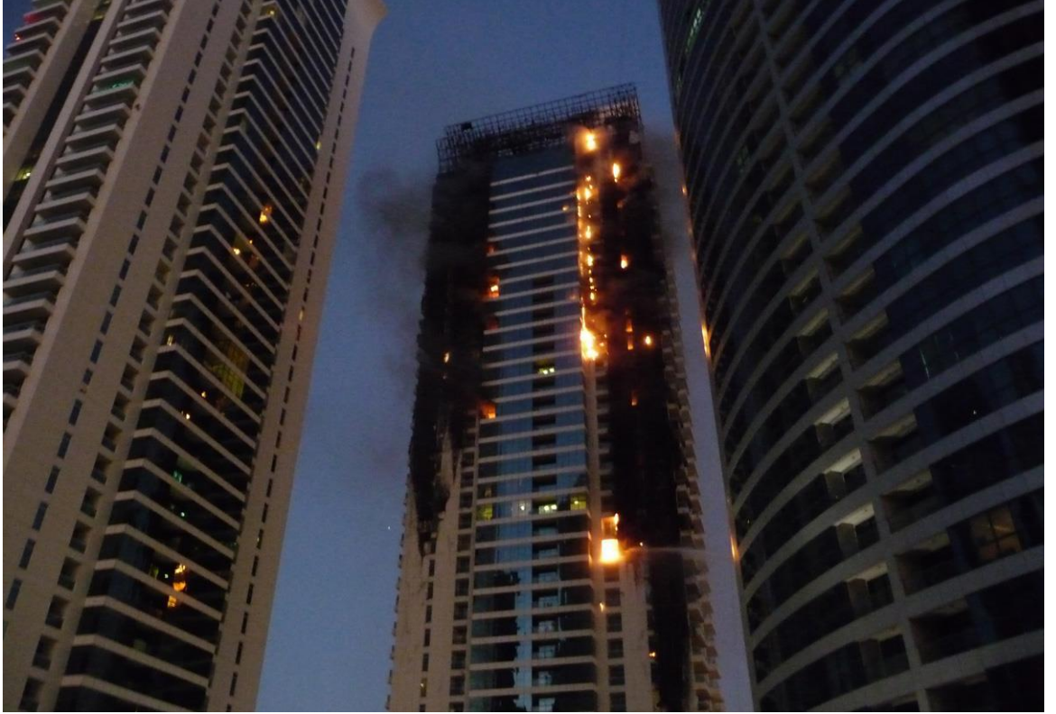
Şekil 7-1:Dubai Tamweel cephe yangını
