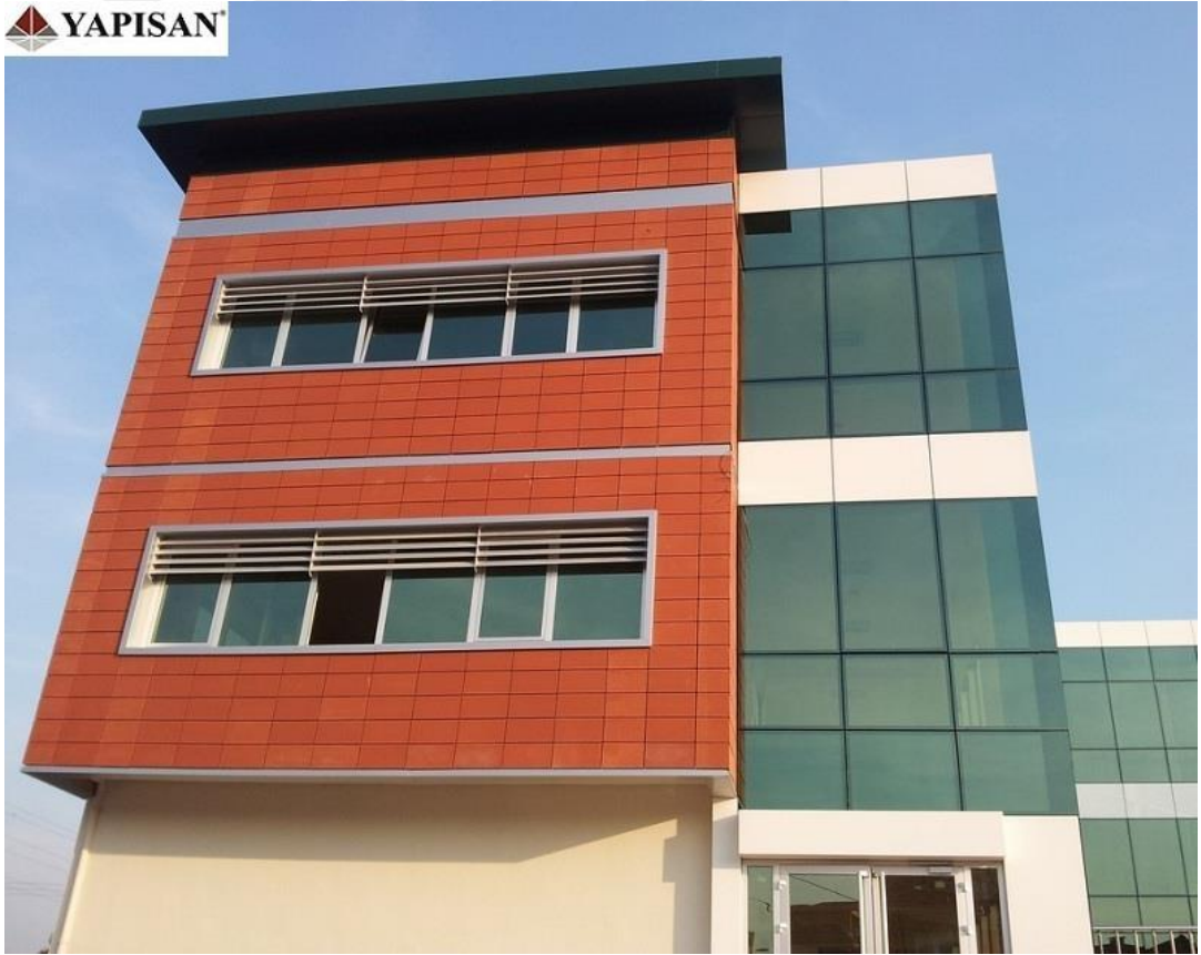
Şekil 6-16:Terra-Cotta Giydirme Cephe Uygulaması
