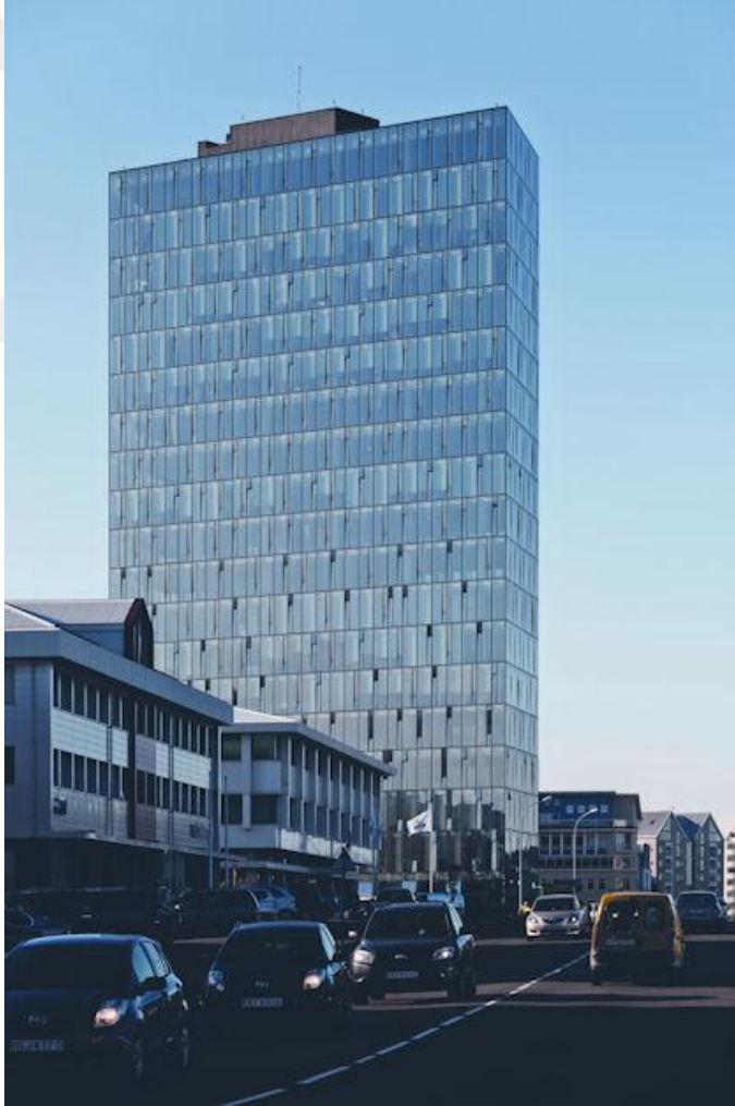
Şekil 4-9:Panel sistem giydirme cephe
