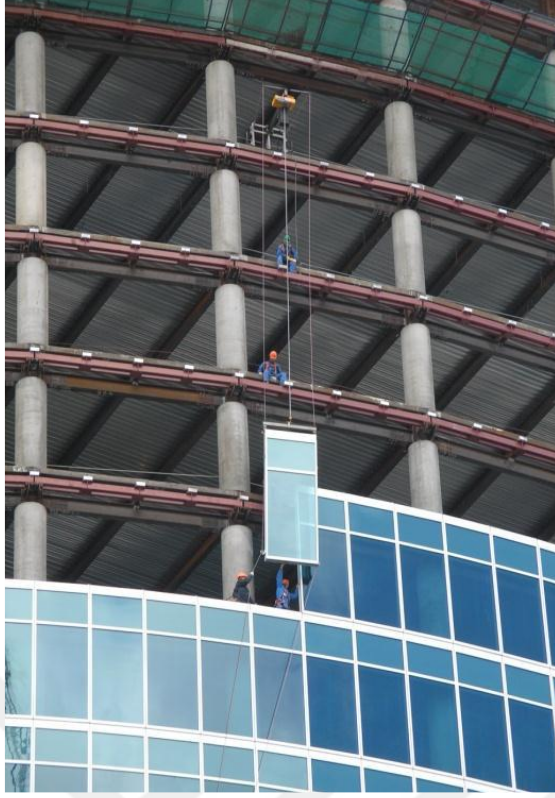
Şekil 4-11:Panel montajı
