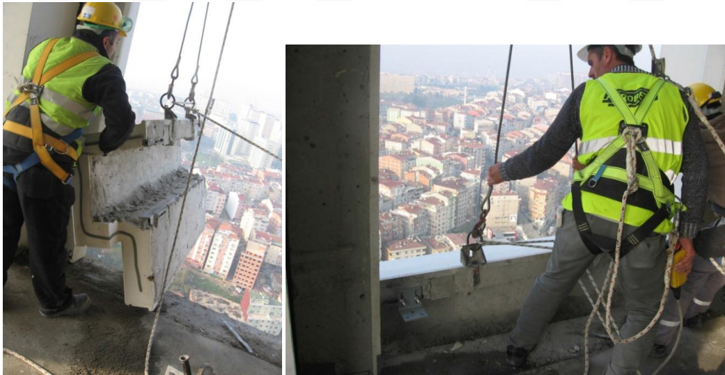
Şekil 6-9:Panelin birleşim yüzeylerine montaj öncesi derz malzemesi yerleştirilmesi.
