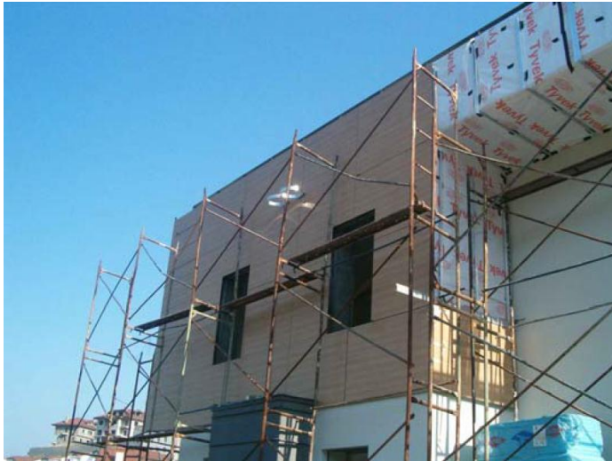
Şekil 6-32: Kompakt laminat giydirme
