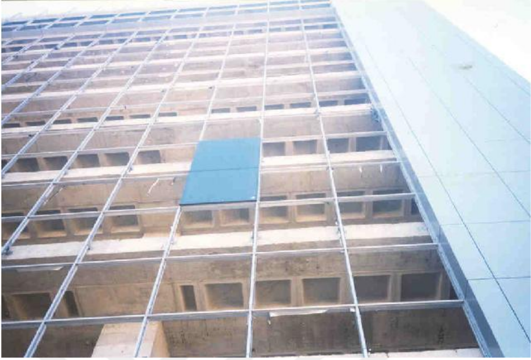
Şekil 4-3Çubuk giydirme sistemi
