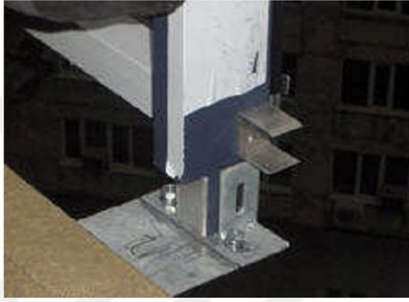
Şekil 6-5: Yatay Profillerin Montajı
