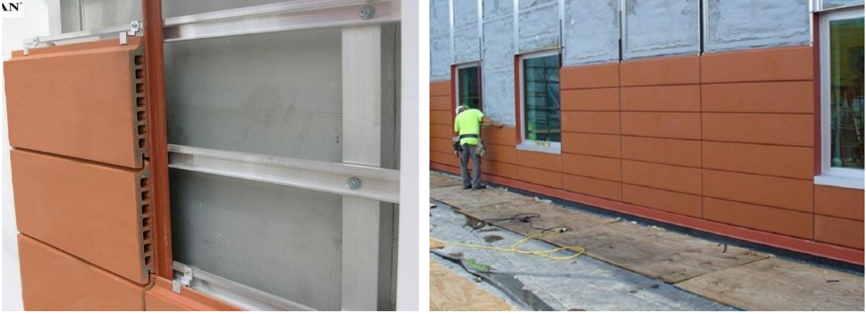
Şekil 6-15:Terra-Cotta Giydirme Cephe Uygulaması
