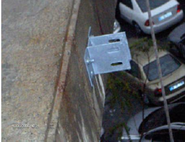
Şekil 6-3: Betonarme Yüzeve Sabitlenen Ankraj
