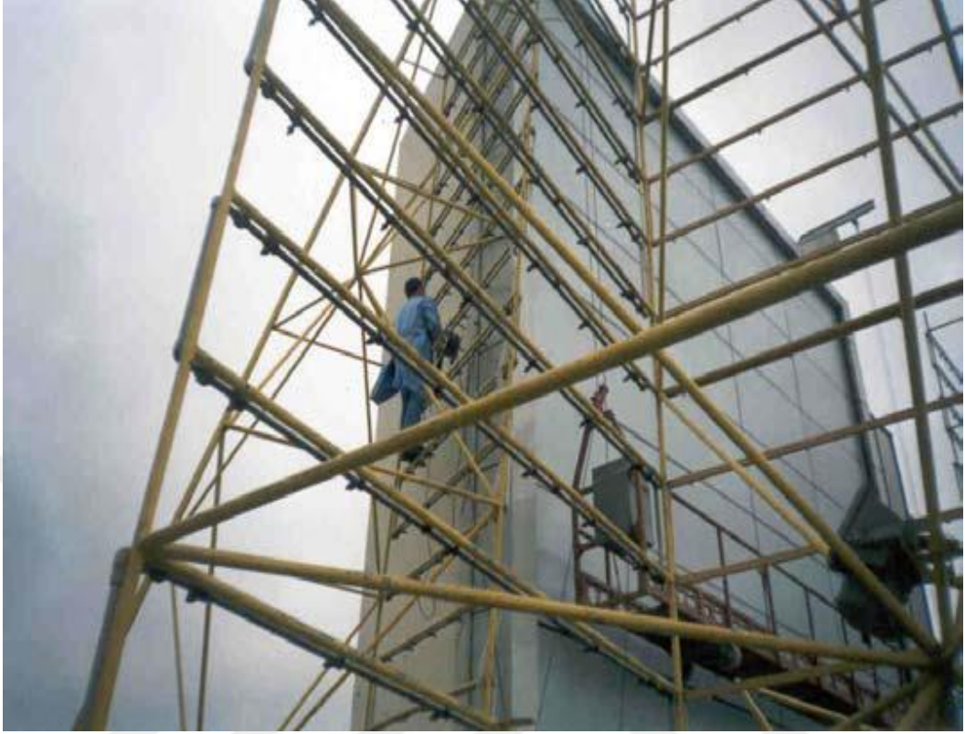
Şekil 7-5: Su Geçirimsizlik Deney ünitesinin hazırlanması
