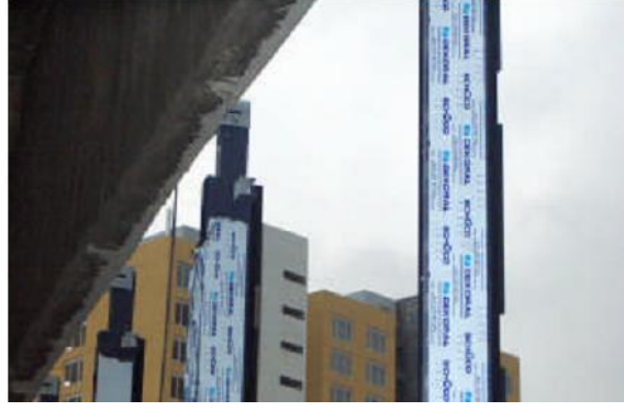
Şekil 6-4: Ankrajlara Monte Edilen Düşey Profiller
