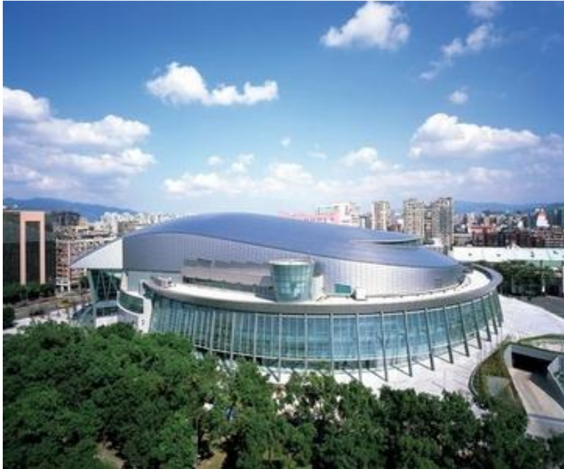
Şekil 6-27: Titanyum kompozit dış cephe malzemesi kullanımı
