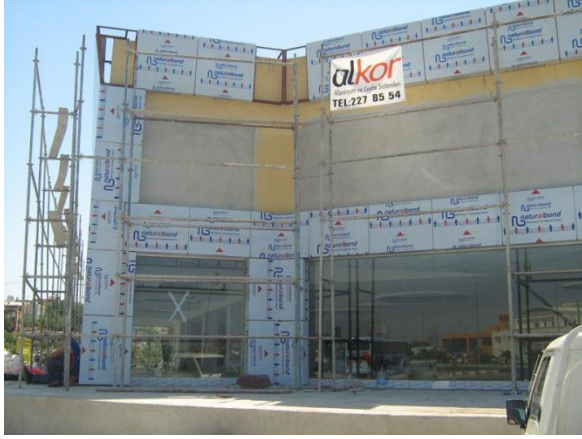
Şekil 6-29: Metal ve cam giydirme cephe uygulaması
