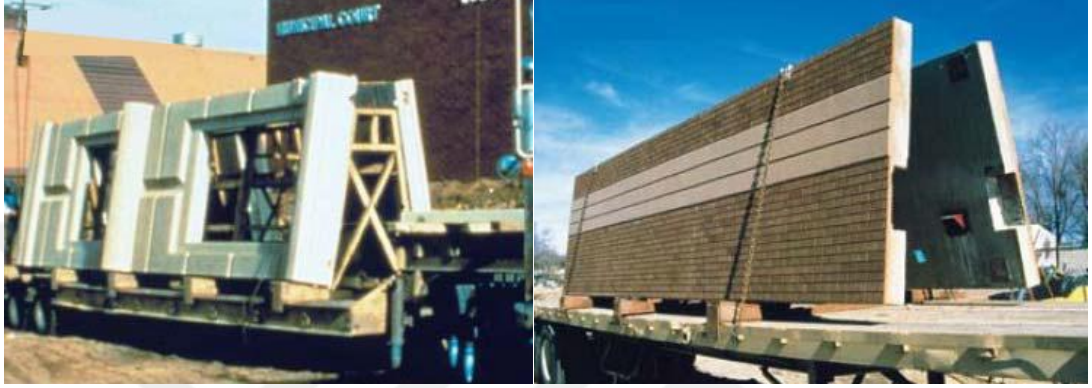
Şekil 6-8:Cephe panellerinin "A" çerçevesi taşıma aracına yerleştirilmesi
