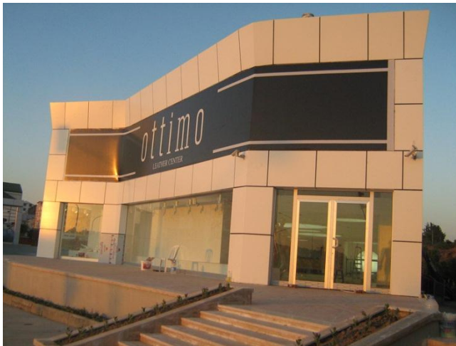
Şekil 6-31: Metal ve cam giydirme cephe uygulaması
