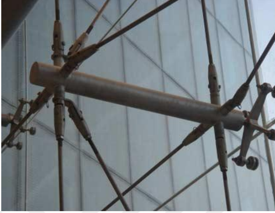
Şekil 3-11:Cephe bağlantı elemanı
