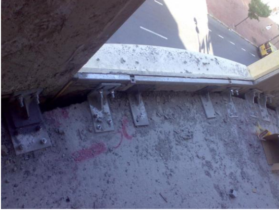
Şekil 6-10:Kaynaklı ve bulonlu sistemin uygulanması.
