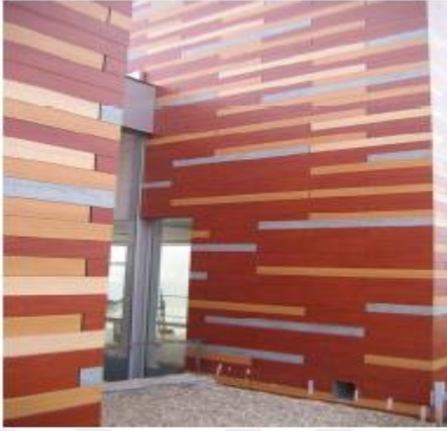
Şekil 6-33:Kompakt laminat giydirme
