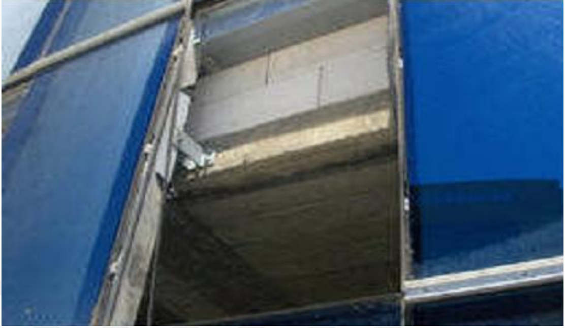
Şekil 6-7:Kaplama Elemanının montajı
