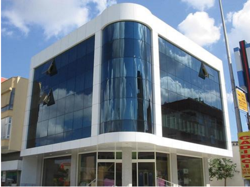
Şekil 3-5: Strüktürel silikon giydirme cephe
