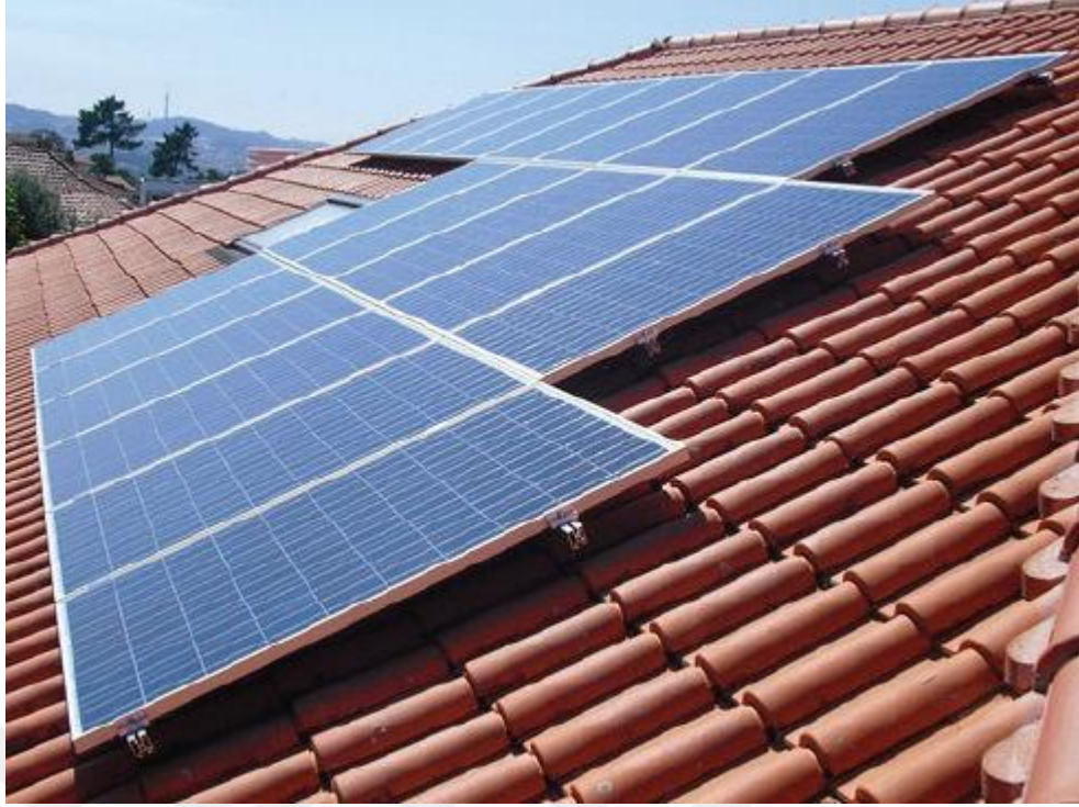
Şekil 4.17 Ek Taşıyıcı İle Çatı İle Bütünleşik Olan Fotovoltaik Paneller
