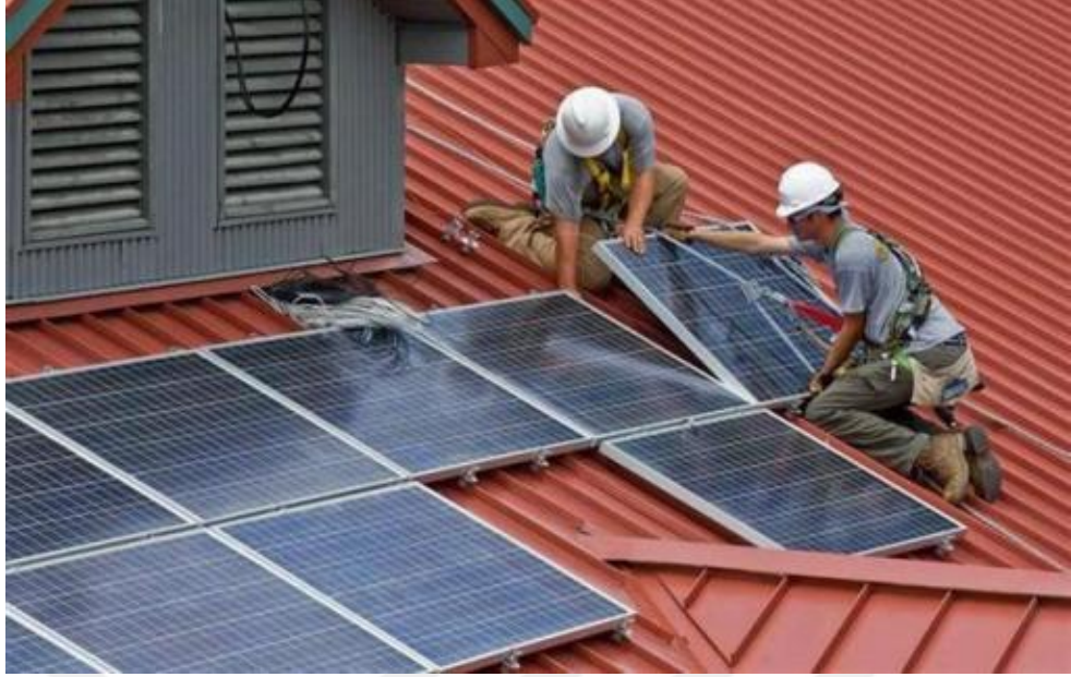
Şekil 2.21 Çerçevesiz Fotovoltaik Panellerin Çatıya Uygulanması
