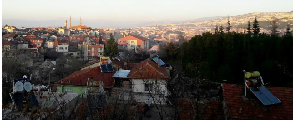
Şekil 5.4 Burdur ili Yerleşim Bölgesinde Çatıda Kullanılan Kollektörler
