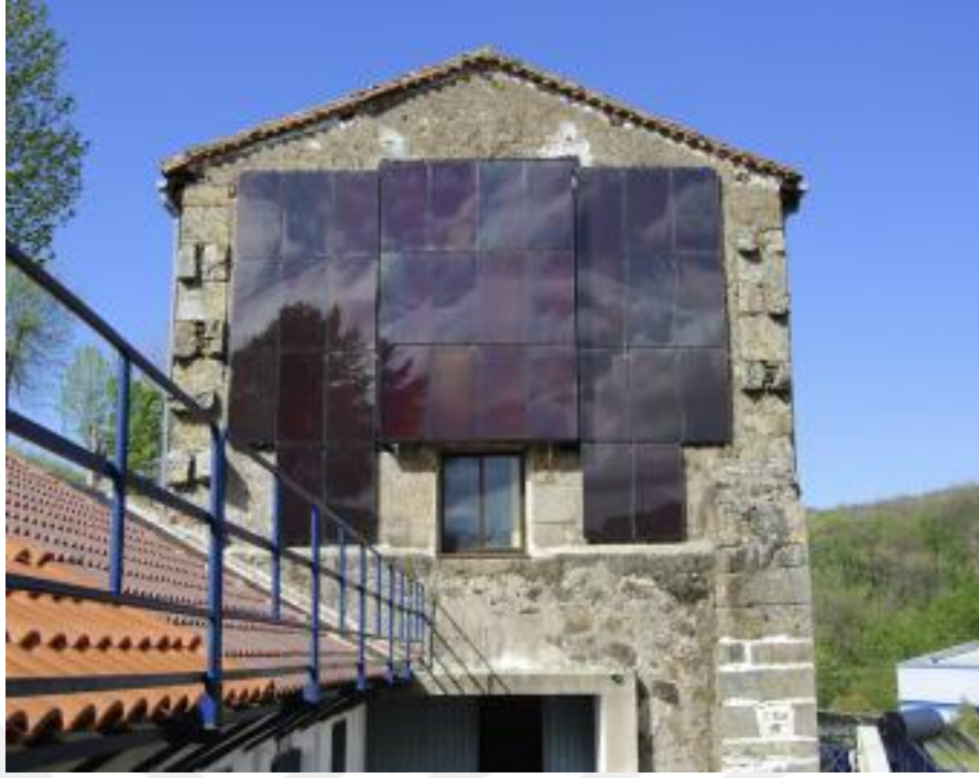
Şekil 2.24 Çerçevesiz Fotovoltaik Panellerin Cepheye Ek Strüktür İle Uygulanması
