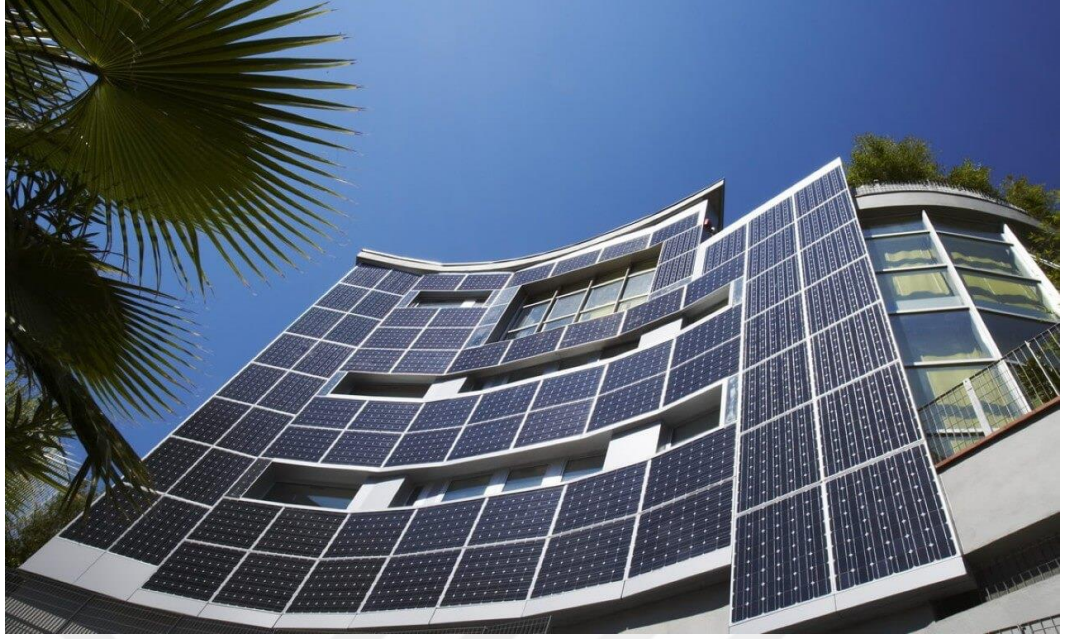
Kaynak: http://www.kranemfg.com/pv-glass-facades Şekil 2.26 Fotovoltaik Panellerin Cephede Uygulanması
