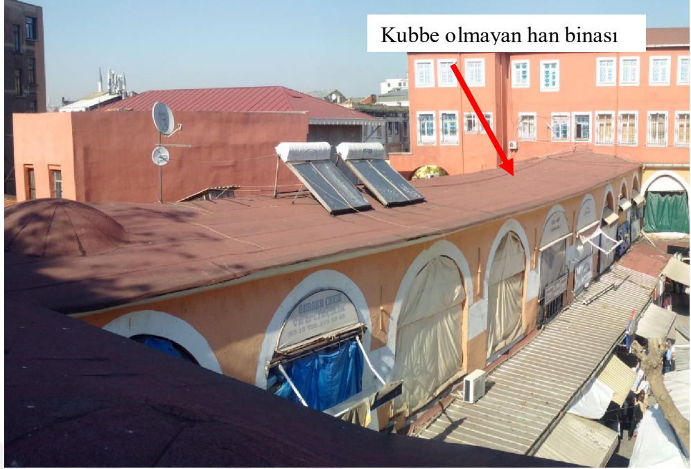
Fotoğraf 4.8.- İki Avlu Arası Bina Çatı Şekli Ve Örtüsü
