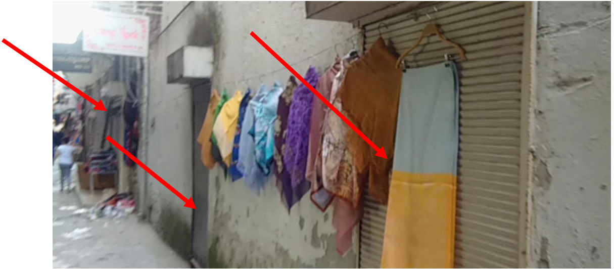
Fotoğraf 4.23.- Çarkçılar Sokak Cephesinde Kapı Açılarak Oluşturulmuş Dükkânlar
