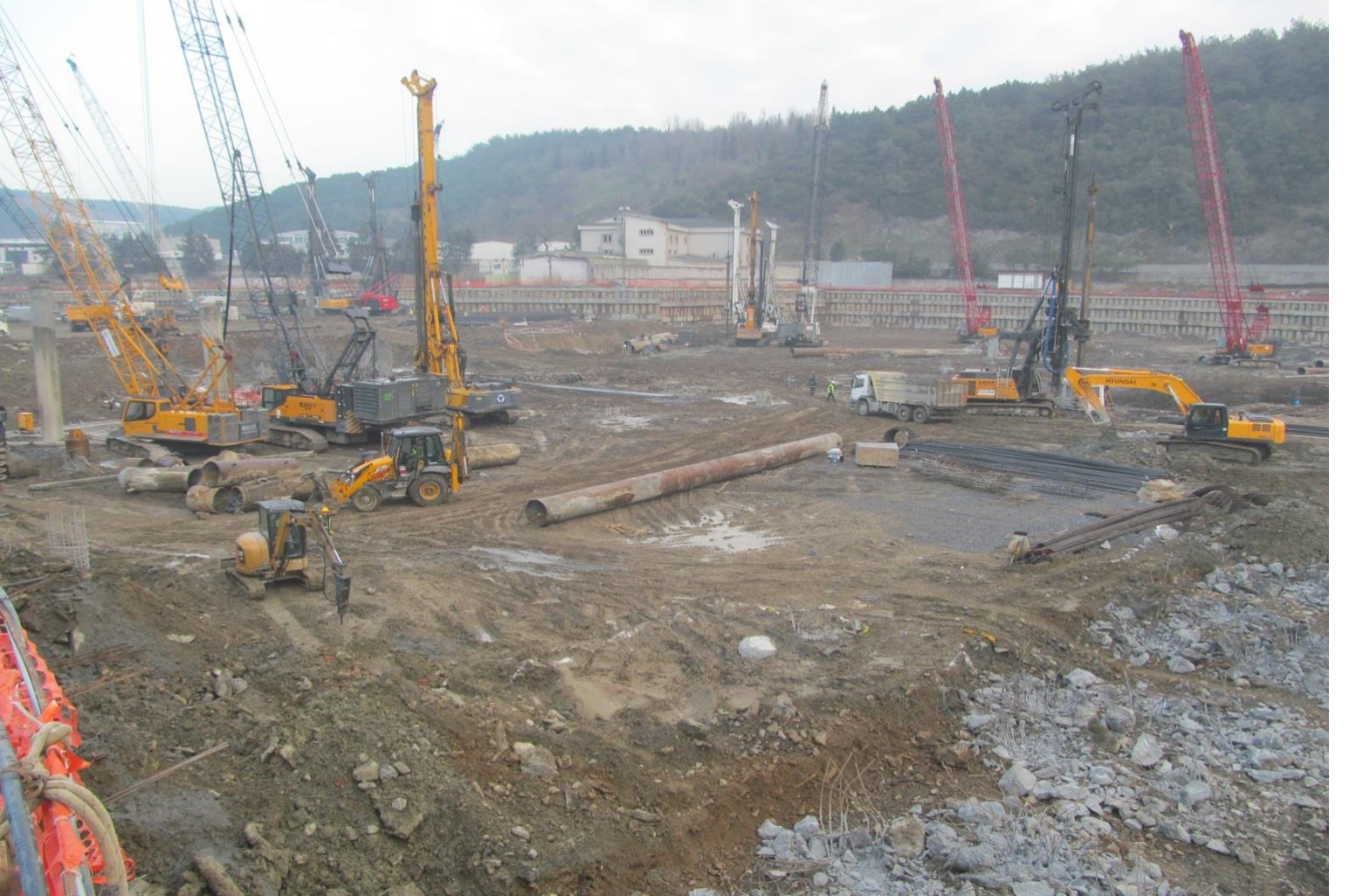
Resim 46 : Temel Altı Kazık İmalatları
