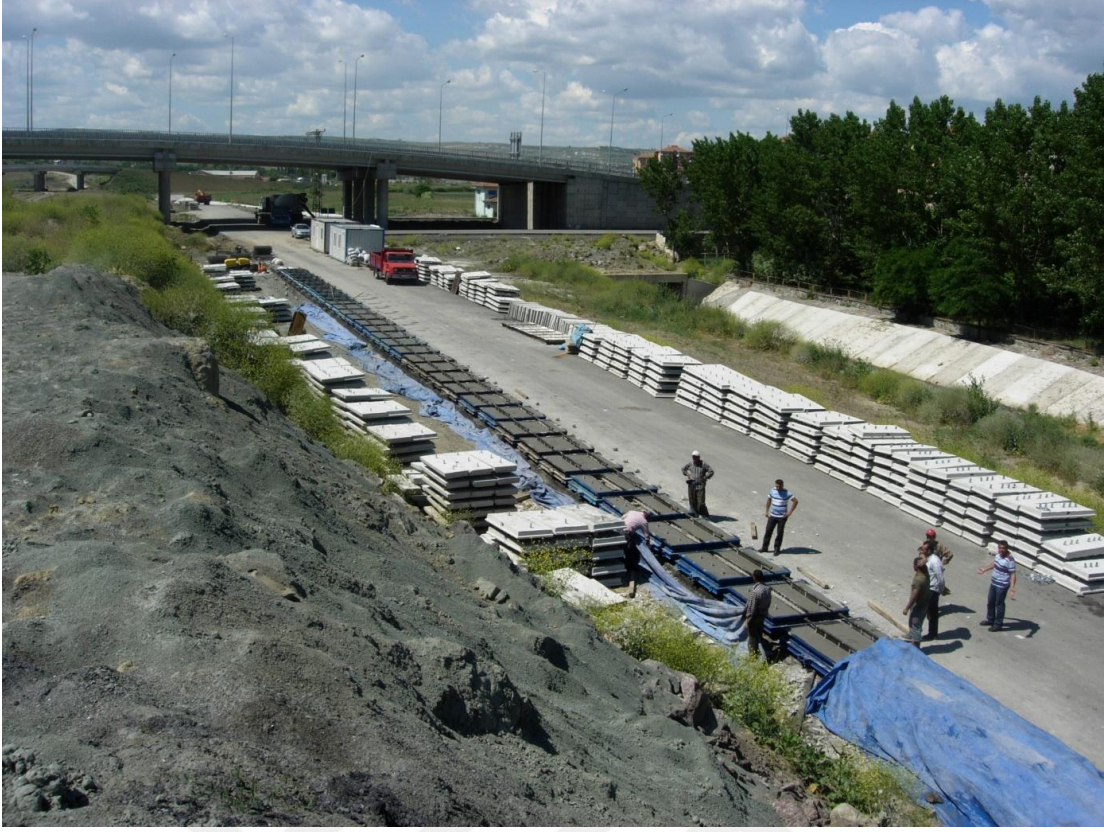
RESİM 3 Prekast Beton Panel Dökümü ve İstifi
