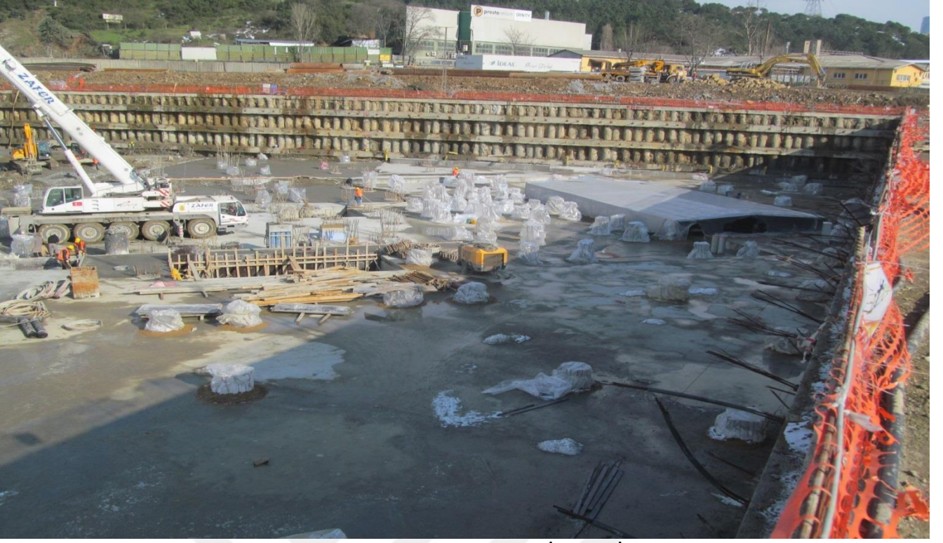
Resim 34: Grobeton Dökümü ve Kazık Başlıklarının Grout İmalatı İçin Hazırlanması
