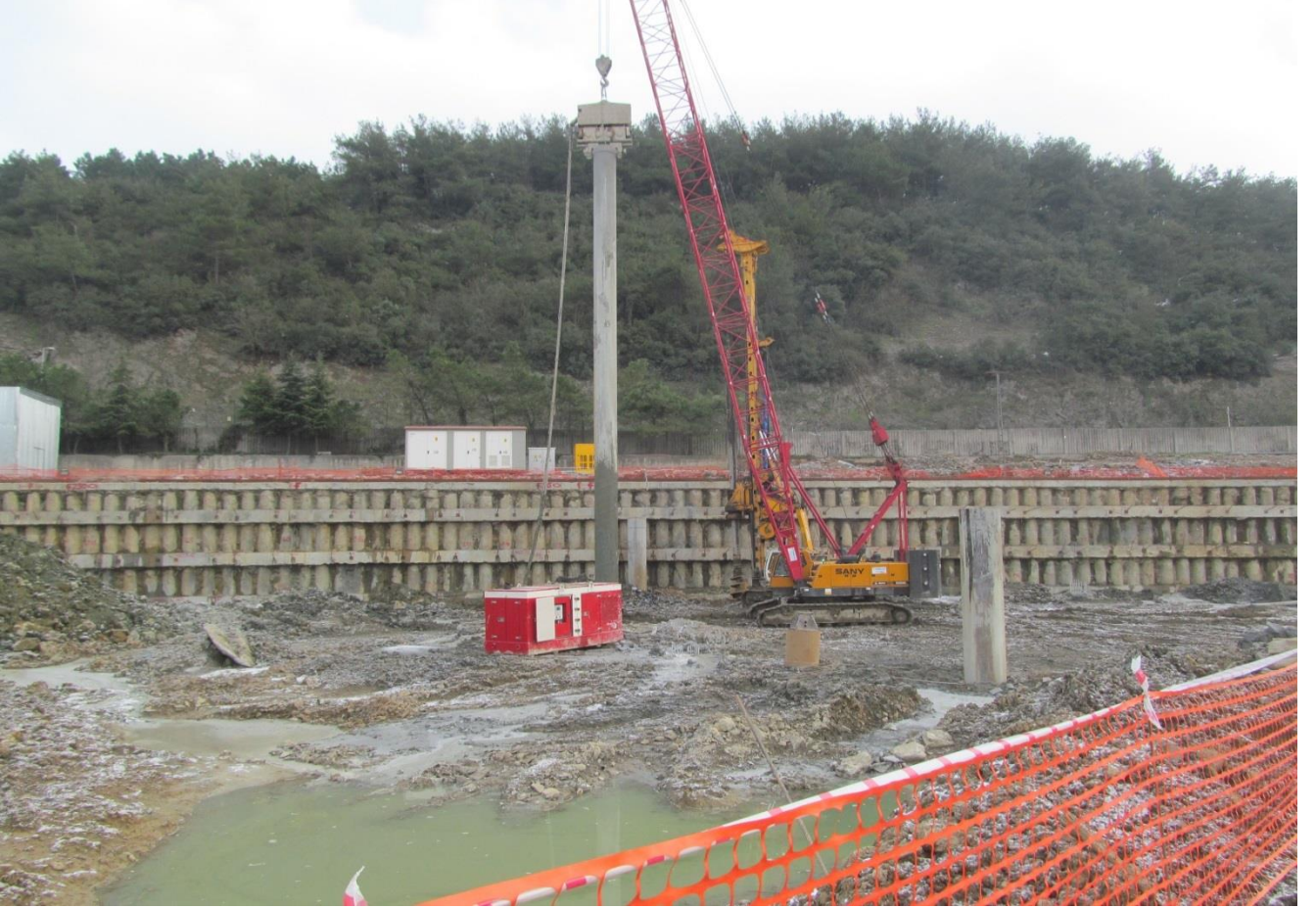
Resim 35: Temel Altı Kazık İmalatı Vibro ile Boru Çakılması
