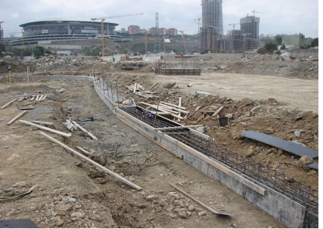
Resim 2: Başlık Kirişi Donatı İmalatı ve Kalıp İmalatı
