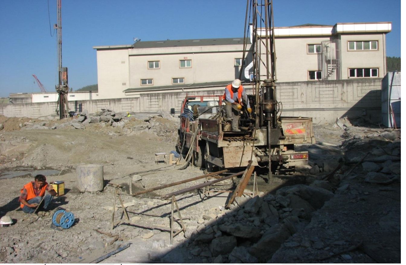
Resim 16: İnklinometre Delgi İmalatları
