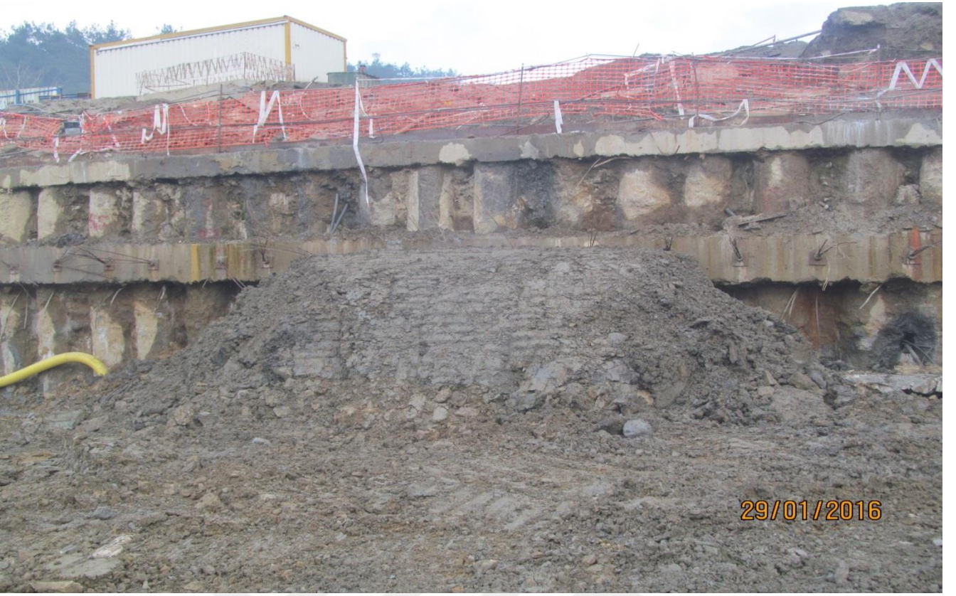
Resim 37: İnklinometre Verilerinin Analiz Edilmesi Sonucu Yapılan dolgu
