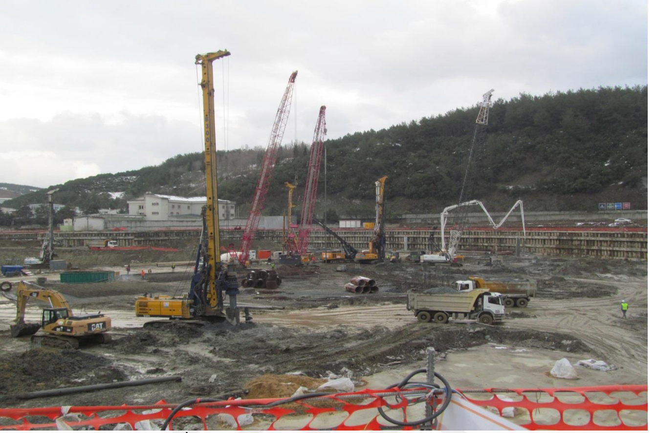
Resim 32 : Temel Altı Kazık İmalatları
