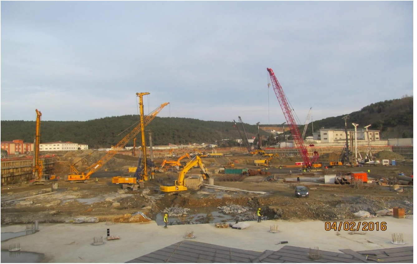
Resim 39 Temel Altı Kazık İmalatları
