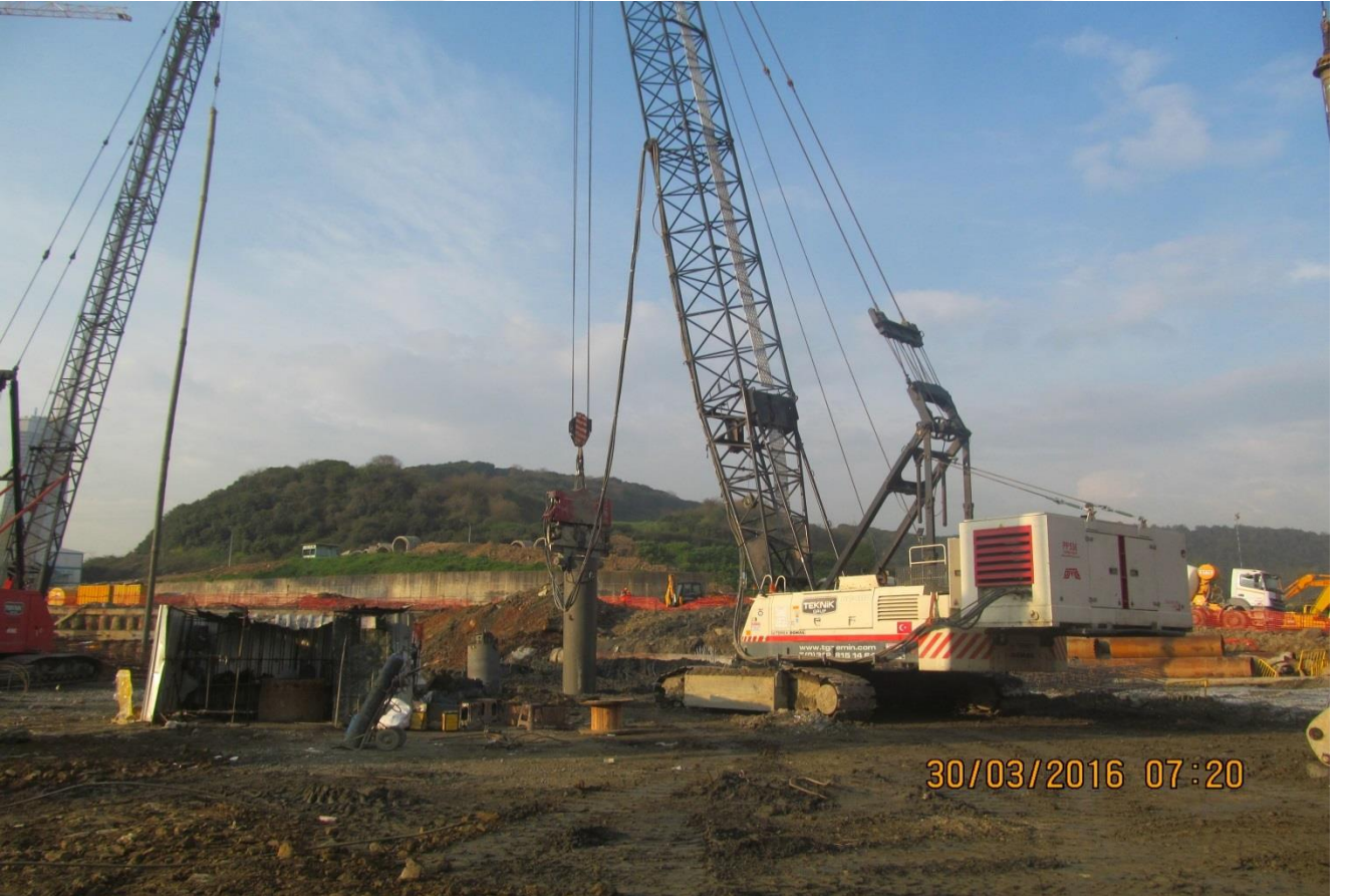
Resim 50 : Temel Altı Kazık İmalatları
