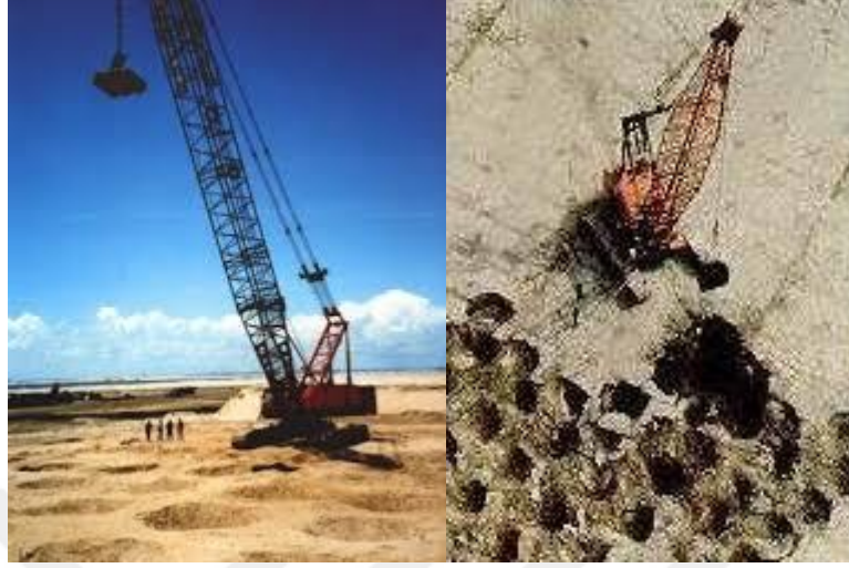
Şekil 2.6. Dinamik kompaksiyon uygulaması. ( http://keller-ge.co.uk/images/cms/DynamcCompB.jpg , http://kshitija.files.wordpress.com/2006/09/dynamiccomp.jpg ,
