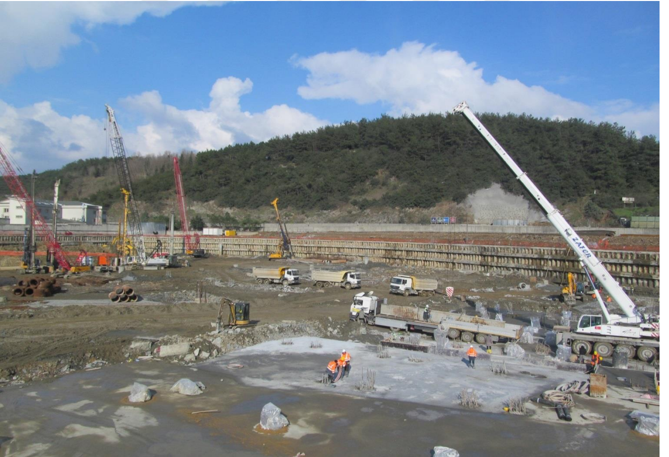
Resim 33 : Temel Altı Kazık İmalatları
