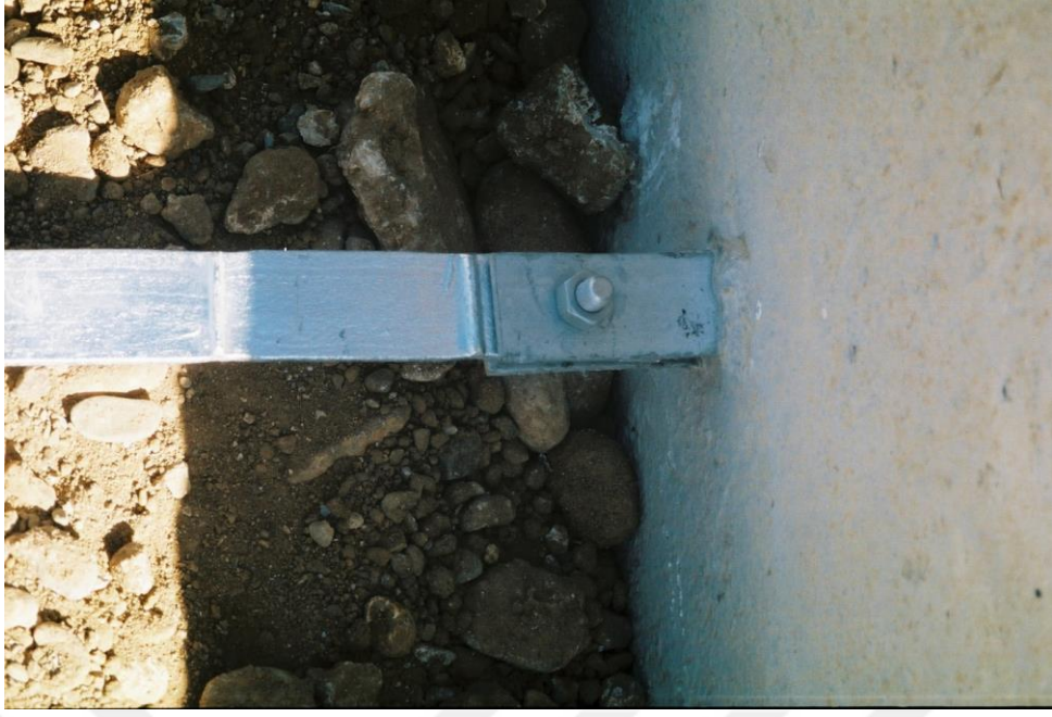
RESİM 2 Cıvata ile Bağlanmış Bağlantı Mandalı ve Çelik Donatı Şeridi
