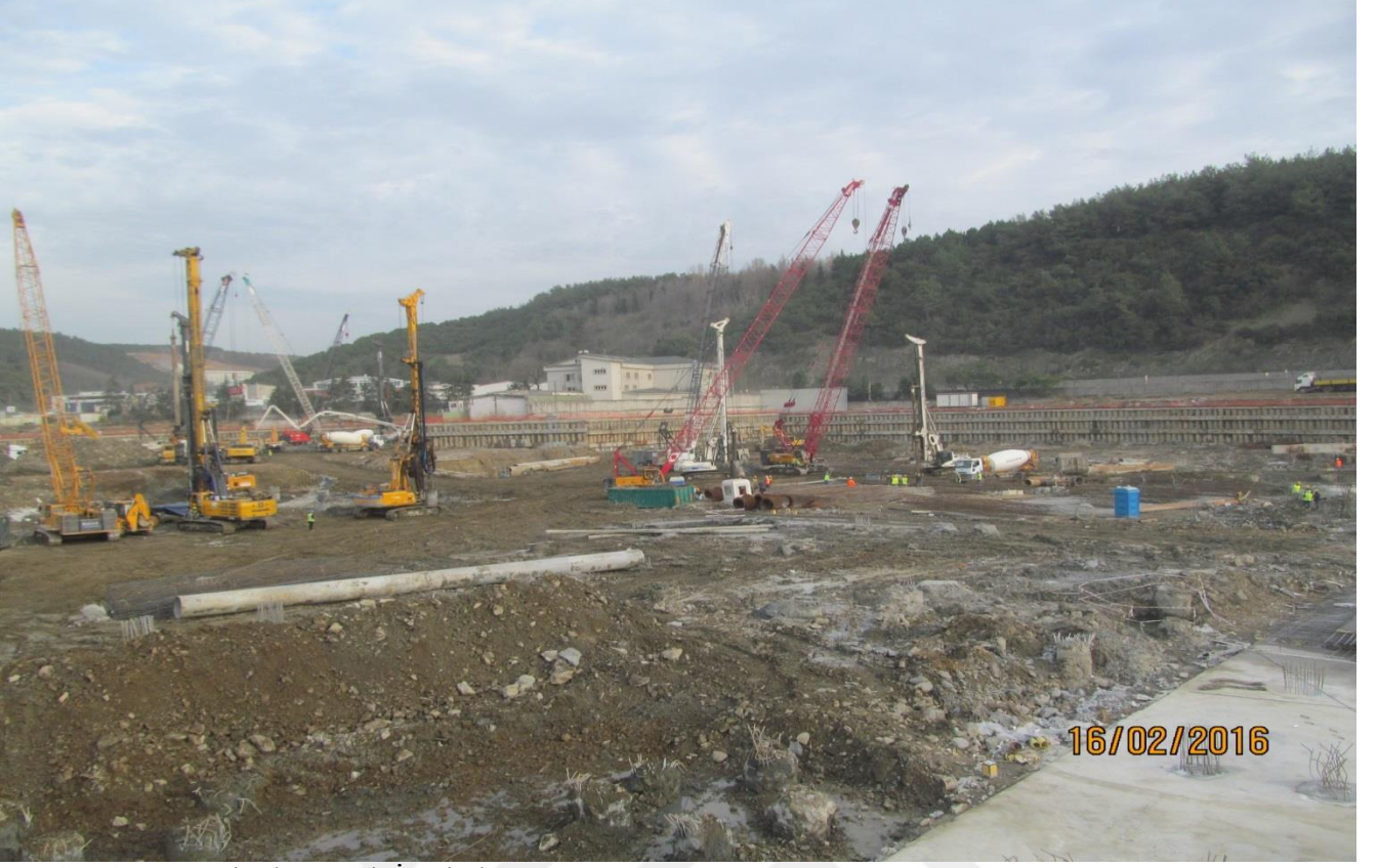
Resim 43 : Temel Altı Kazık İmalatları
