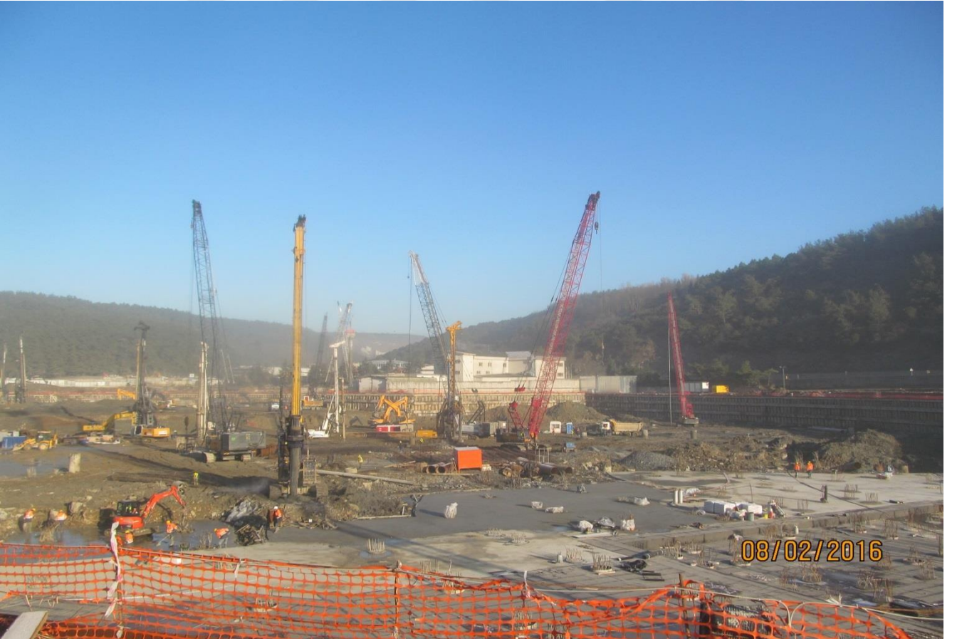
Resim 52 : Temel Altı Kazık İmalatları
