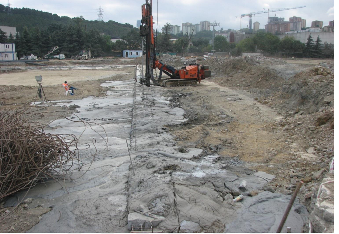
Resim 4: Kazık Arası Geçirimsizlik Jet Uygulaması
