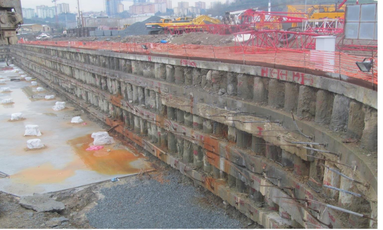
Resim 28: 3 Kademe Ankraj Kuşağının Açıldığı ve İlave Yapılan Ankraj Kusakları
