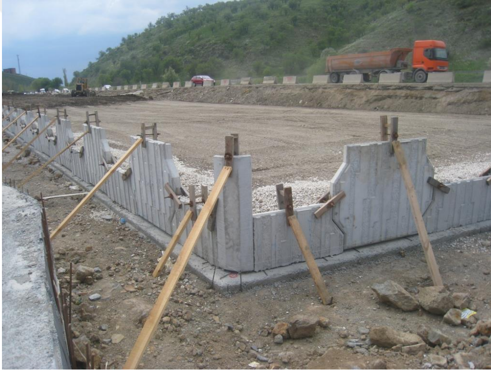
RESİM 6 İlk Sıra Panellerin Yerleştirilmesi
