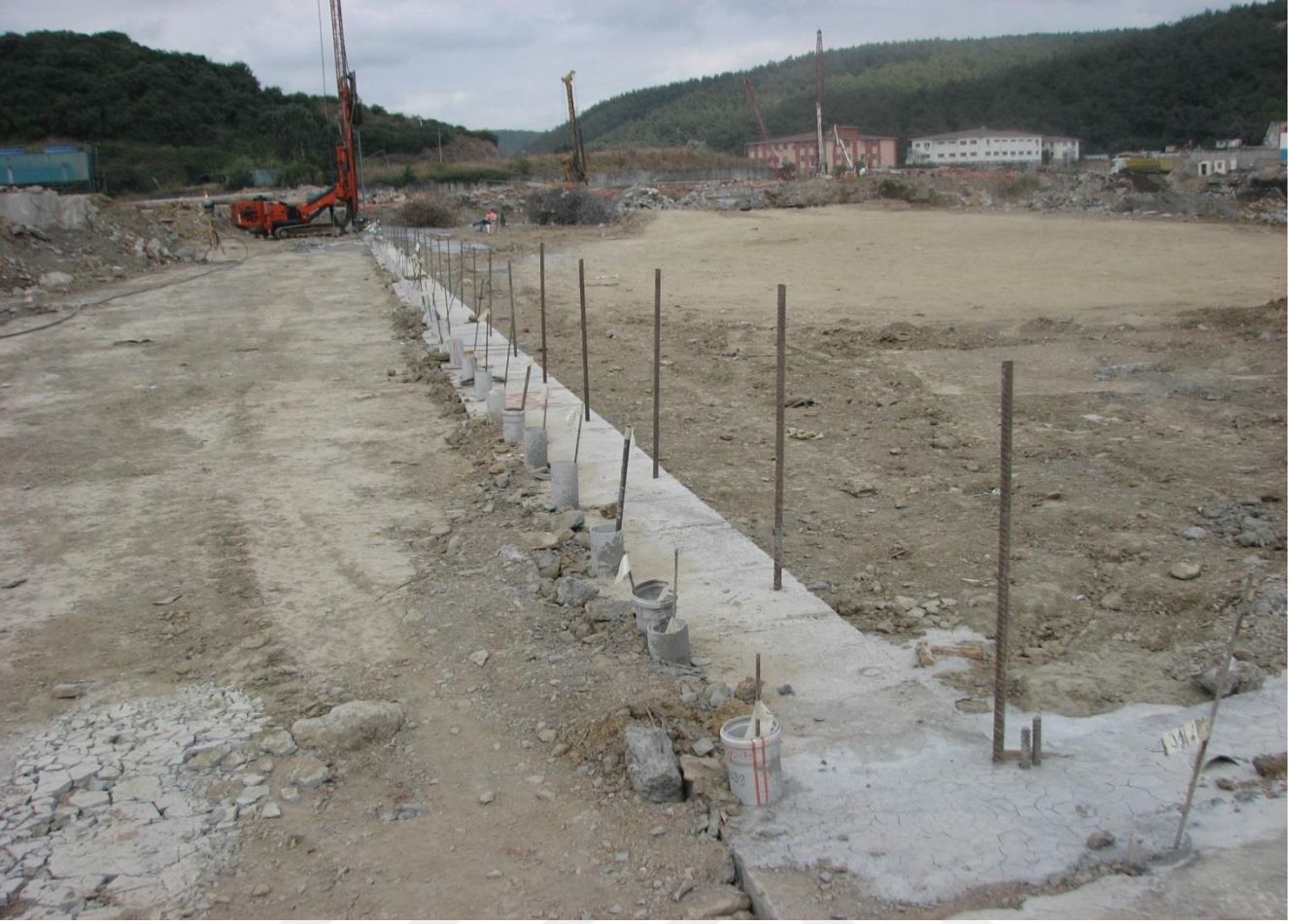
Resim 6: Kazık Arası Geçirimsizlik Jet Uygulaması
