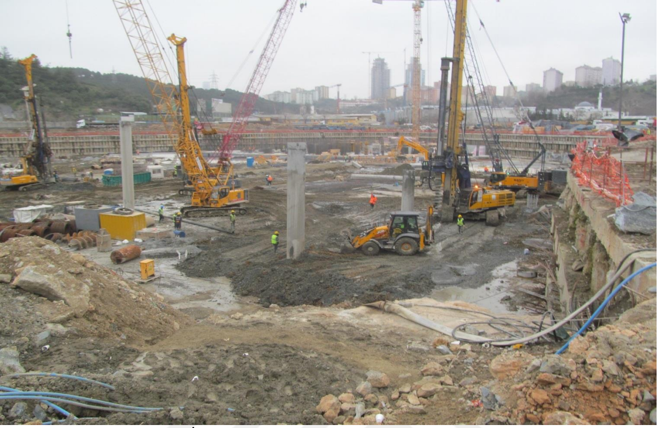
Resim 45 : Temel Altı Kazık İmalatları
