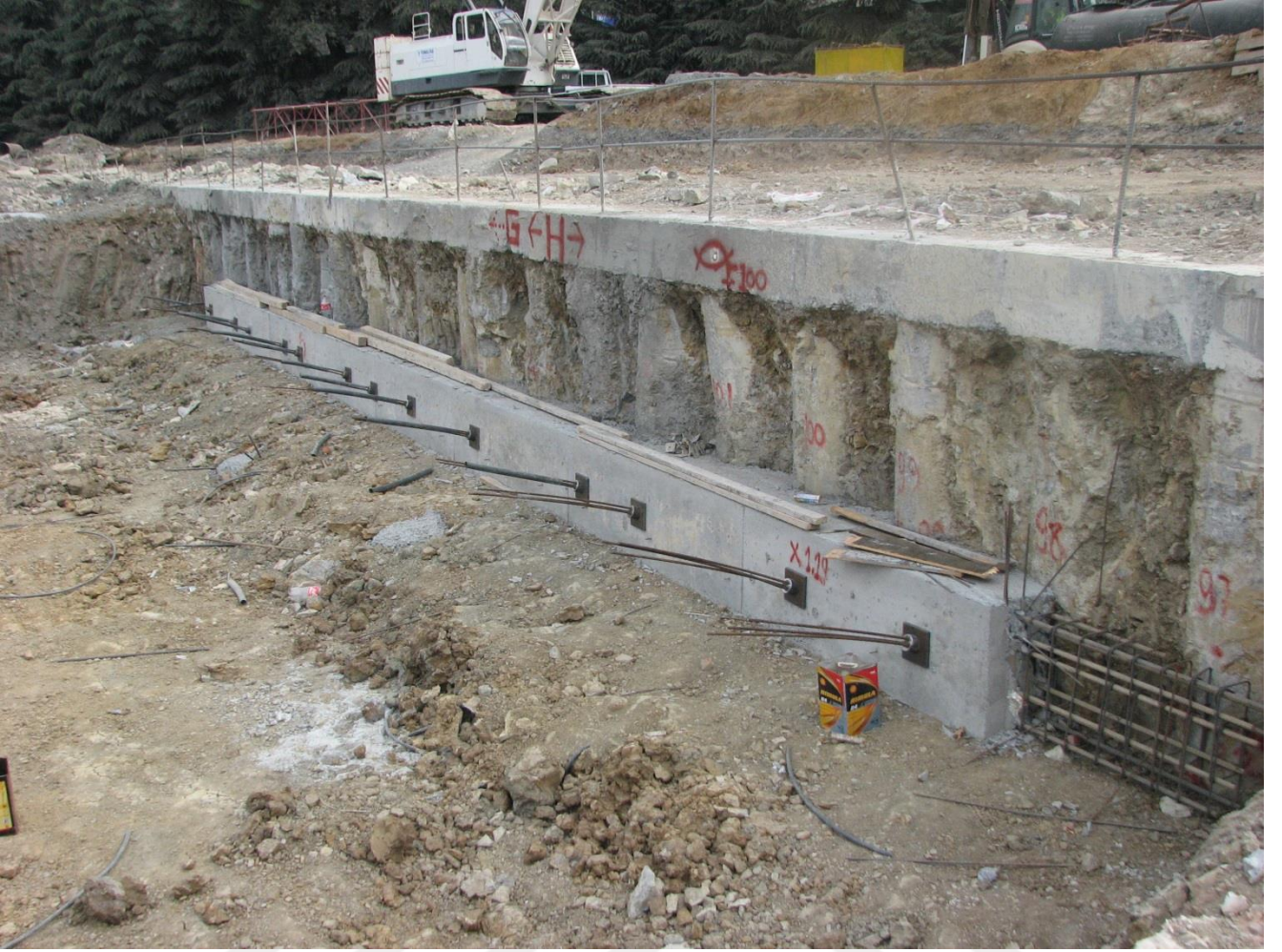
Resim 8: 1. Kademe Kuşak Kirişi ve Ankraj Germelerinin Tamamlaması
