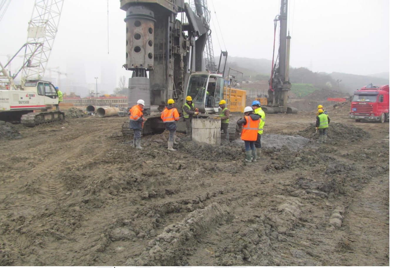
Resim 49 : Temel Altı Kazık İmalatları Kazık Teslimi
