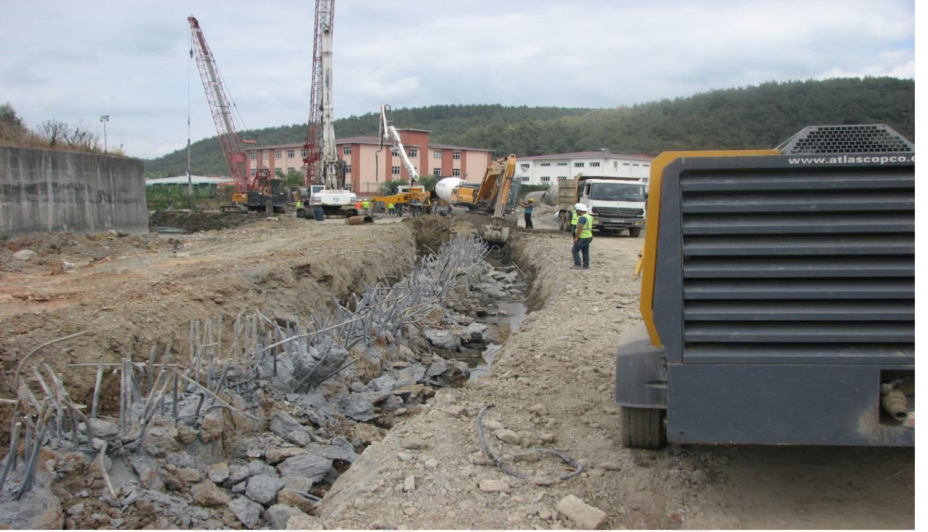
Resim 1: İksa Kazık İmalatının Tamamlanmasının Ardından Kazık Etrafının Açılması ve Kırım Yapılması
