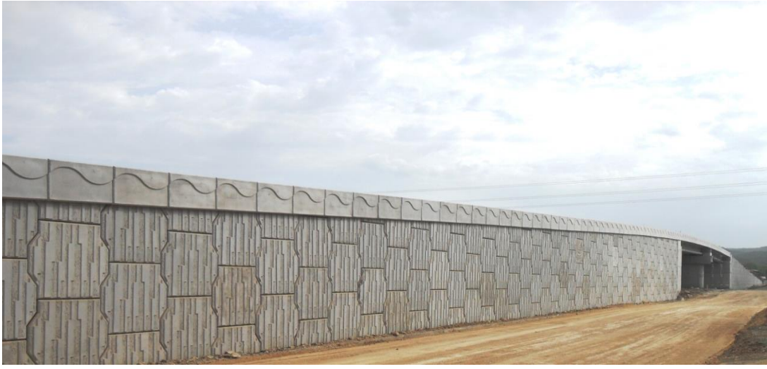
RESİM 10 HarpuŒtaları konmuŒ ve tamamlanmıŒ duvar
