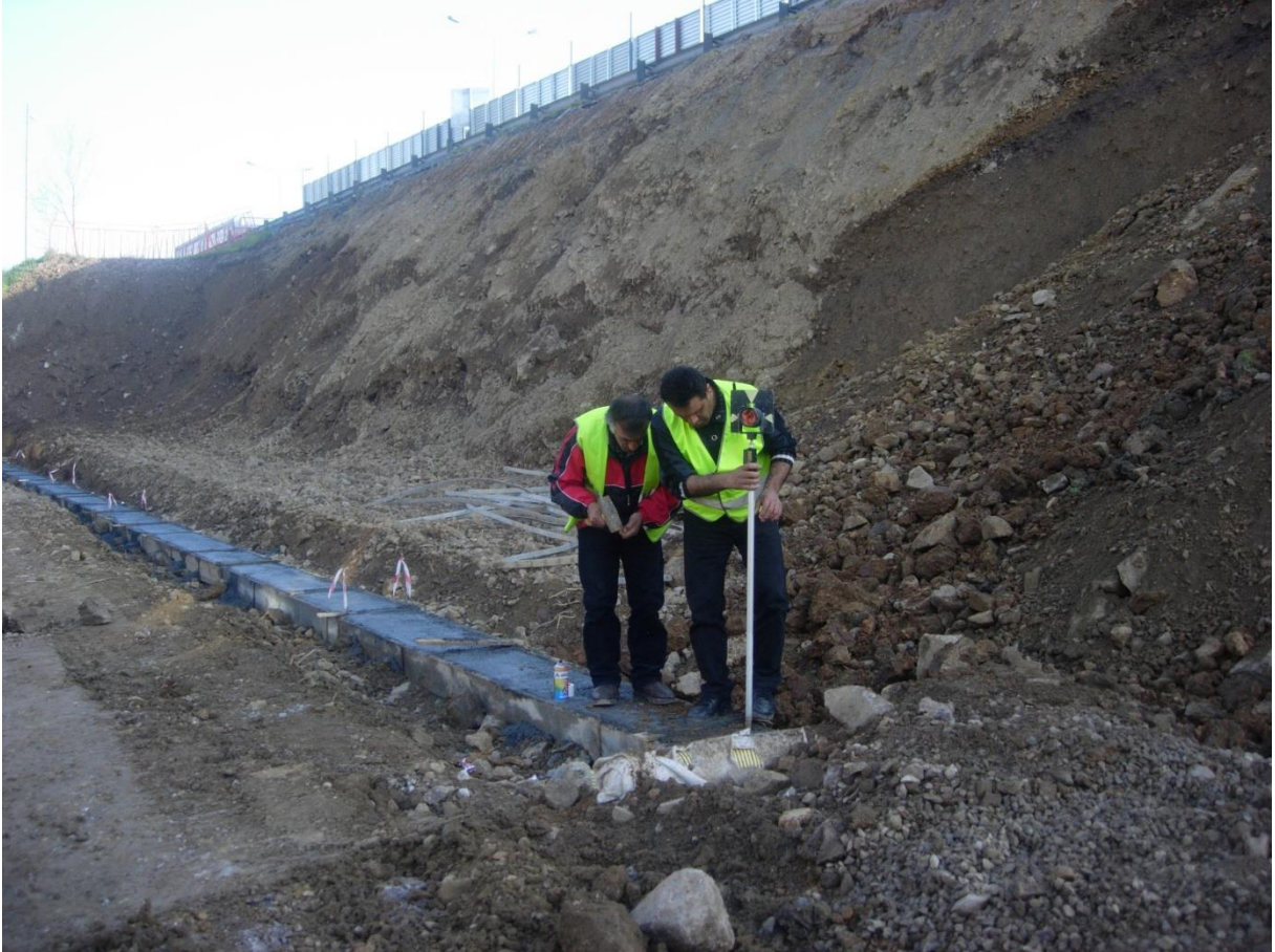
RESİM 4 Tesviye Betonu İmalatı
