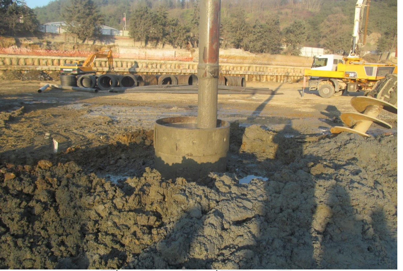
Resim 51 : Temel Altı Kazık İmalatları Tremie Borusu İle Beton Dökümü
