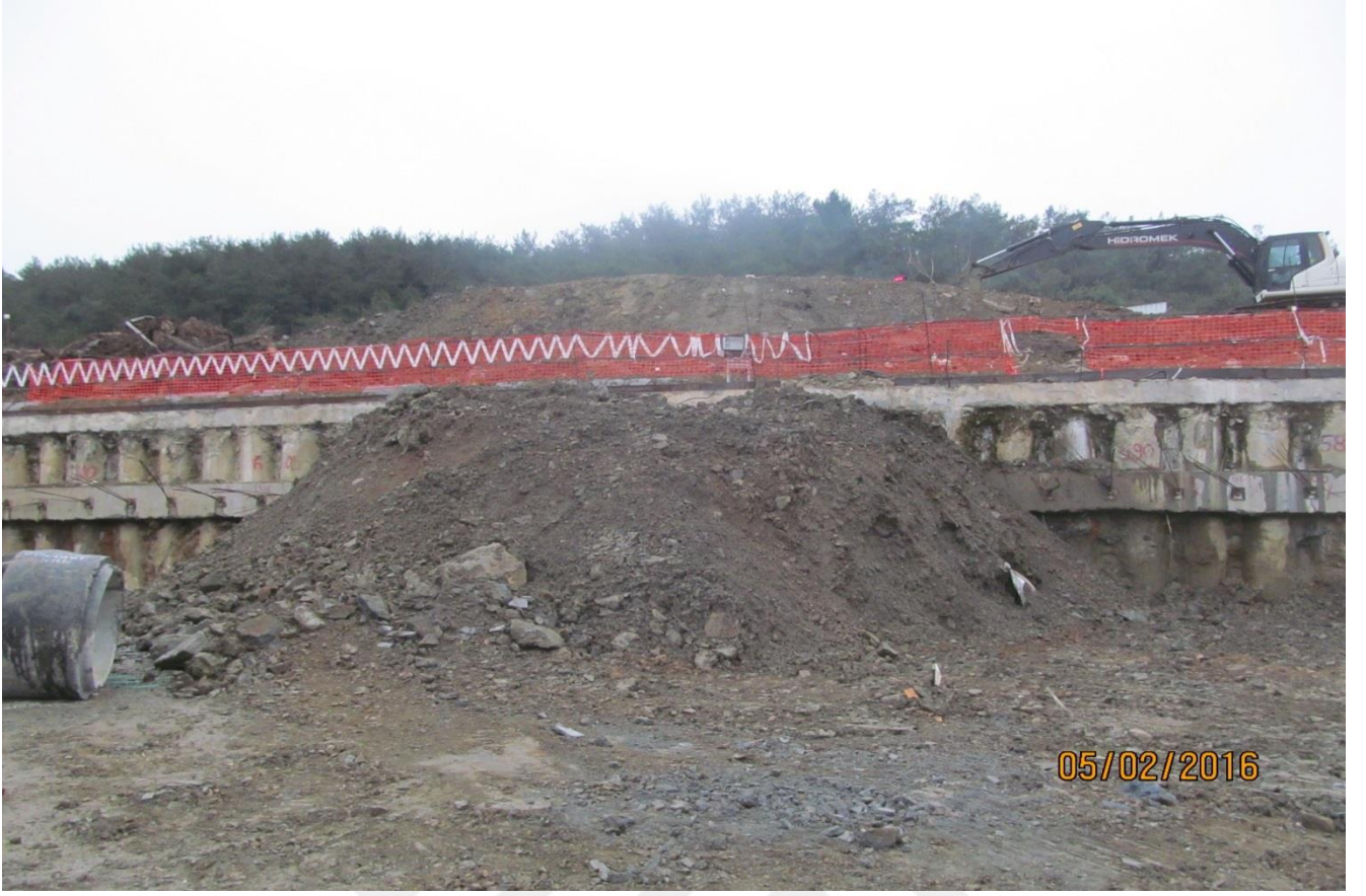
Resim 41: İnklinometre Verilerinin Analiz Edilmesi Sonucu Yapılan dolgu
