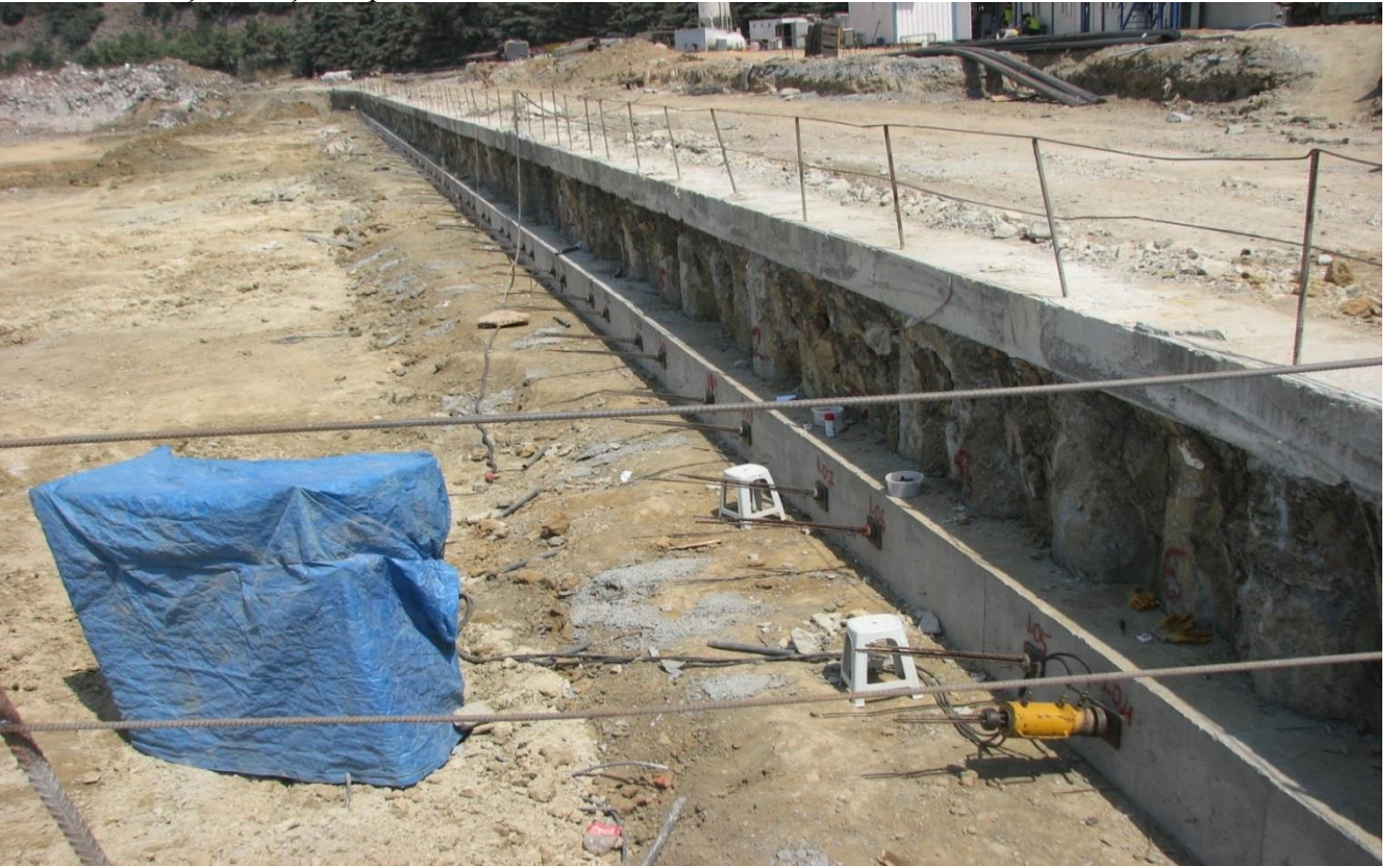
Resim 11: Kuşak Kirişi Tamamlanan 1. Kademe Ankrajların Germe İşlemleri
