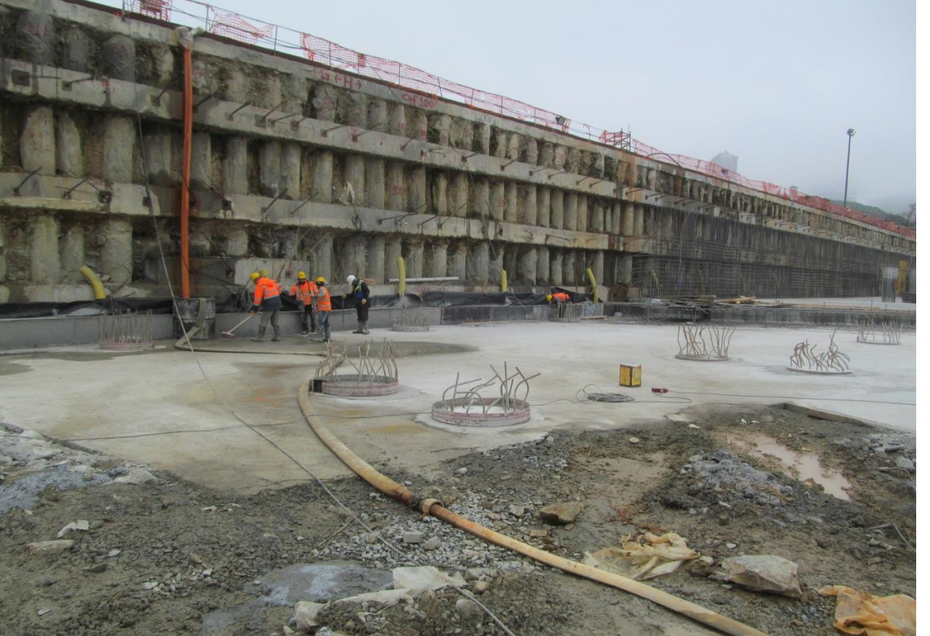
Resim 44 : Temel Kazı Kotuna Kadar İndirilen Baca İmalatı
