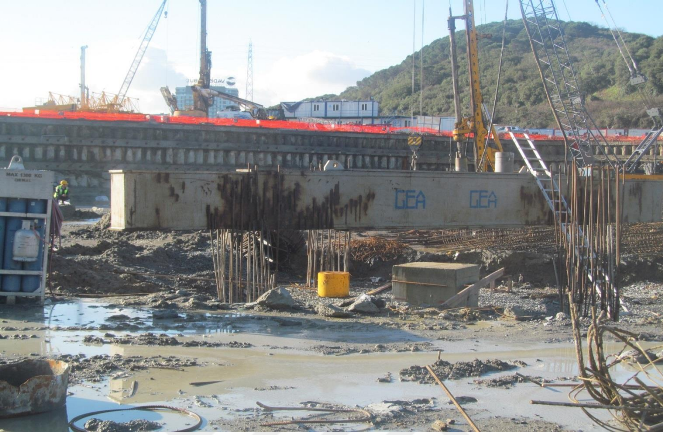
Resim 30: K 78 nolu Podium Kazığı Eksenel Statik Basınç Yükleme Deney Düzeneđi
