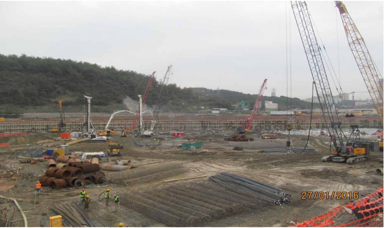
Resim 36: Temel Altı Kazık İmatlarında Kullanılacak Demir Donatının Hazırlanması
