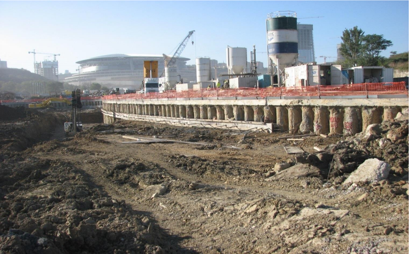
Resim 15: Jet grout Enjeksiyonu Çimento Siloları ve Enjeksiyon Santrali
