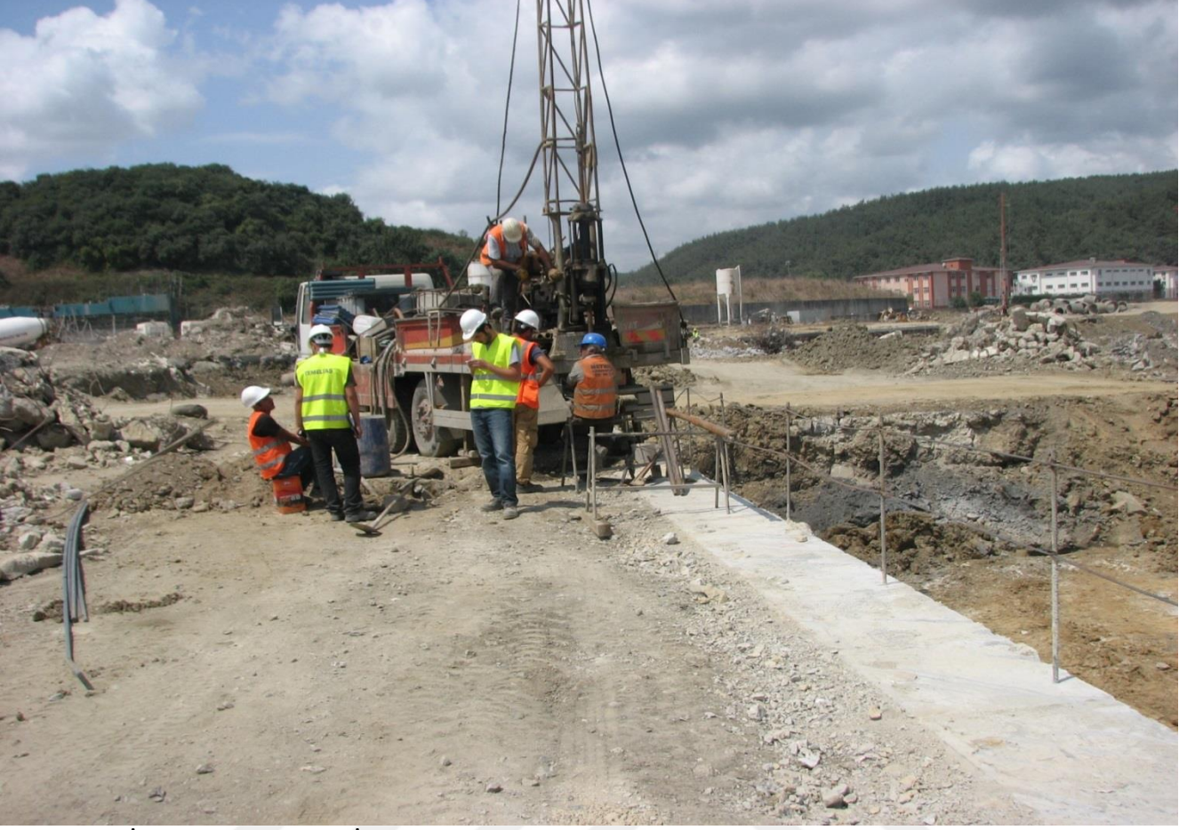
Resim 12: İnklinometre Delgi İmalatları
