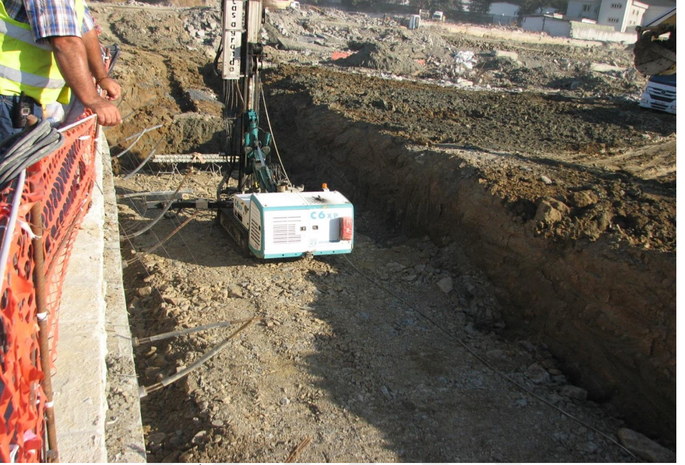
Resim 14: 2. Kademe Ankraj İmalatı ve Delgi Platformunun Oluşturulması
