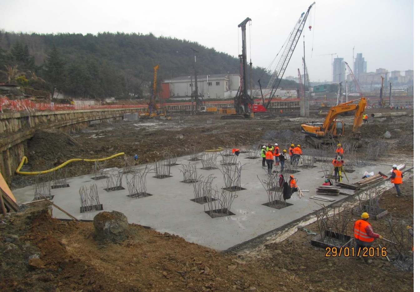
Resim 37: Temel Altı Kazıkların Blok Temeline Teslimi
