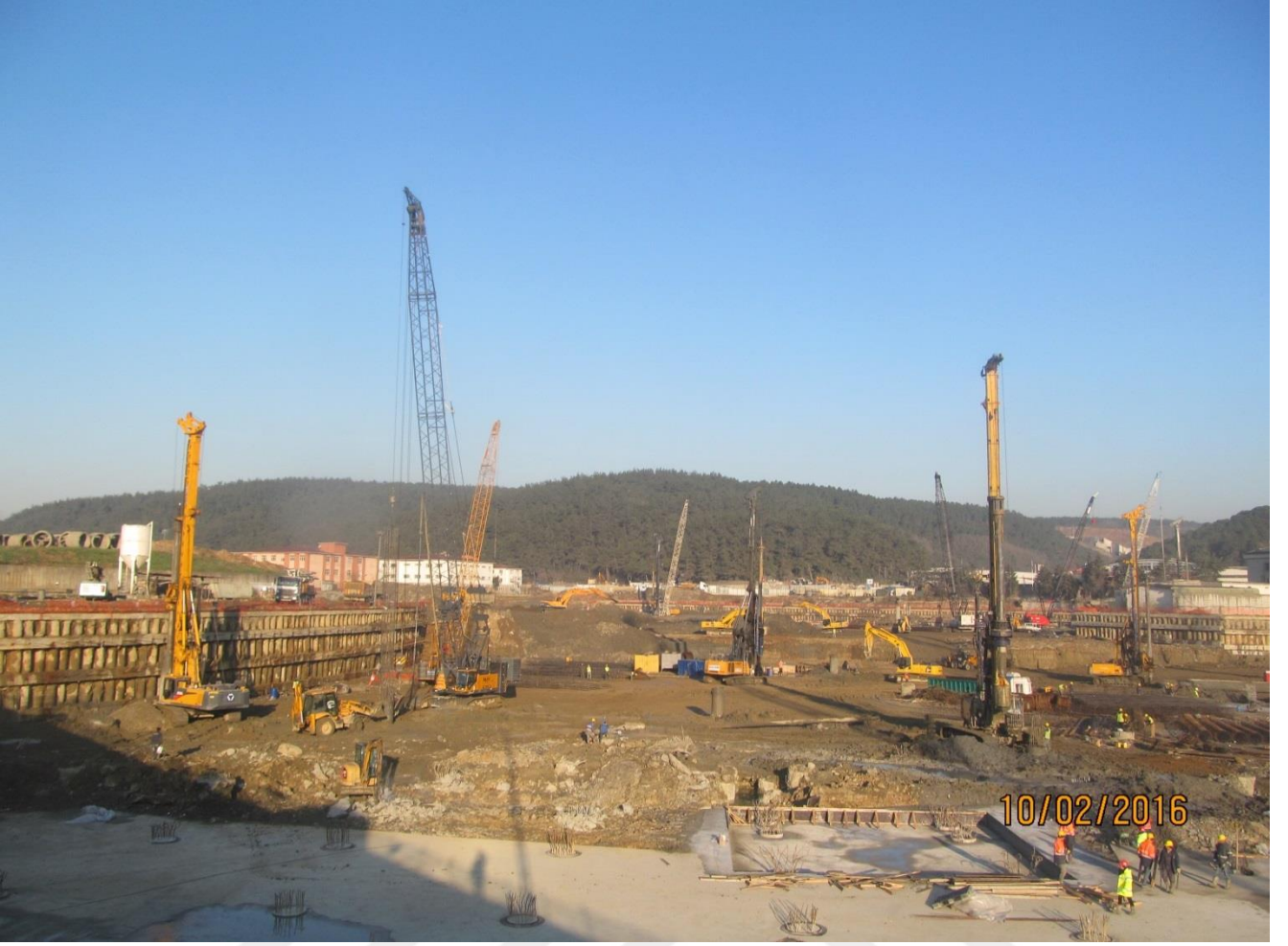
Resim 53 :Temel Altı Kazık İmalatları
