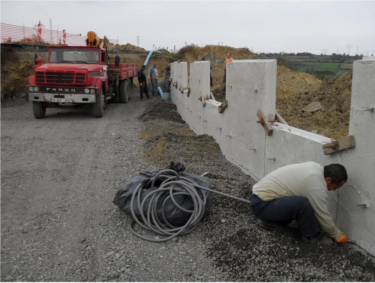
RESİM 7 Prekast Elemanlar Arasındaki Düşey ve Yatay Derzlerin 25 mm Kapalı Hücre Derz Dolgu Fitilleri ile Doldurulması
