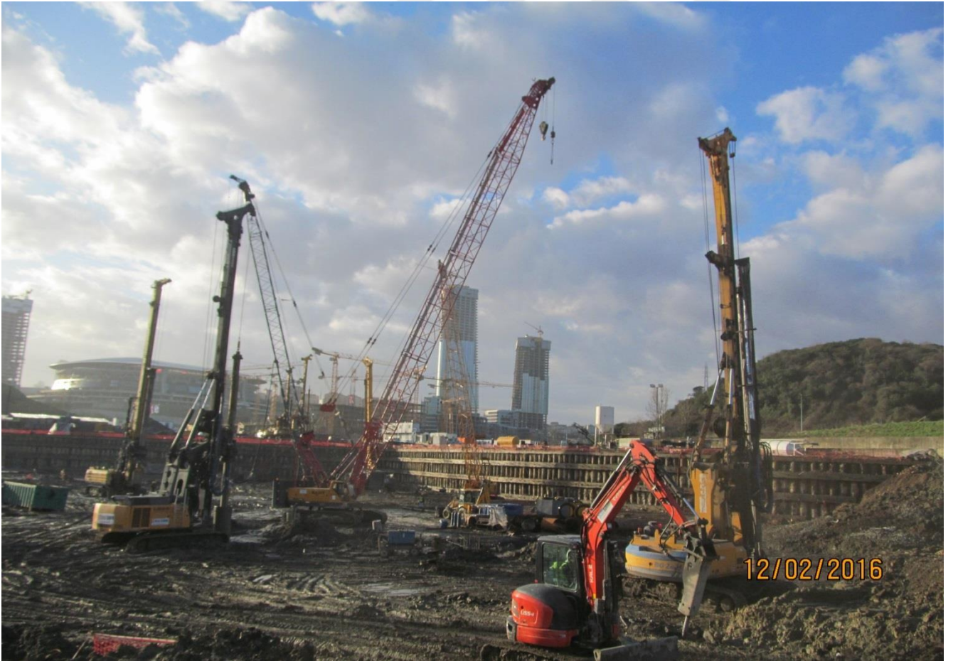
Resim 42 : Temel Altı Kazık İmalatları
