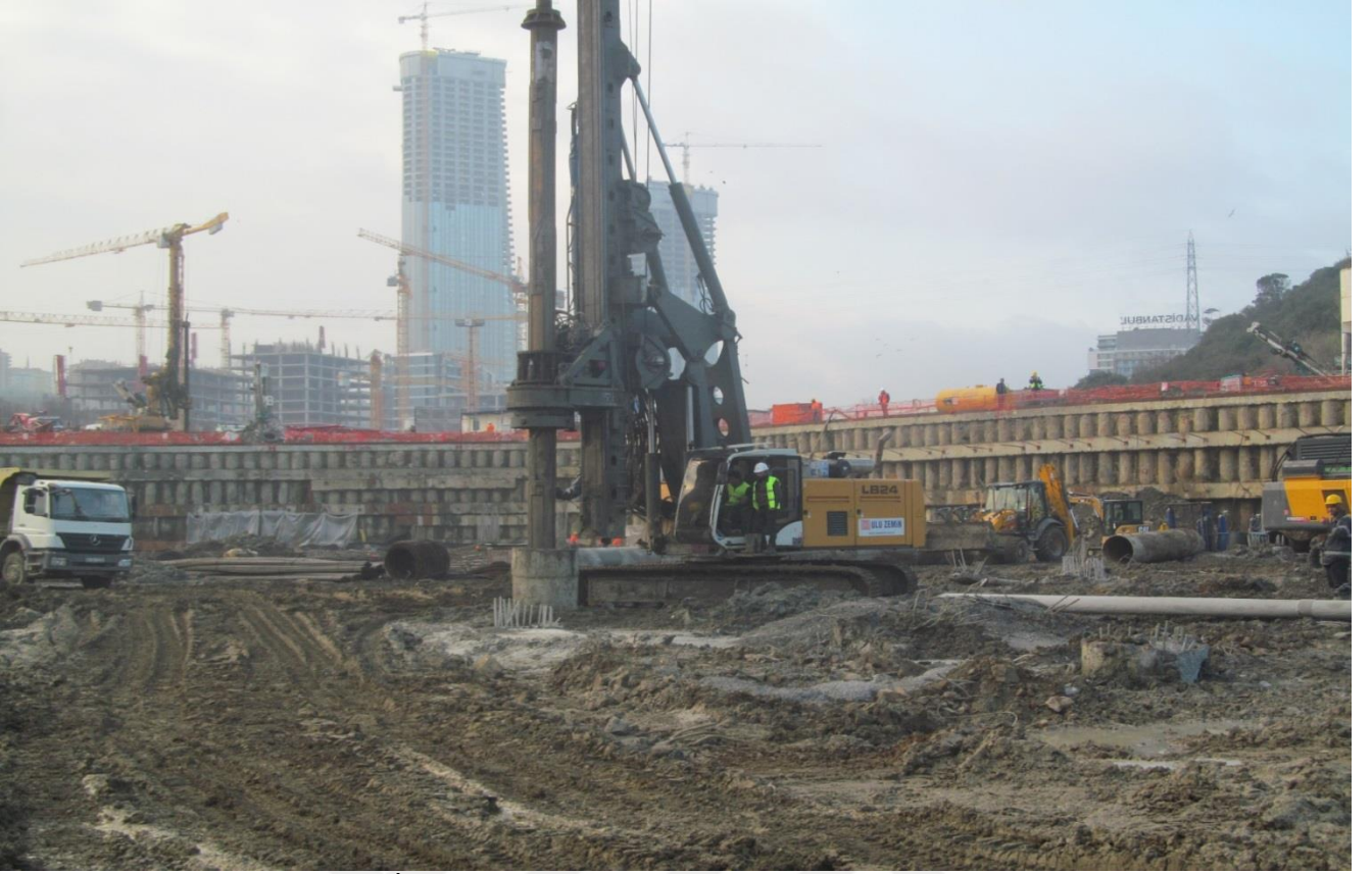
Resim 47 : Temel Altı Kazık İmalatları
