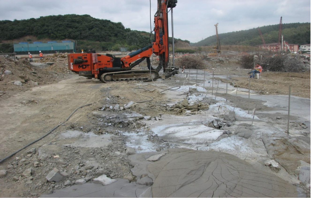
Resim 5: Kazık Arası Geçirimsizlik Jet Uygulaması
