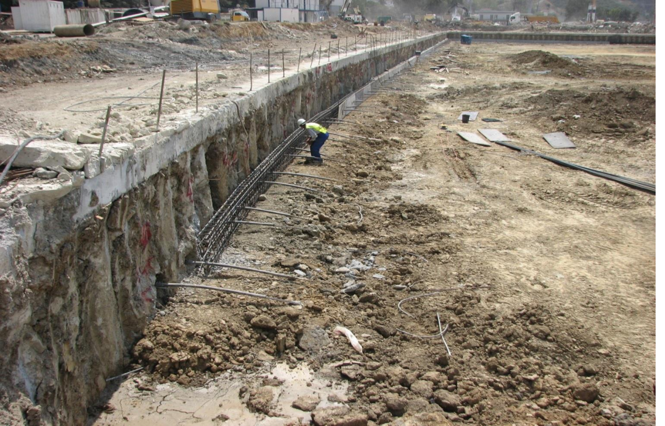
Resim 13: 1.Kademe Ankaraj Kuşak Kirişi Tesviyesi ve Donatı İmalatı
