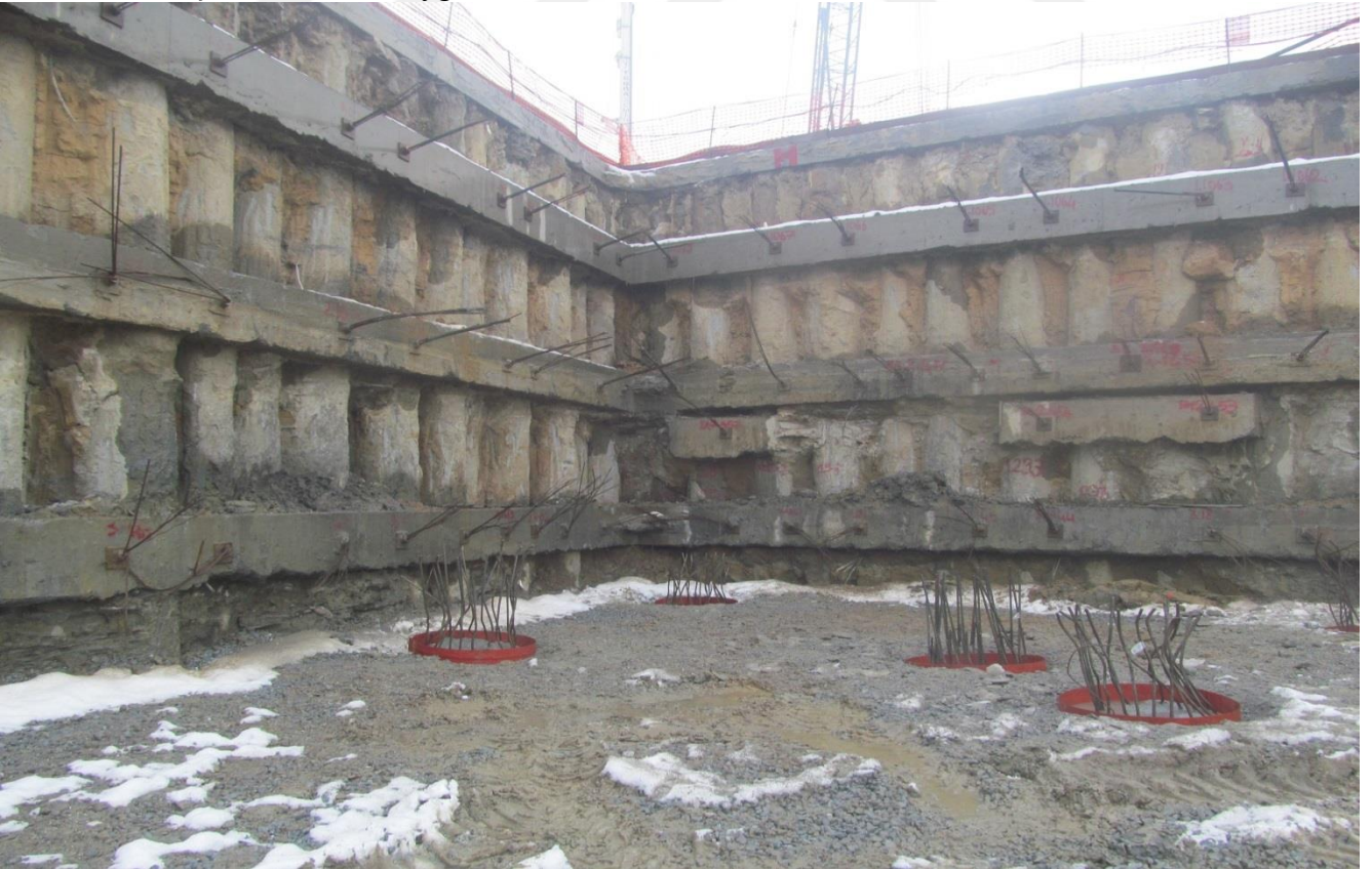
Resim 27: Temel Altı Kazıklarının Grout Dökümü İçin Hazırlanması
