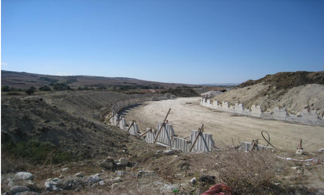
RESİM 5 İlk Sıra Prekast Panellerin Sabitlenmesi
