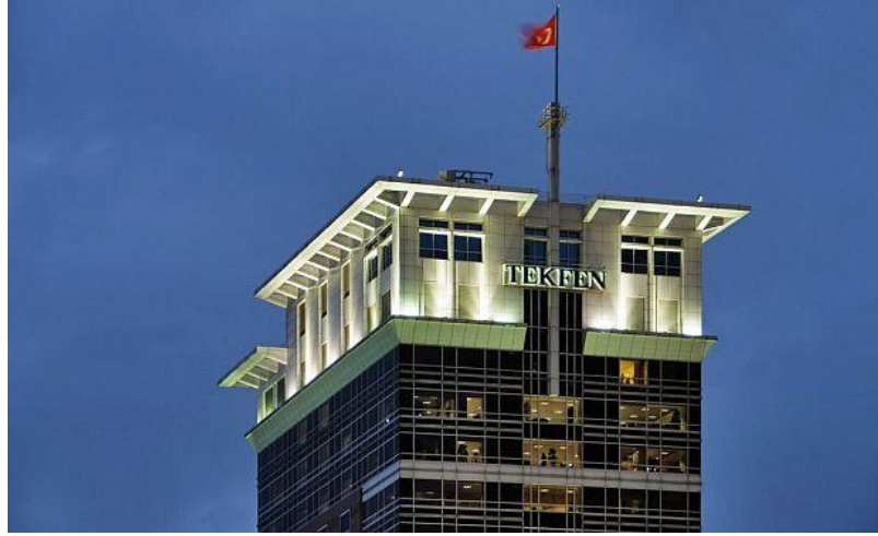
Resim 5.15. Tekfen Tower Yangın Sistemi
