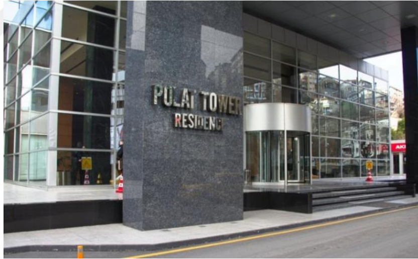
Resim 5.10. Polat Tower Girişi
