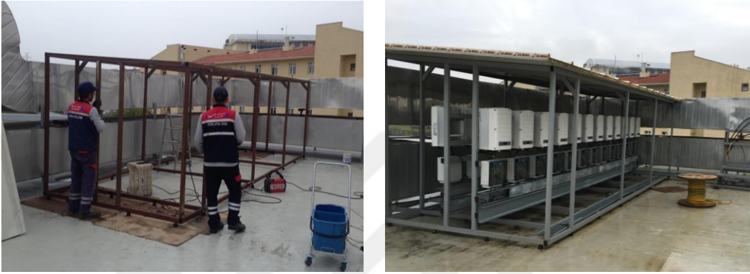
Şekil 4.7. İnverter kabinine ait görseller
