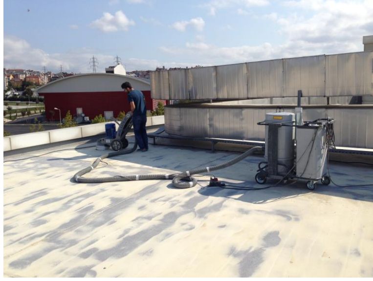
Şekil 4.8. İzolasyon öncesi zemin temizleme çalışması
