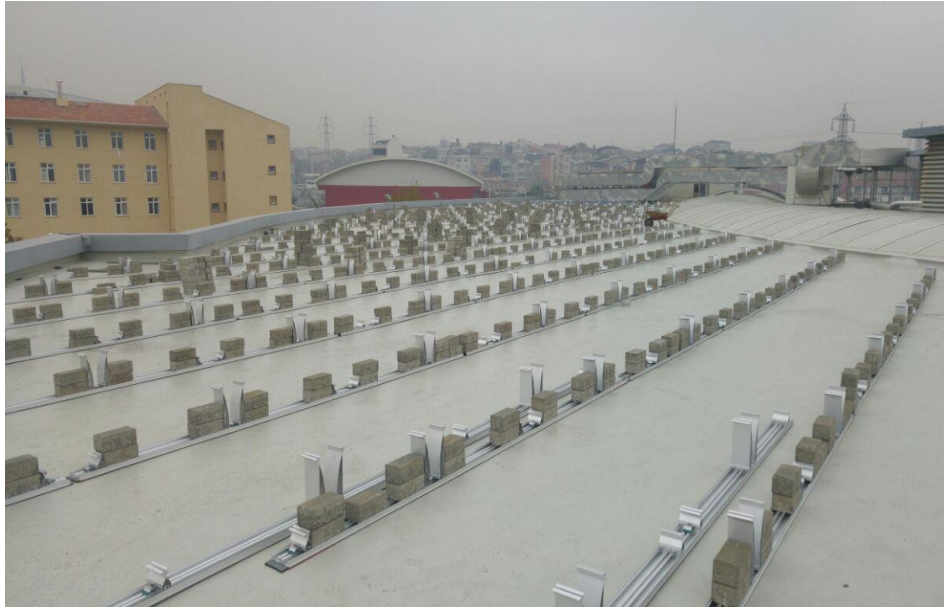
Şekil 4.11. Panel taşıyıcı konstrüksiyon ve balast betonu
