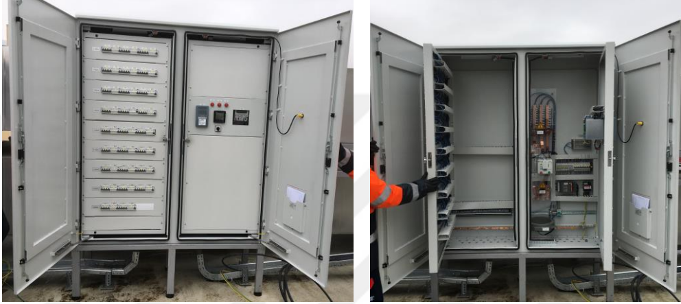
Şekil 4.13. AG pano ön ve iç görünüşü
