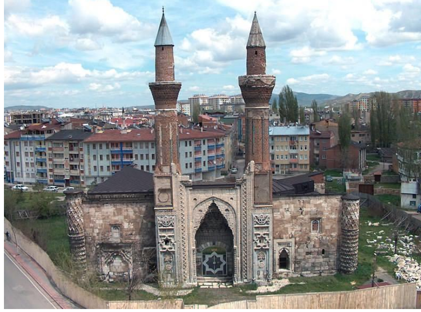
Şekil 2.20.: Sivas Gök Medresesi Taç Kapısı
