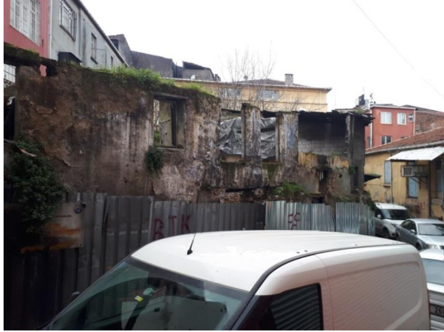
Şekil 4.25.: Kepekçi Sinan Medresesi Sokaktan Görünüm
