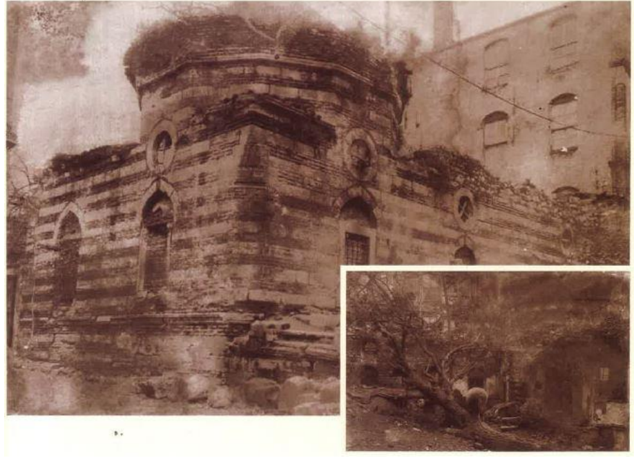
Şekil 4.3.: Kepekçi Sinan Medresesi Sokaktan Görünüm
