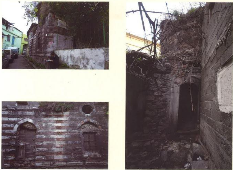
Şekil 4.6.: Kepekçi Sinan Medresesi Sokaktan ve Avludan Görünüm
