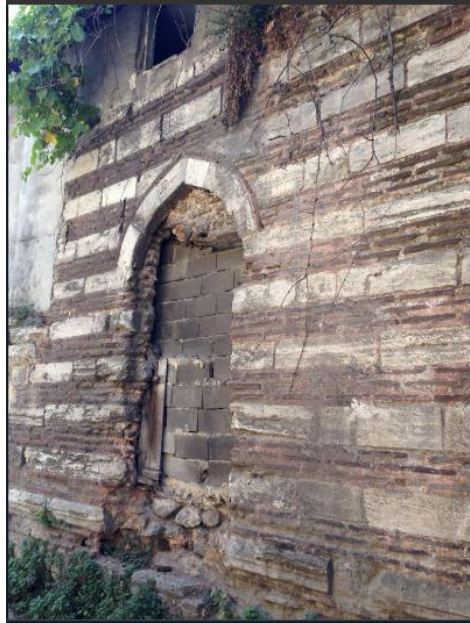
Şekil 4.17.: Kepekçi Sinan Medresesi Cephe Görünümü
