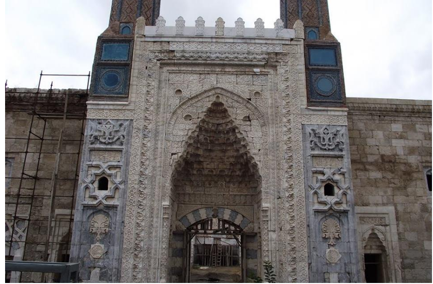
Şekil 2.21.: Sivas Gök Medresesi Taç Kapısı
