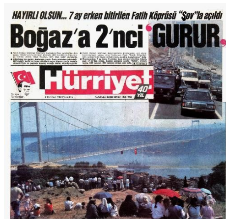
Şekil 5.30. Basında FSM Köprüsü'nün Açılış Töreni
