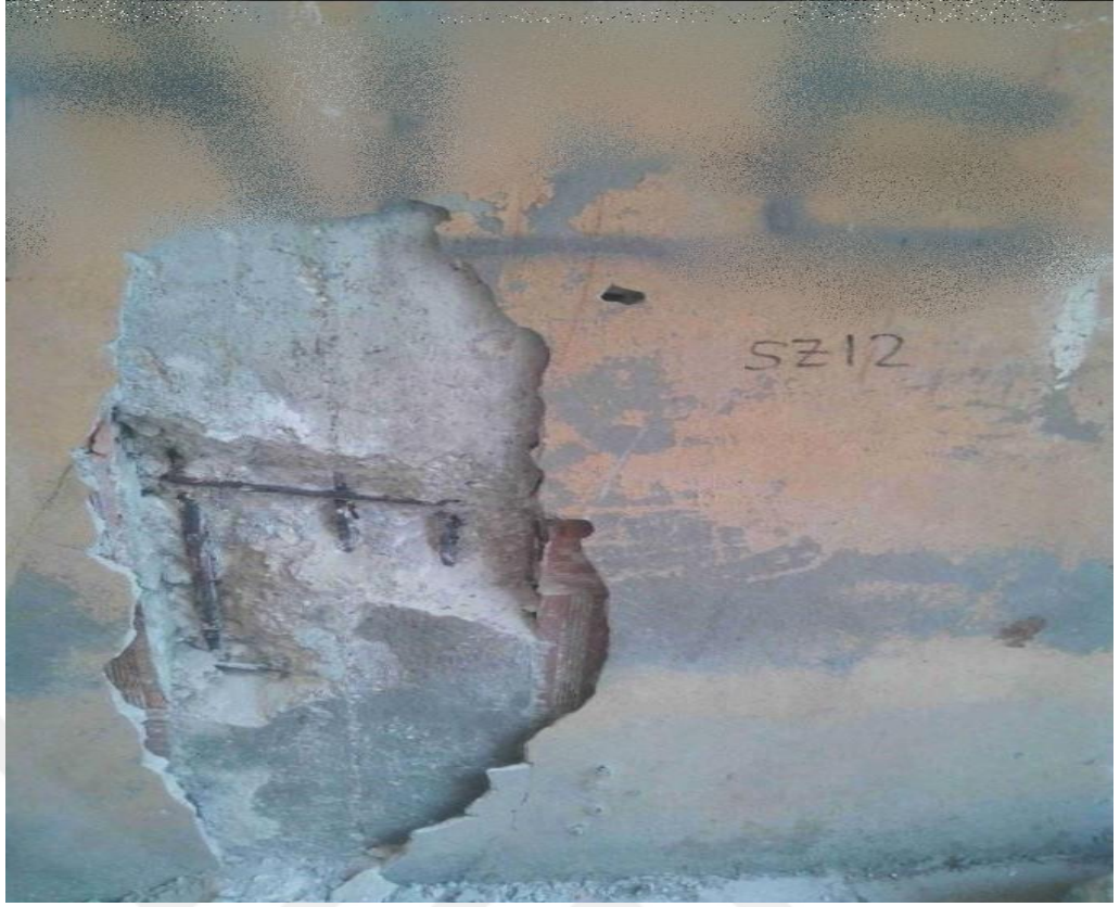
Resim 17. SZ12 Kolonu Genel Görünüm
