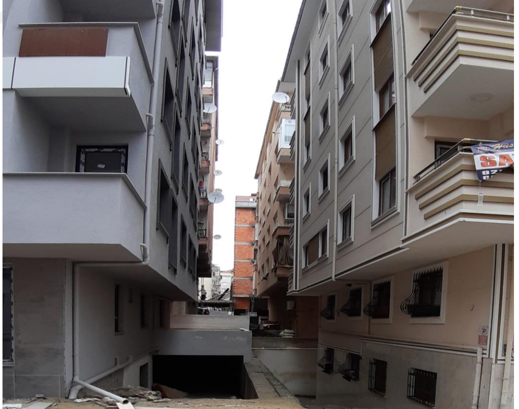
Ek-18. Yapının Otopark Girişi Yan Cephe
