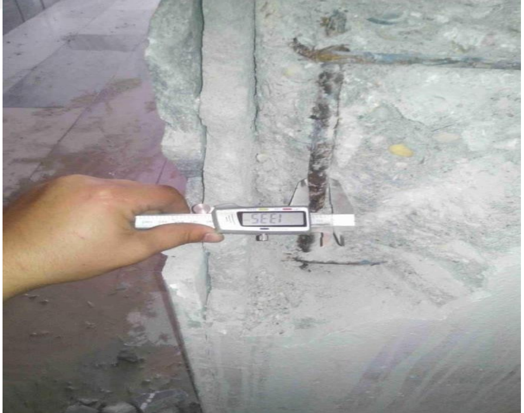
Resim 16. SZ13 Kolonu Donatı Çapı
