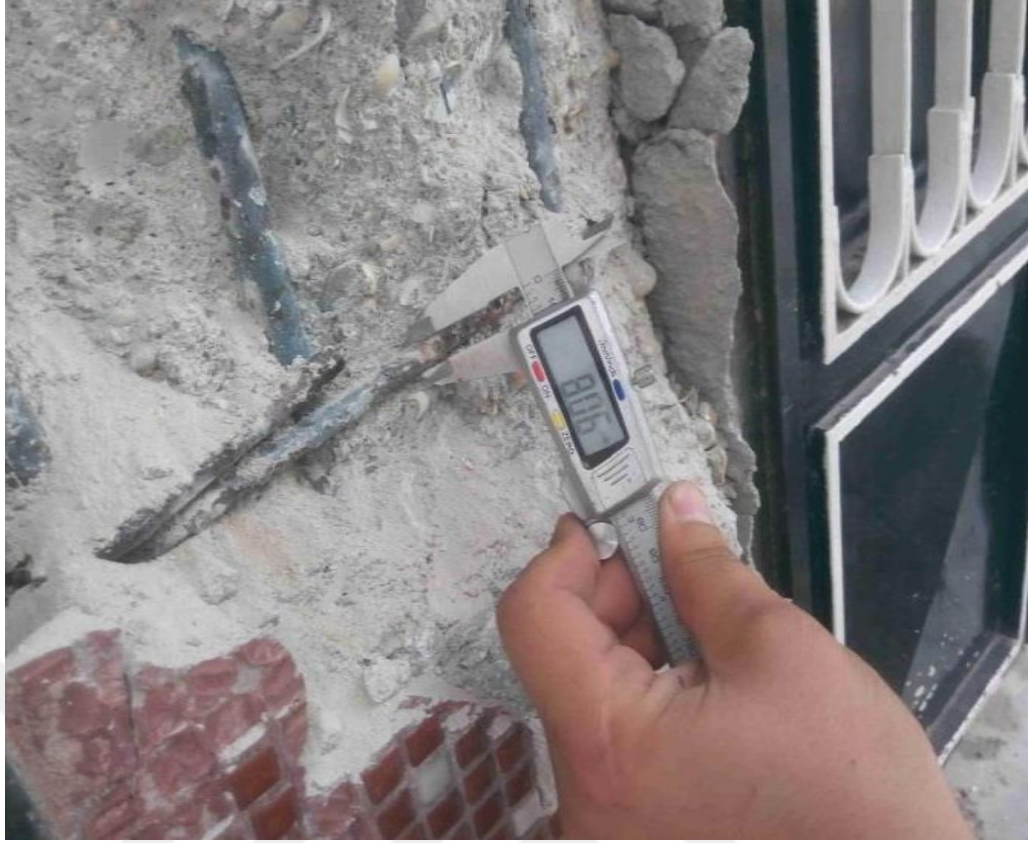
Resim 11. SZ18 Kolonu Donatı Çapı
