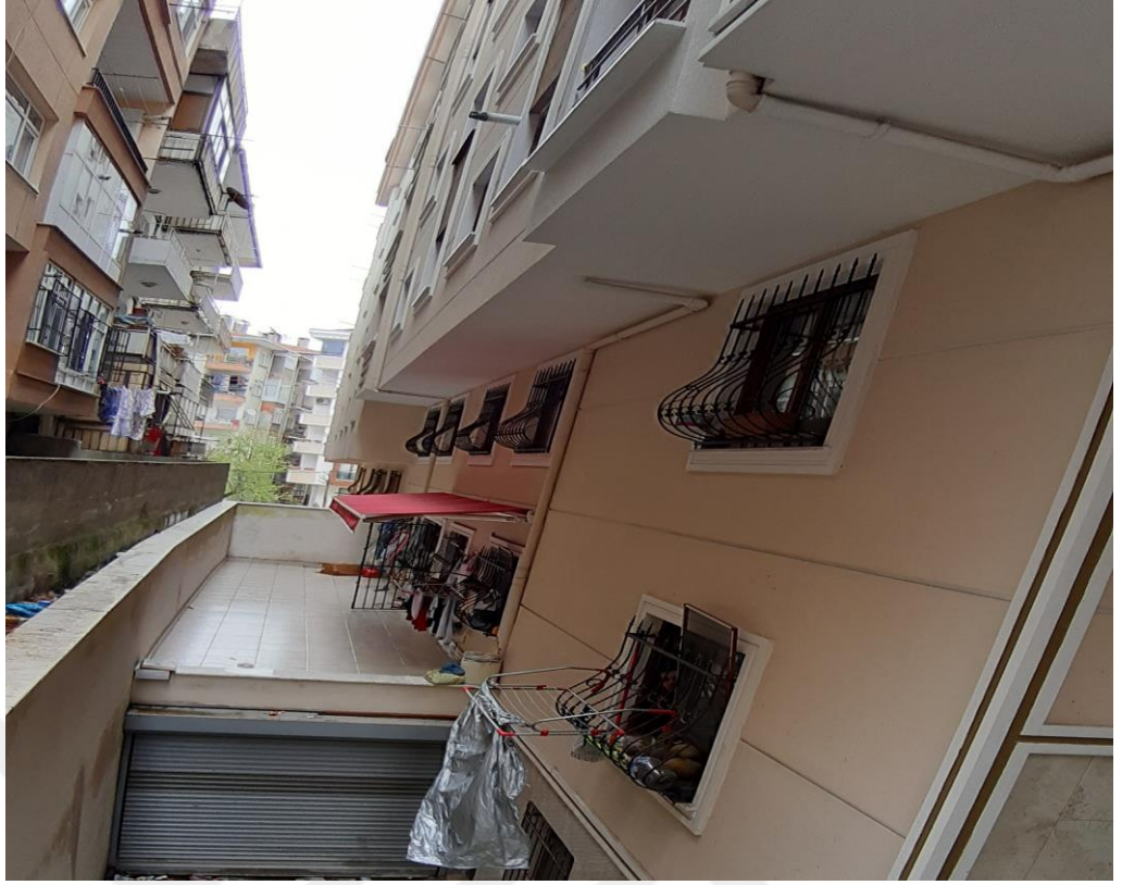
Ek-19. Yapının Otopark Girişİ Arka Cephe
