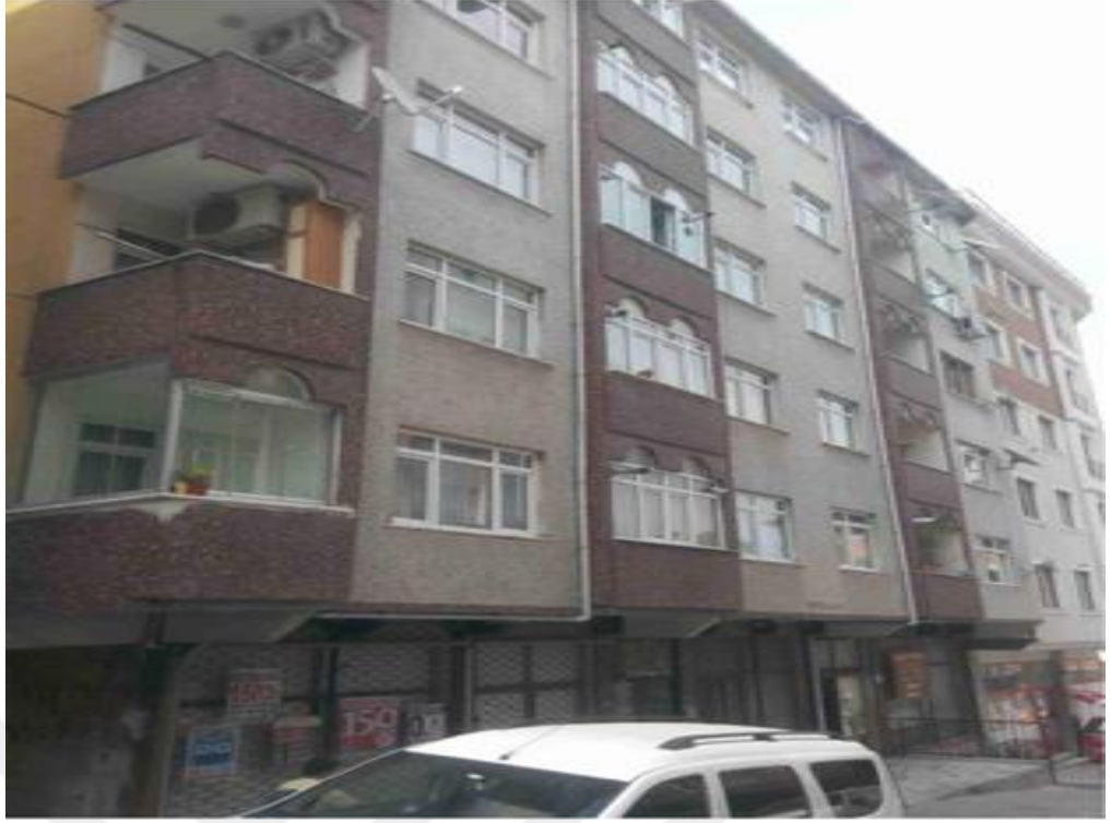
Resim 7. Yapının Saę Cepheden Komşu Binalar ile İlişki
