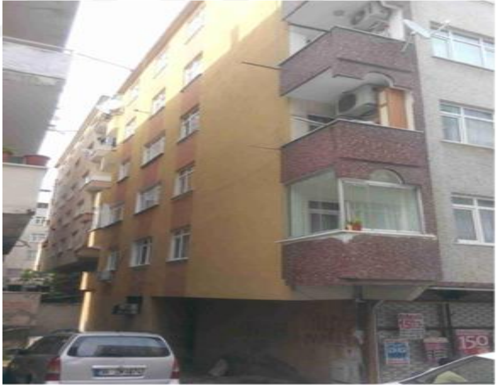
Resim 8. Yapının Sol ve Arka Cepheden Komşu Binalar ile İlişki
