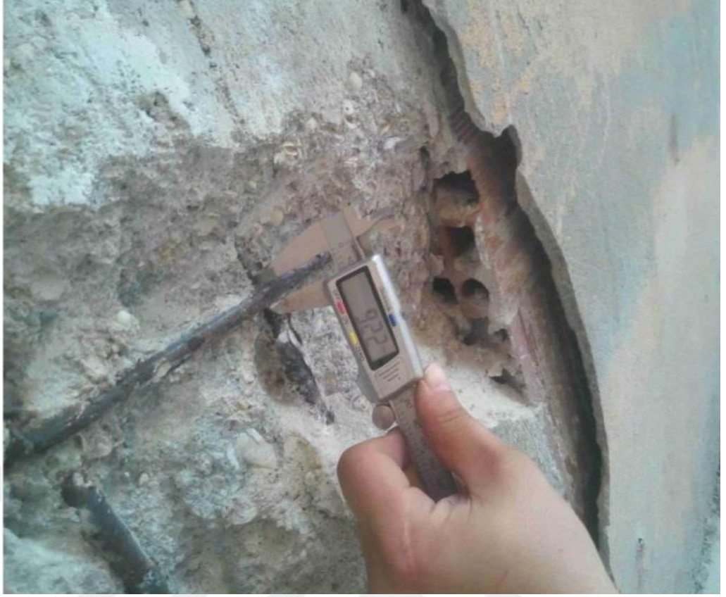
Resim 19. SZ12 Kolonu Donatı Çapı
