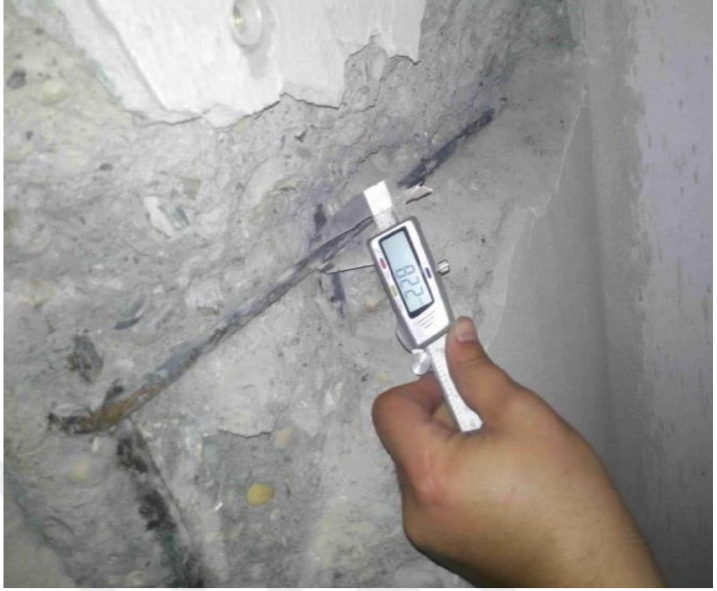
Resim 15. SZ13 Kolonu Donatı Çapı
