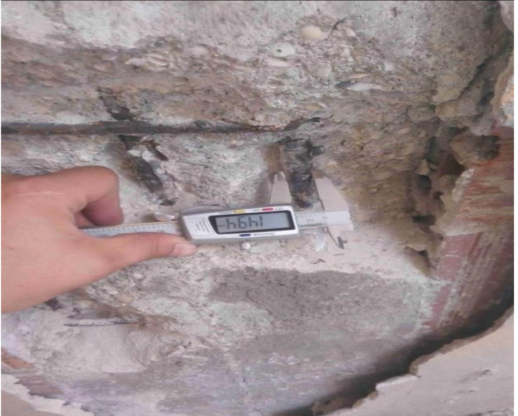
Resim 20. SZ12 Kolonu Donatı Çapı
