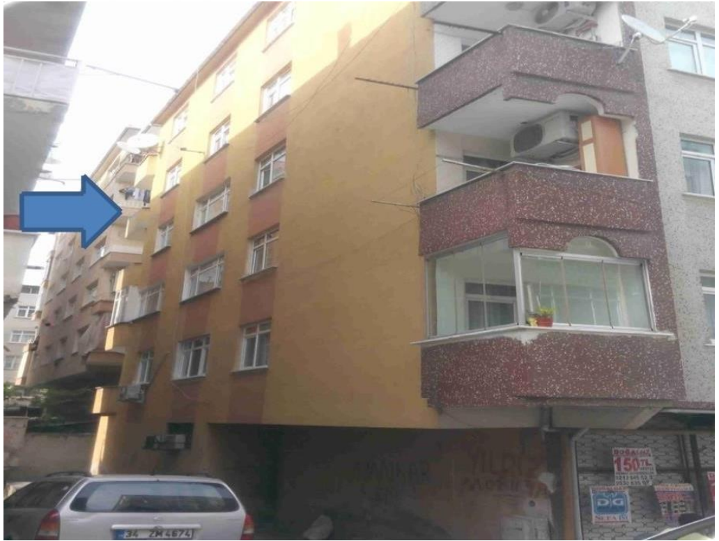
Resim 3. Bina Sol Cephesi
