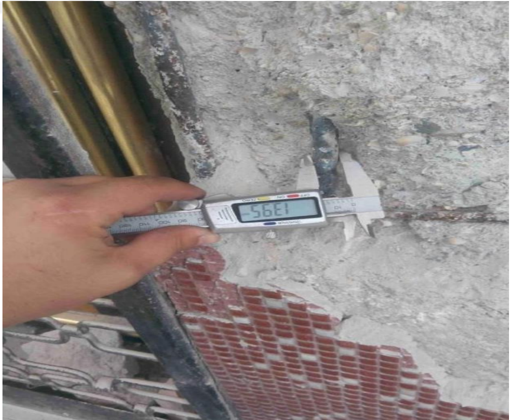
Resim 12. SZ18 Kolonu Donatı Çapı
