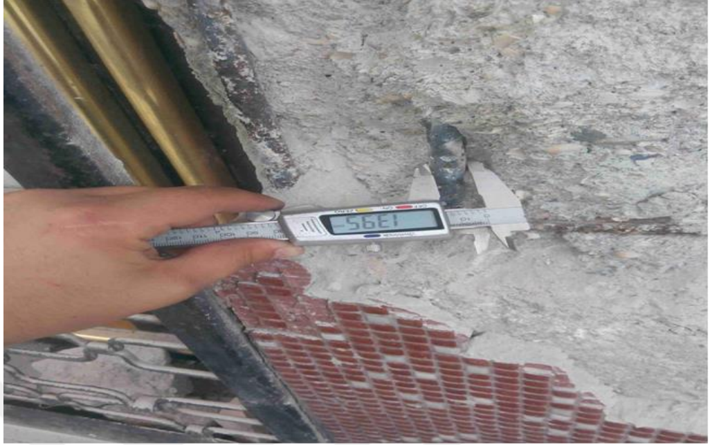
Resim 6. Donatı Korozyonu
