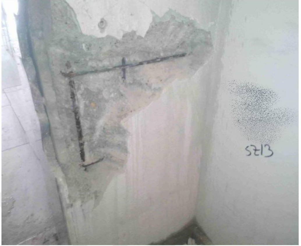
Resim 13. SZ13 Kolonu Genel Görünüm
