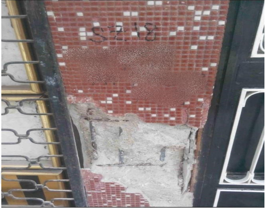
Resim 9. SZ18 Kolonu Genel Görünüm
