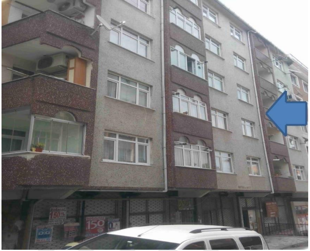
Resim 2. Bina Sađ Cephesi
