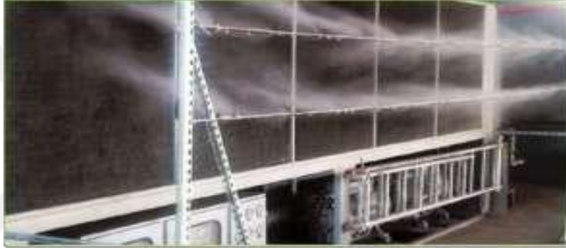
Şekil 2.58. Evaporatif ön soğutma sisteminde giriş havasının soğutulması
