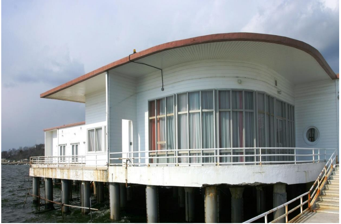
Şekil 4.3 Atatürk Florya Deniz Köşkü Betonarme Ayakları
