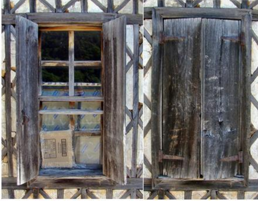
Şekil 2. 34. Ahşap Pencere Görünüşü-I
