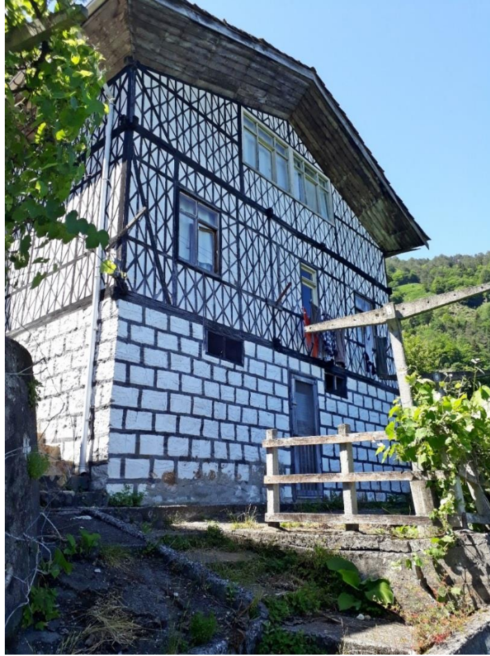
Şekil 3. 8. Kosdiloğulları Ailesi Evi Güney Cephesi
