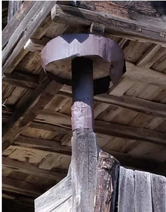
Şekil 2.16. Serenderde Kirişler, Direk Başı Ve Ahşap Tekerlek
