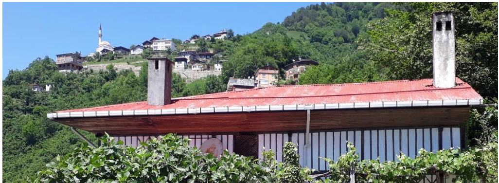
Şekil 3.65. Çatı Oluklu Kaplama
