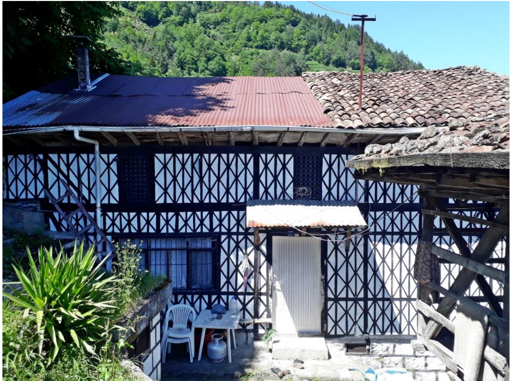
Şekil 3.9. Kosdiloğulları Ailesi Evi Batı Cephesi
