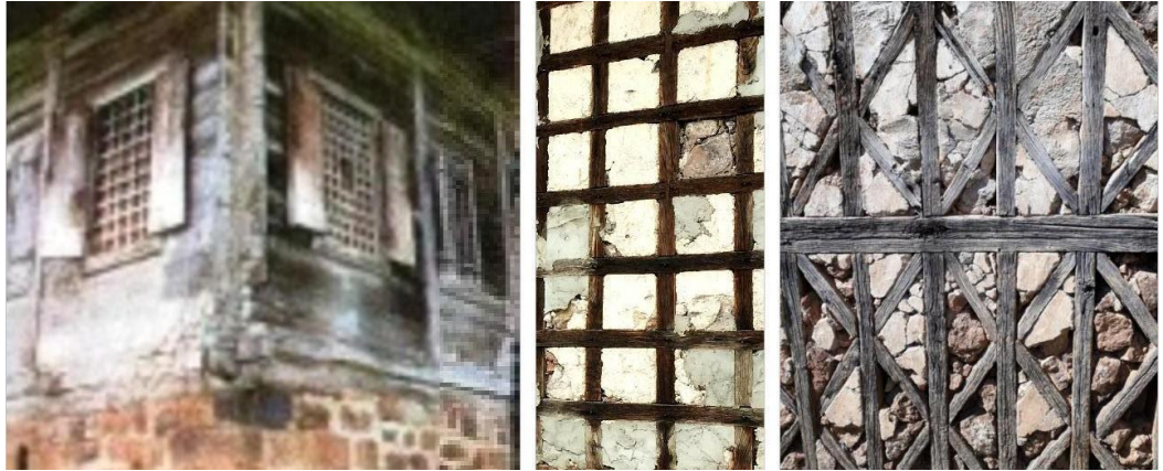
Şekil 2.45. Ahşap dolma, göz dolma ve muskalı dolma duvar örnekleri
