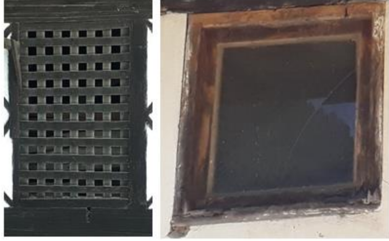
Şekil 2.36. Çatı Kat Ahşap Izgara Pencere Görünüşü-Bodrum Kat Pencere Görünüşü
