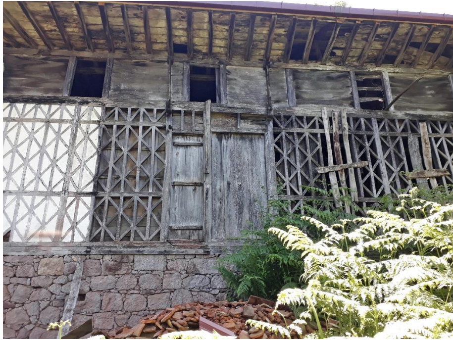
Şekil 3.81. Zaimoğulları Ailesi Evi Doğu Cephesi
