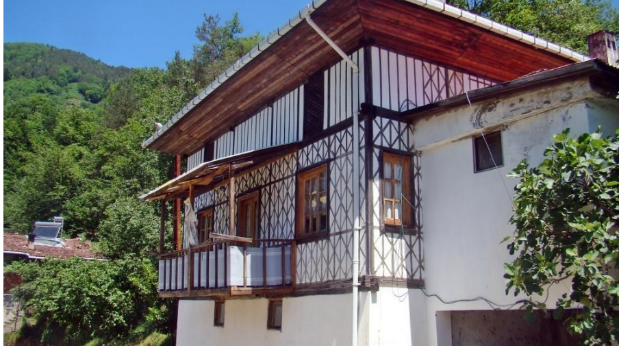
Şekil 2.30. Çıkma Örneği
