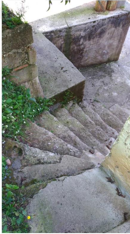
Şekil 2.33. Evin Dışındaki Çatıya Çıkan Ve Bodruma İnen Merdiven Örnekler-II
