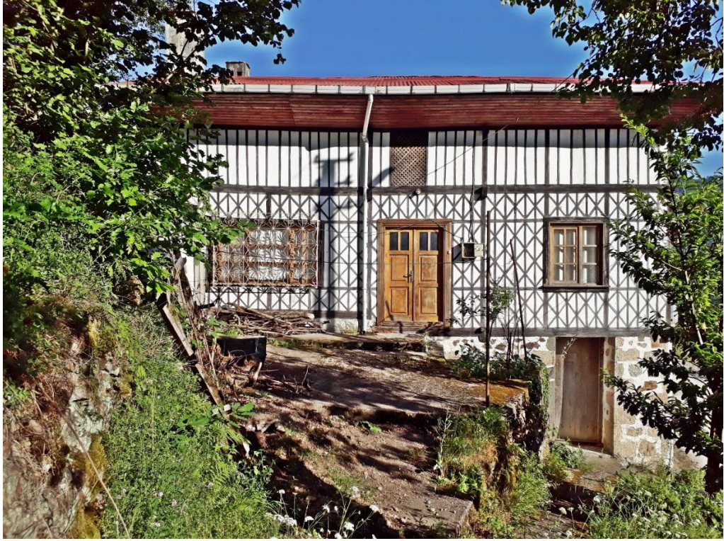
Şekil 3.63. Saraloğulları Ailesi Evi Batı Cehesi
