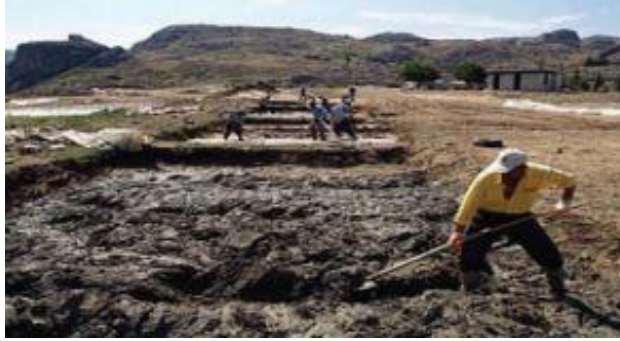
Şekil 2.25. Kerpiç Harcının Hazırlanması
