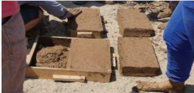
Şekil 2.26. Kerpiç Harcının Kalıplanması
