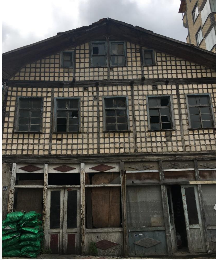
Şekil 2. 44. Ahşap dolma, göz dolma duvar yapı örneği
