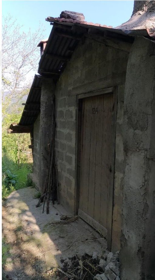
Şekil 3.29. Hasenekolar Ailesi Evi Kuzey Cephesi
