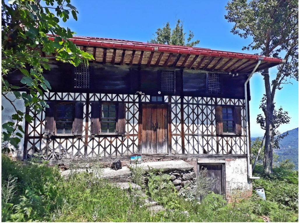
Şekil 3.73. Zaimoğulları Ailesi Evi
