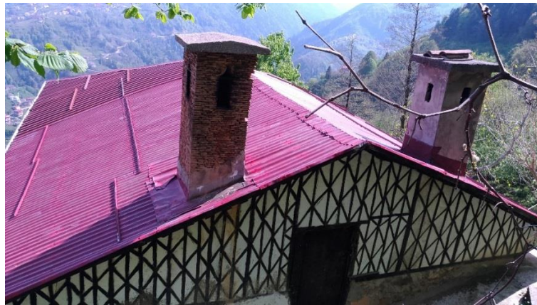
Şekil 3.48 Oluklu Çatı Kaplama
