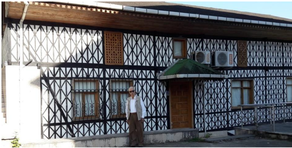
řekil 2. 43. Ahřap dolma, muskal dolma duvar yapı rnekleri
