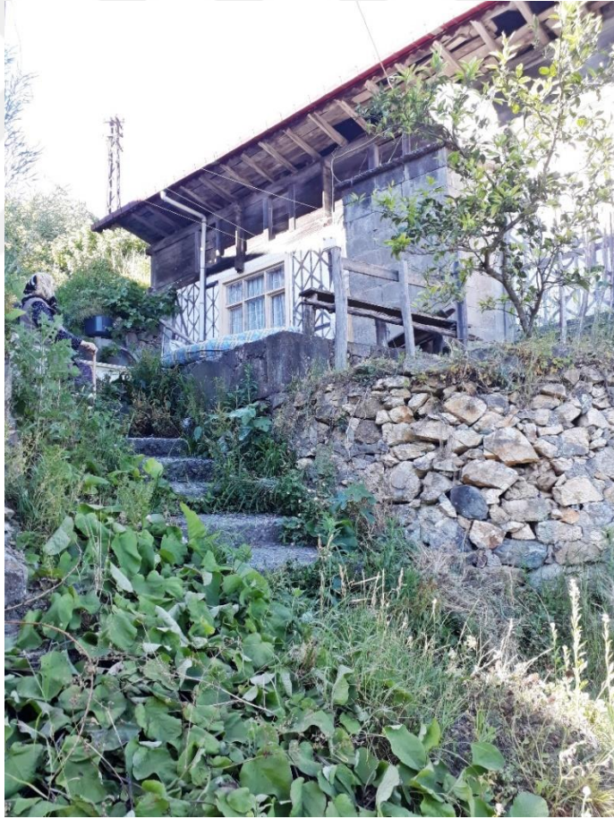
Şekil 3.97. Topçu Ailesi Evi Batı Cephesi
