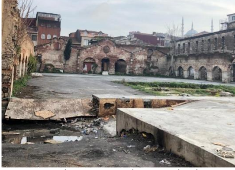
D: Fırın Binası, Kuzeybatı Cephesi
