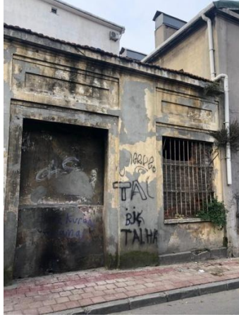
G: Sinema Binası, Güneydoğu Cephesi
