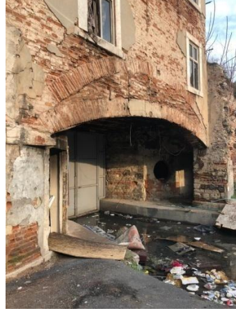
B: Lojman Binası, Güneybatı Cephesi
