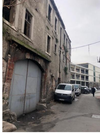
B: Lojman Binası, Kuzeydoğu Cephesi
