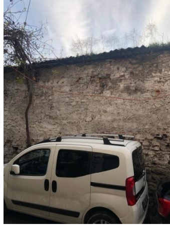
C: Servis Binası, Kuzeydoğu Cephesi
