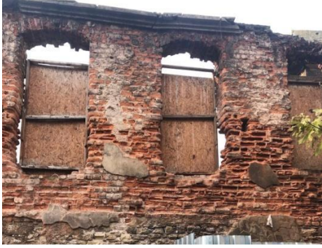
D: Fırın Binası, Güneydoğu Cephesi
