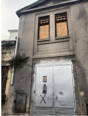
E: Trafo Binası, Güneydoğu Cephesi
