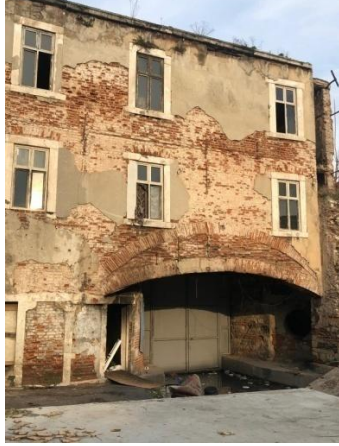
B: Lojman Binası, Güneybatı Cephesi
