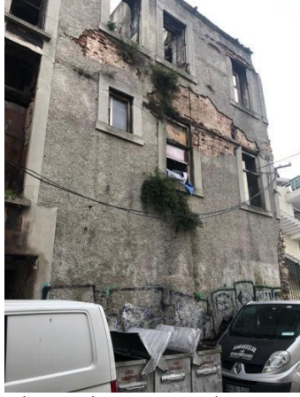
B: Lojman Binası, Kuzeydoğu Cephesi
