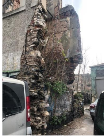
B: Lojman Binası, Kuzeybatı Cephesi
