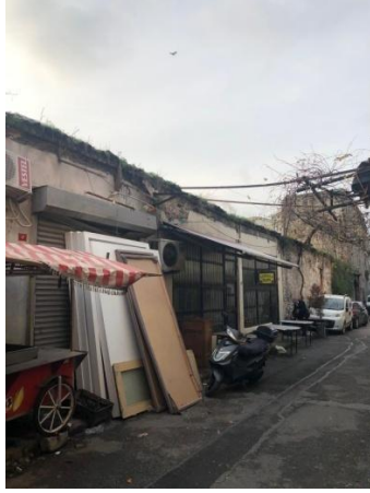
C: Servis Binası, Kuzeydoğu Cephesi
