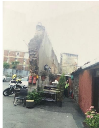
C: Servis Binası, Güneydoğu Cephesi
