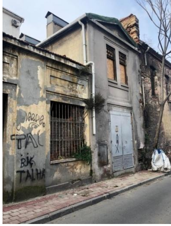
E: Trafo Binası, Güneydoğu Cephesi
