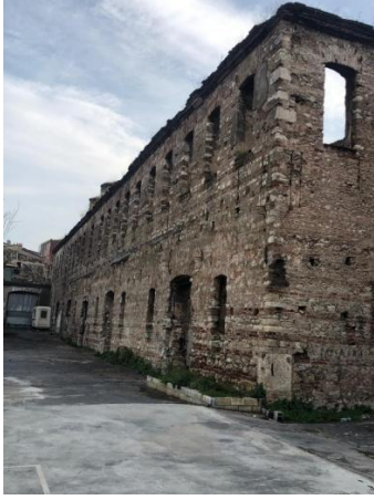
F: Depo Binası, Kuzeydoğu Cephesi
