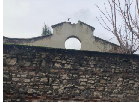
D: Fırın Binası, Güneydoğu Cephesi
