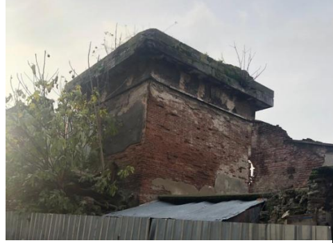
D: Fırın Binası Bacası, Güneydoğu Cephesi
