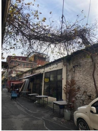
C: Servis Binası, Kuzeydoğu Cephesi
