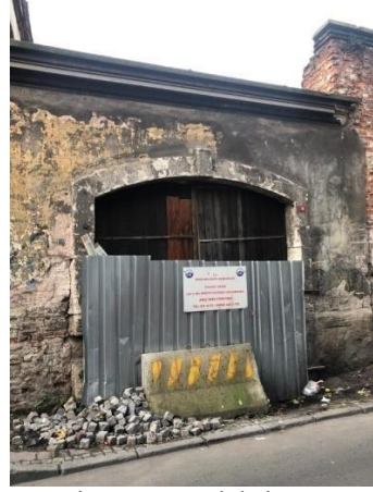
F: Depo Binası, Kompleksin Ana Kapısı
