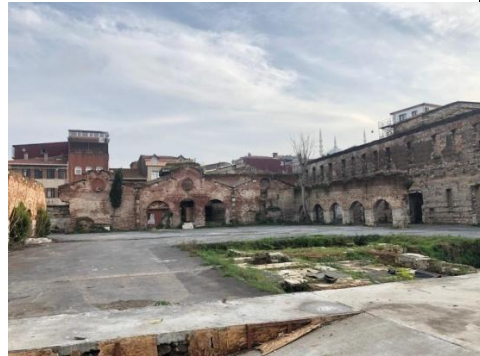
D: Fırın Binası, Cephesi
