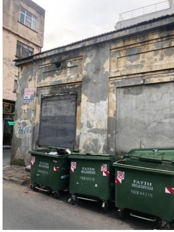
G: Sinema Binası, Güneydoğu Cephesi
