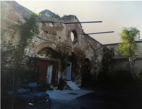
D: Fırın Binası, Güneydoğu Cephesi
