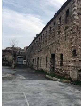
F: Depo Binası, Kuzeydoğu Cephesi
