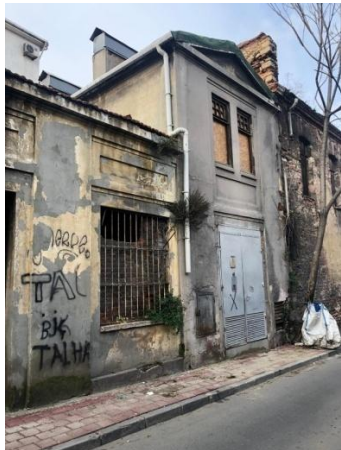
E: Trafo Binası, Güneydoğu Cephesi
