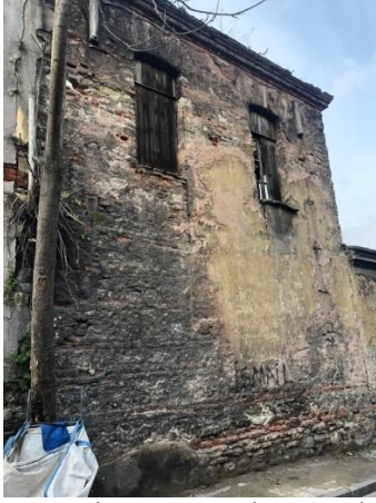
F: Depo Binası, Güneydoğu Cephesi
