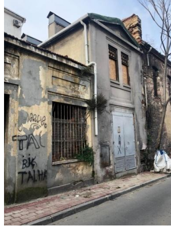
G: Sinema Binası, Güneydoğu Cephesi
