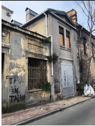
E, G: Sinema ve Trafo Binası
