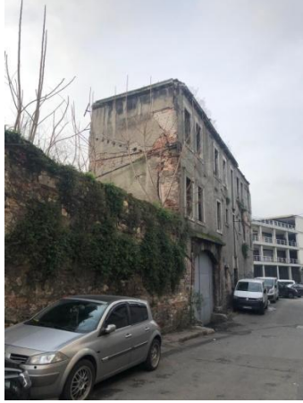
B: Lojman Binası, Kuzeydoğu Cephesi
