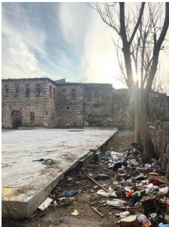
F: Depo Binası, Kuzeydoğu Cephesi
