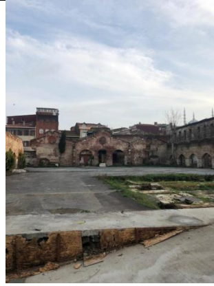
D: Fırın Binası
