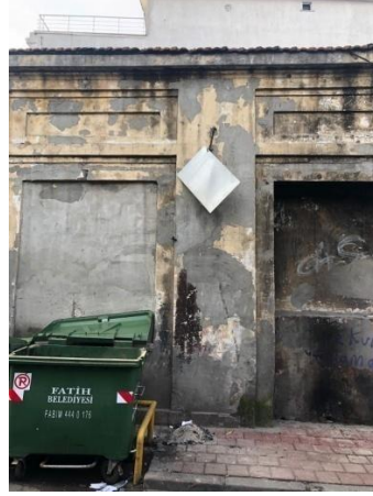
G: Sinema Binası, Güneydoğu Cephesi
