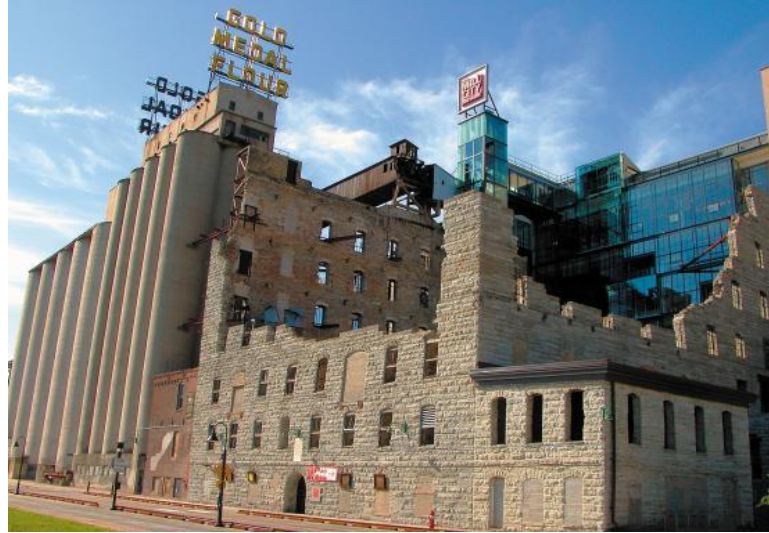
Şekil 3.21: Terk Edilmiş Washburn A Mill, 1976
