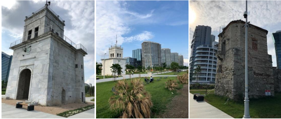
Şekil 3.50: Ataköy Sahil Hattı Üzerindeki Baruthane Binasını Yapıları, Dış Duvarları
