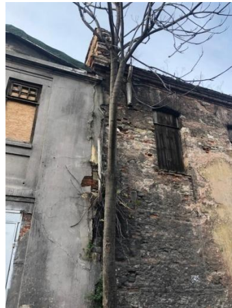
E: Trafo Binası, Güneydoğu Cephesi
