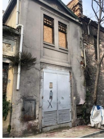
E: Trafo Binası, Güneydoğu Cephesi
