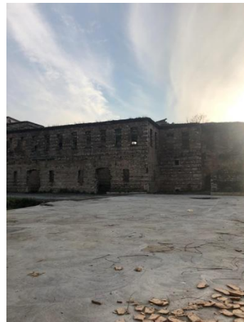
F: Depo Binası, Kuzeydoğu Cephesi
