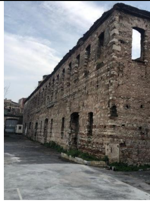
F: Depo Binası
