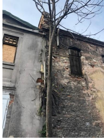
E: Trafo Binası, Güneydoğu Cephesi
