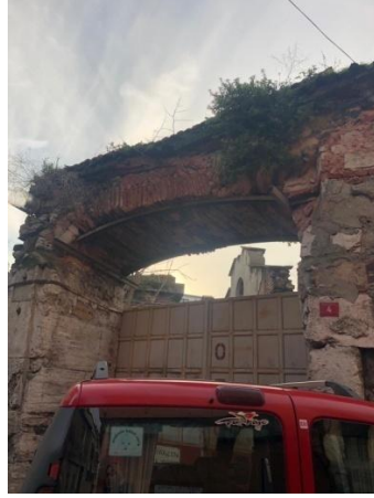
C: Servis Binası, Kuzeydoğu Cephesi
