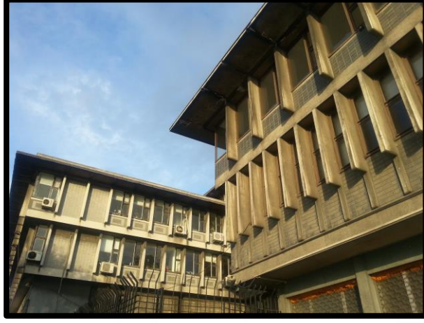
Şekil 5.10. SSK Yapısının Prefabrik Elemanlarla Birbirinden Ayrılmış Pencereleeri.
