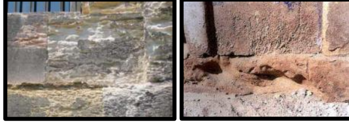
Şekil 2.6. Atmosferin Etkisiyle Taşlarda Oluşan Bozulma.
