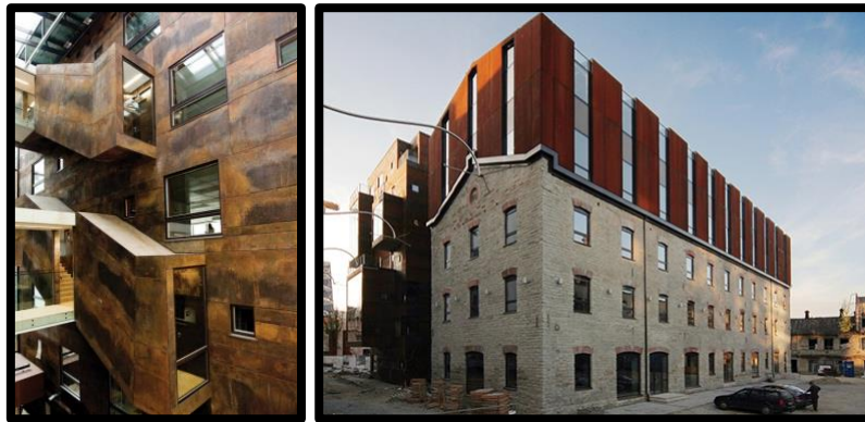
Şekil 5.42. Kendine Has Pürüzlü Yüzeyleri ile Korten (Paslı) Çelik Kullanımı.
