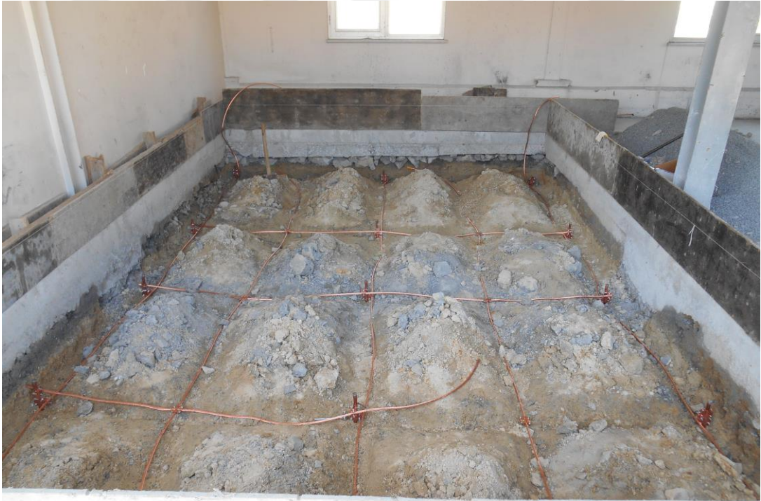
Şekil 6.4 Topraklama kazıkları ve şerit donatı
