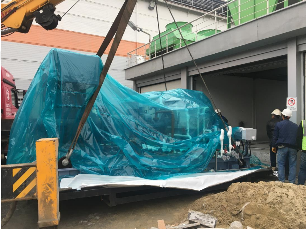
Şekil 6.12 Buhar türbini kurulumu
