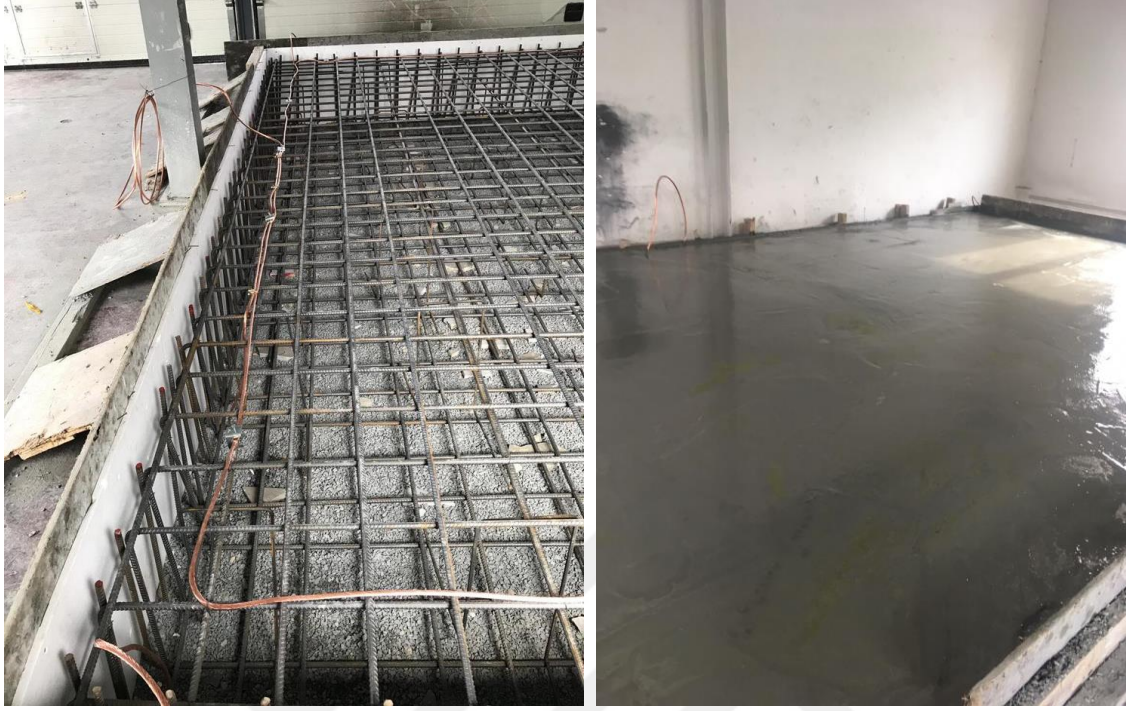
Şekil 6.6 Buhar türbini temel hazırlama
