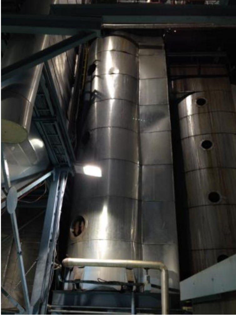
Şekil 2.9 Ekonomizer Ünitesi
