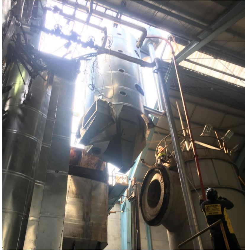
Şekil 6.9 Buhar kazanı montajı
