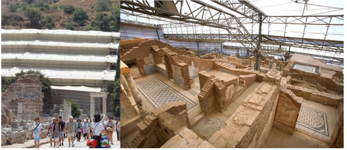
Şekil 2.1. Efes yamaç evlerinin mevcut haliyle korunmasına yönelik inşa edilen çelik koruma sistemi
