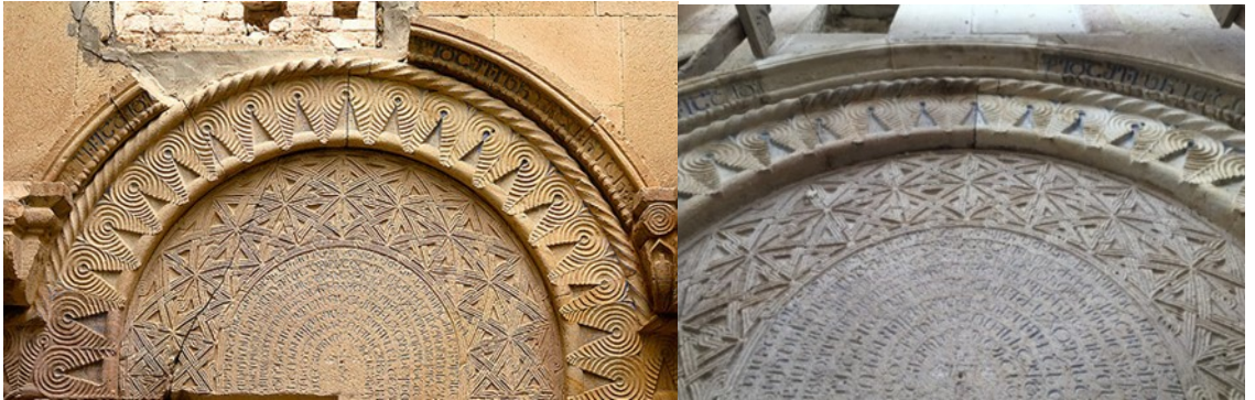
Şekil 2.5. İşhan kilisesi giriş kapısında bulunan hasarlı bölgenin imitasyon çalışması ile yenilenmesi
