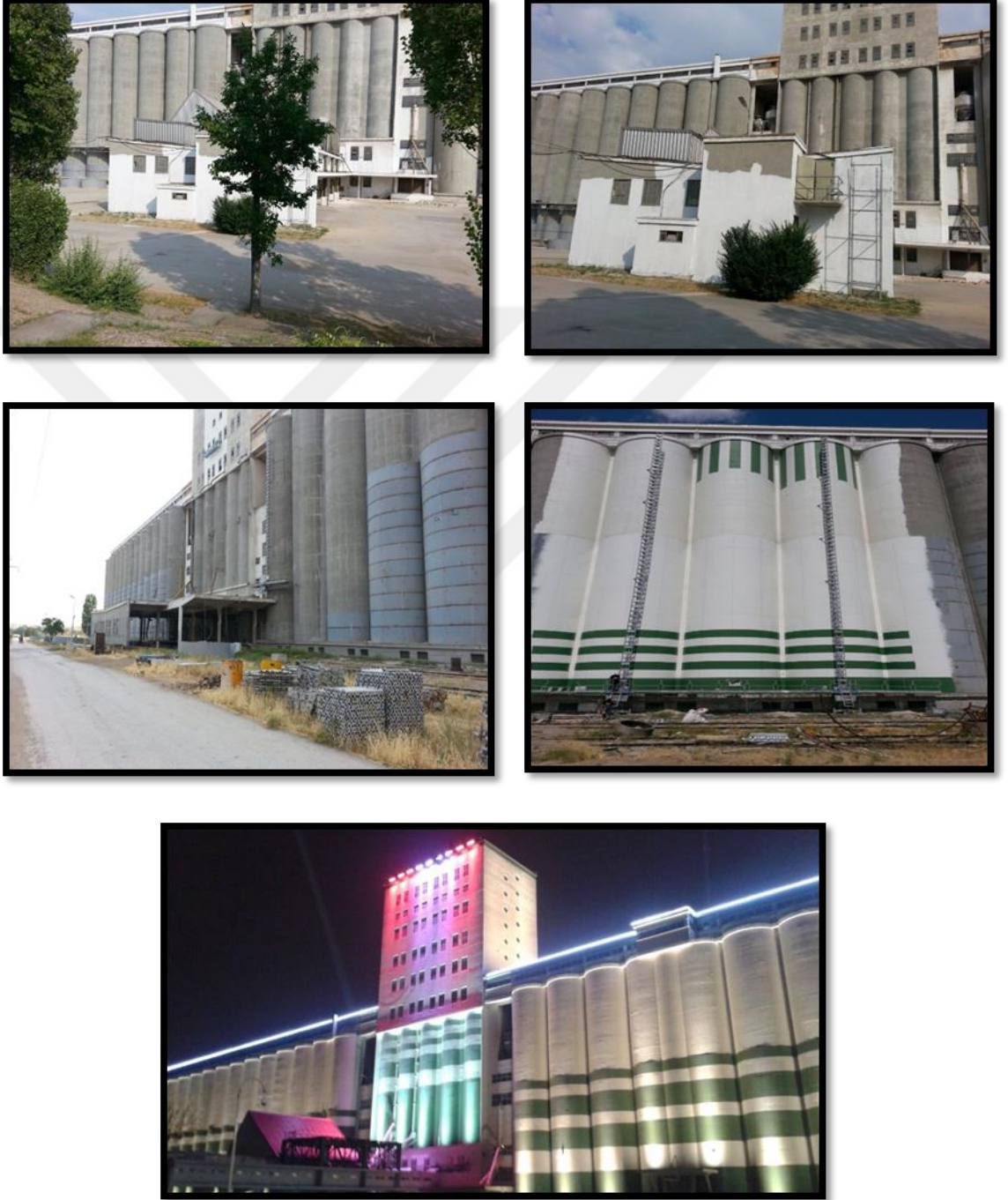
Őekil 2.8. Toprak Mahsuller Ofisi betonarme siloları (Tamcan, 2015)
