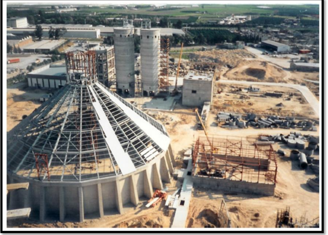
Şekil 2.5. Mersin nervürlü klinker silosu (Babagiray, 2010)
