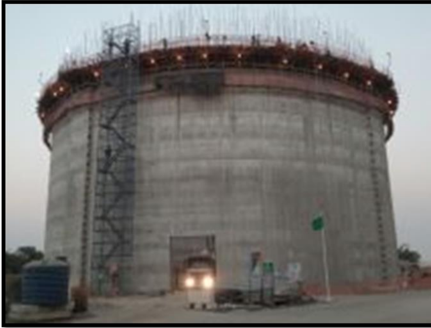
Şekil 2.6. Çimsa Eskişehir klinker silosu (Anonim, 2018a)
