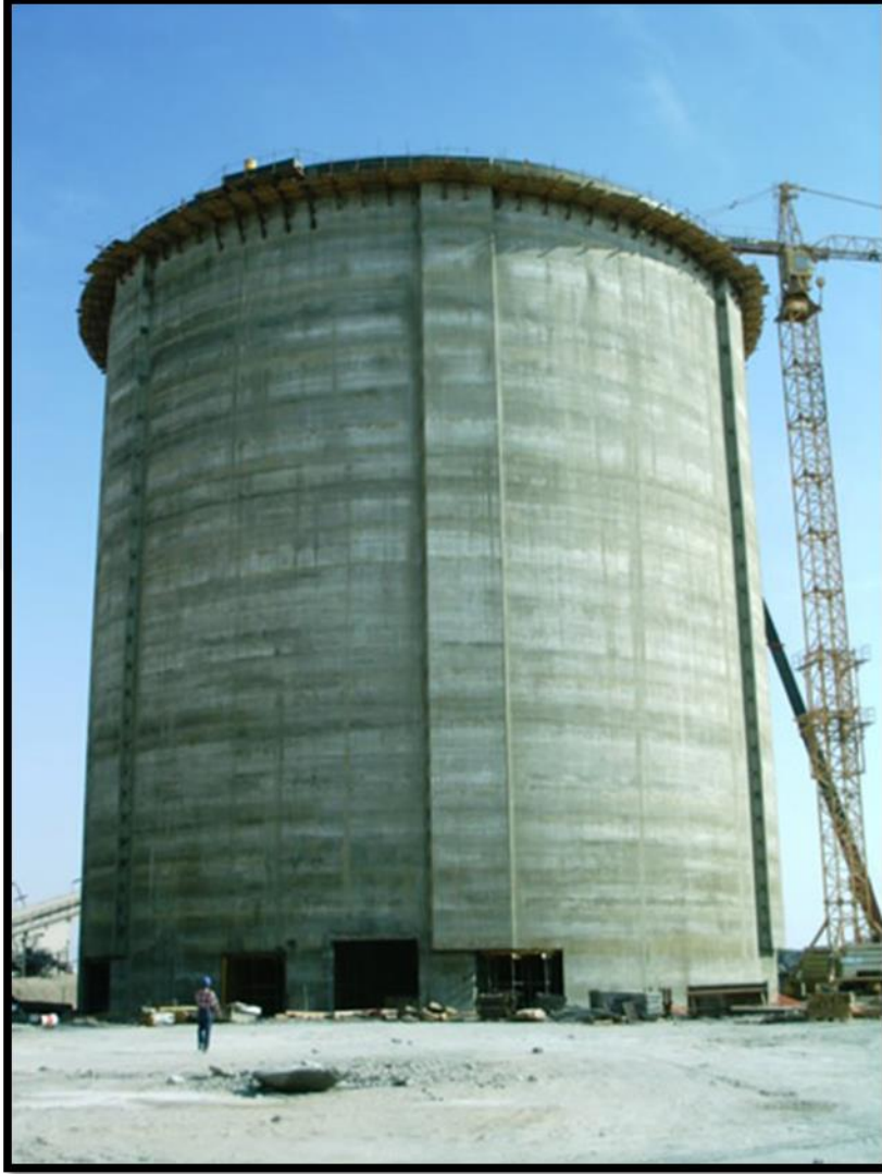
Şekil 2.7. Ardgame klinker silo inşası (Anonim, 2018b)
