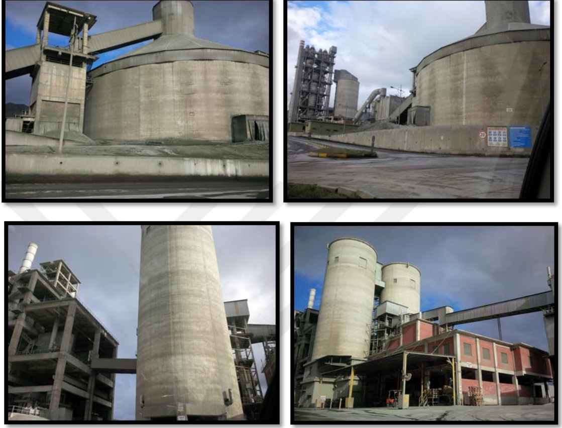
Şekil 2.9. Traçim betonarme siloları
