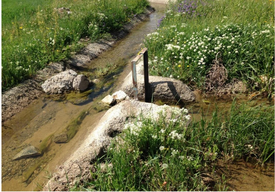
Resim 10: Dolutaş Mahallesiinde Sulanabilir Arazilerinde Salma Sulama İin Yapılan Tarla Başı Kanalı
