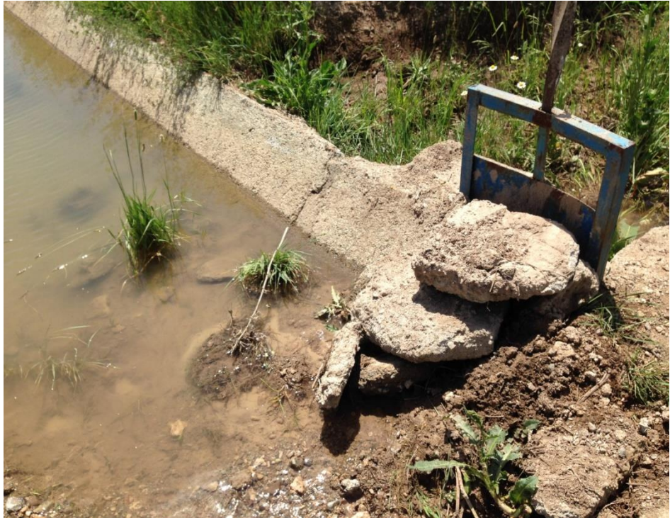
Resim 14: Beyarslan Mahallesiinde Sulanabilir Arazileri İin Yapılan Sulama Kanalı Savađı
