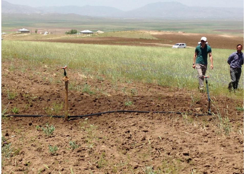
Resim 4: Saray Değirmigöl Mahaltesinde Sulanabilir Arazilerinde Yağmurlama Sulama Sistemi Kontrolü
