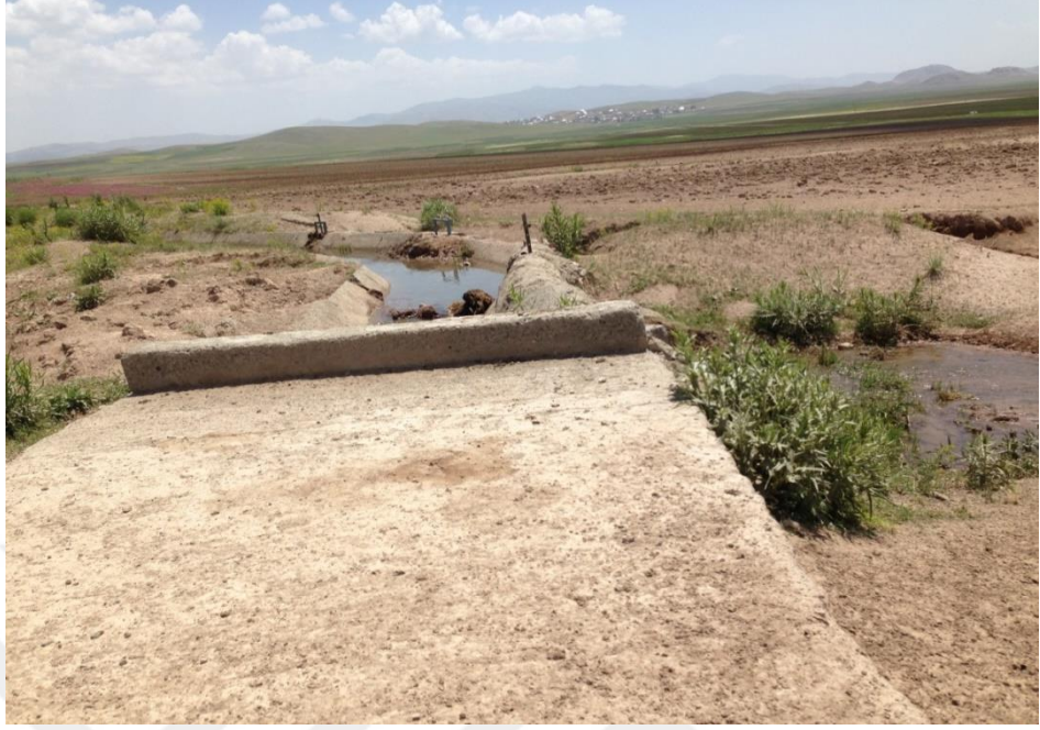
Resim 13: Beyarslan Mahallesiinde Sulanabilir Arazilerinde Salma Sulama İin Yapılan Sulama Gleti
