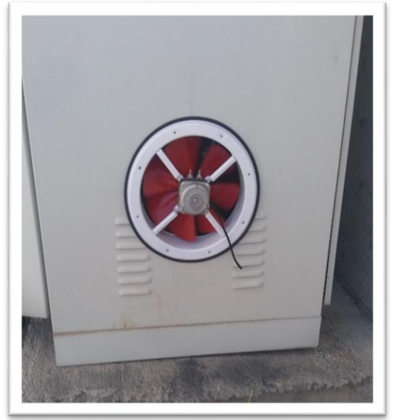
Şekil 4.28. Şönt Reaktör Panosunda içeriye hava akımı transfer eden fanlar
