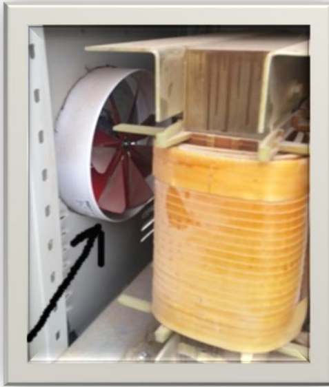
Şekil 4.28. Şönt Reaktör Panosunda içeriye hava akımı transfer eden fanlar
