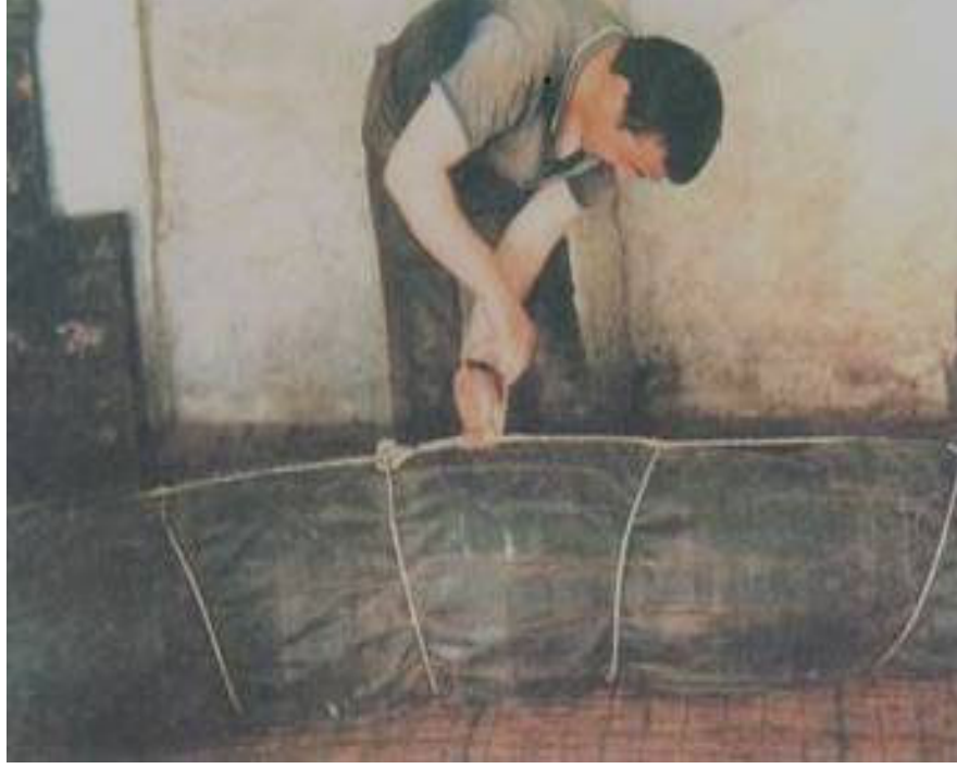
Şekil.5.19. Tepme keçe yapımında rulonun bağlanması (Tire, 1992) Kaynak: Ergenekon, 1999, s. 70.
