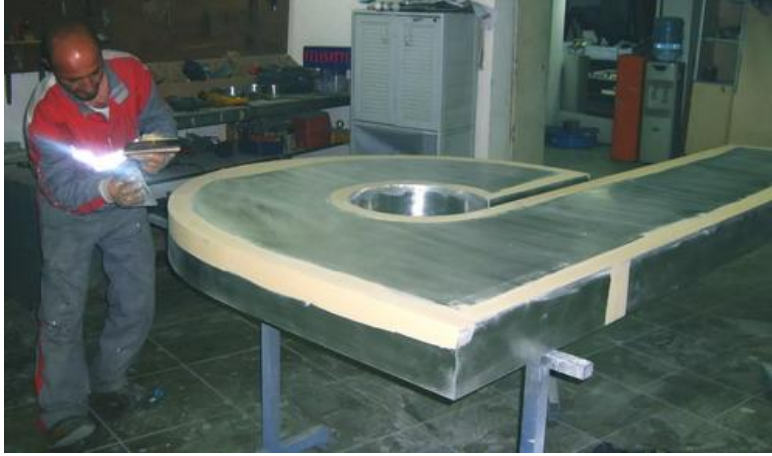
Şekil 3.15 İmalat Bölümü Dış Cephe Reklâm Tasarımı Boya Kaplama Hazırlık
