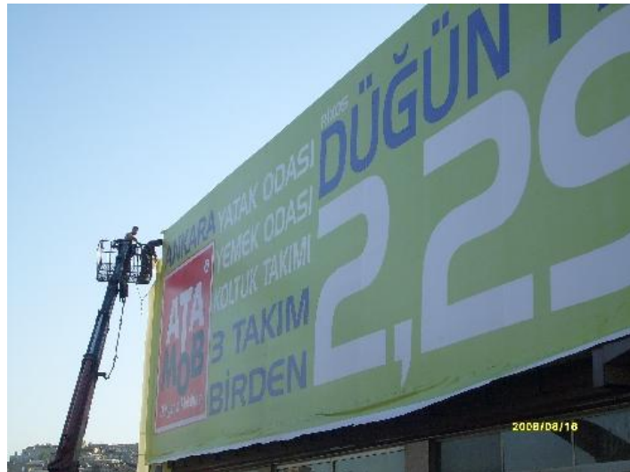
Şekil 3.3 Yerinde Vinil Germe Tekniği
