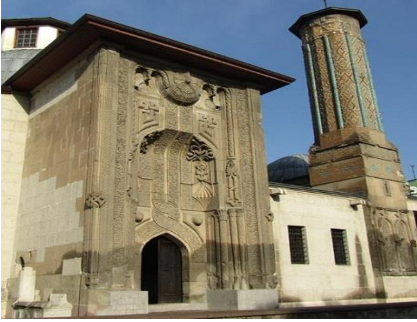
Foto 20: Dođu duvarı ve pencereler.
