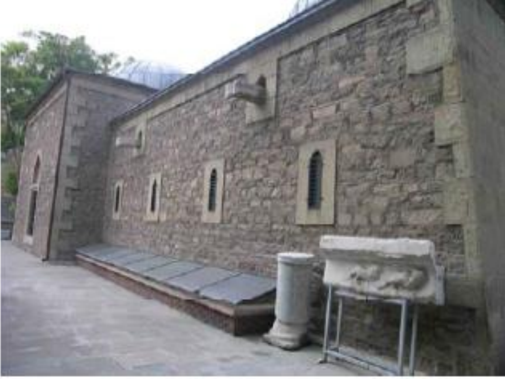
Foto 5: Güney cephe, (onarım sonrası).
