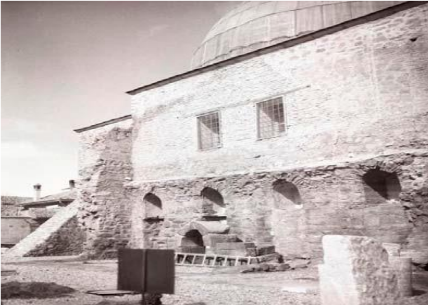
Foto 4: Güney cephe, (onarım öncesi, VGM. Arşivinden).
