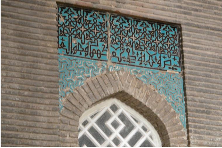
Foto 18: Pencere alınlıkları, (kuzey cephe).
