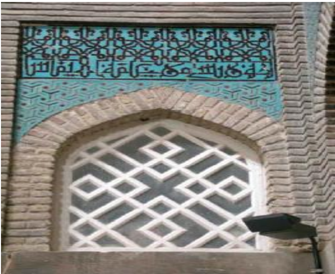
Foto 19: Pencere alınlıkları, (güney cephe).
