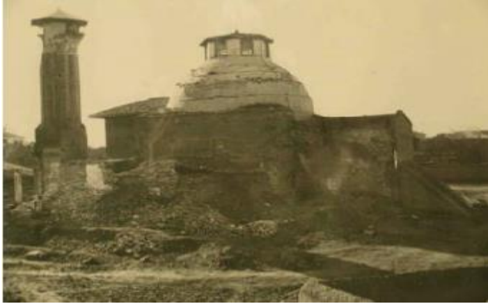
Foto 21: Mescidin XX. yy.'da yıkılmıř durumu, (VGM. Arřivinden).
