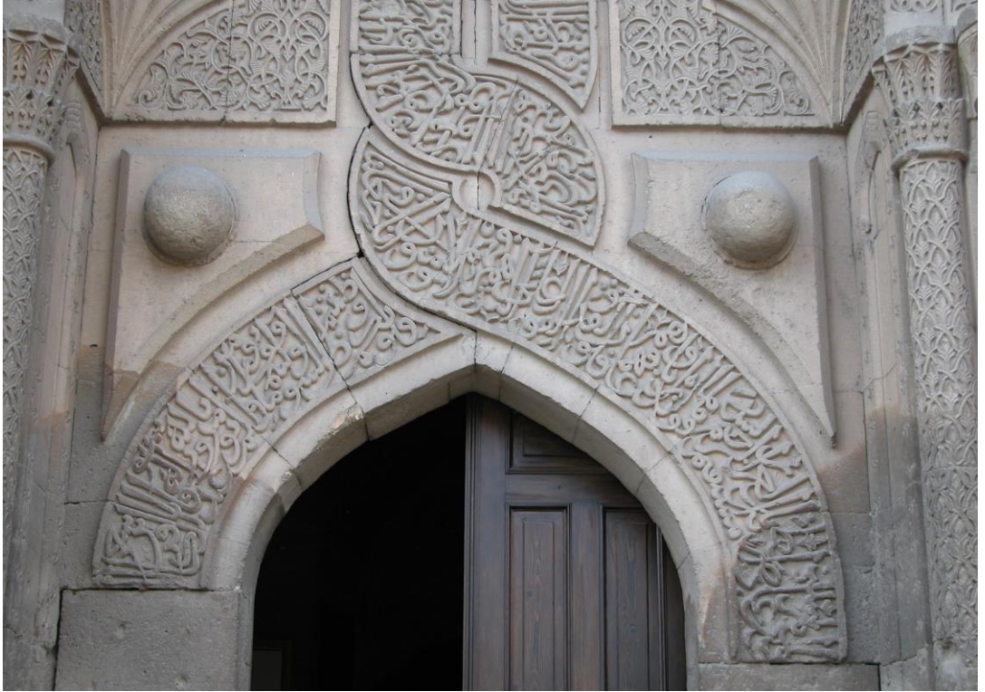
Foto 40: Giriş kapısının üst sağ ve sol kısmında yer alan kabaralar.
