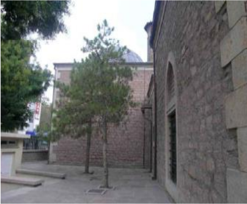
Foto 8: Kuzey cephe, (onarım sonrası).
