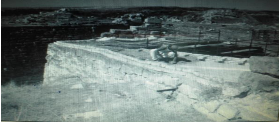
(Res:14) Sitadel Giriş, Kuzey Avlusu, Doğu Duvarı, kapatma işlemi (K.Sams,B.Rose,2010)
