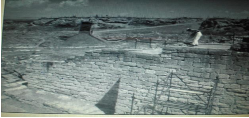
(Res:15) Sitadel Giriş, Kuzey Avlusu (bkz.yukarda) Güney Duvarı Kapatma İşlemi (Sams, Rose,2010)
