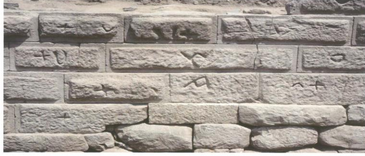
(res:61) Lidya Dönemi suru kapısındaki duvar örgüsünden detay ve duvarcı işaretleri (Cahill, 2010)
