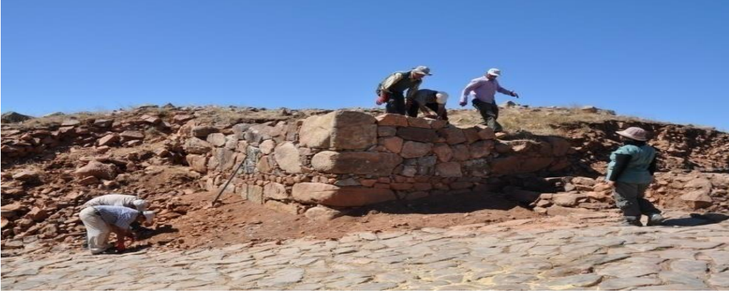
(Res:39) Batı Kule onarım aşaması (Summers, 2011)
