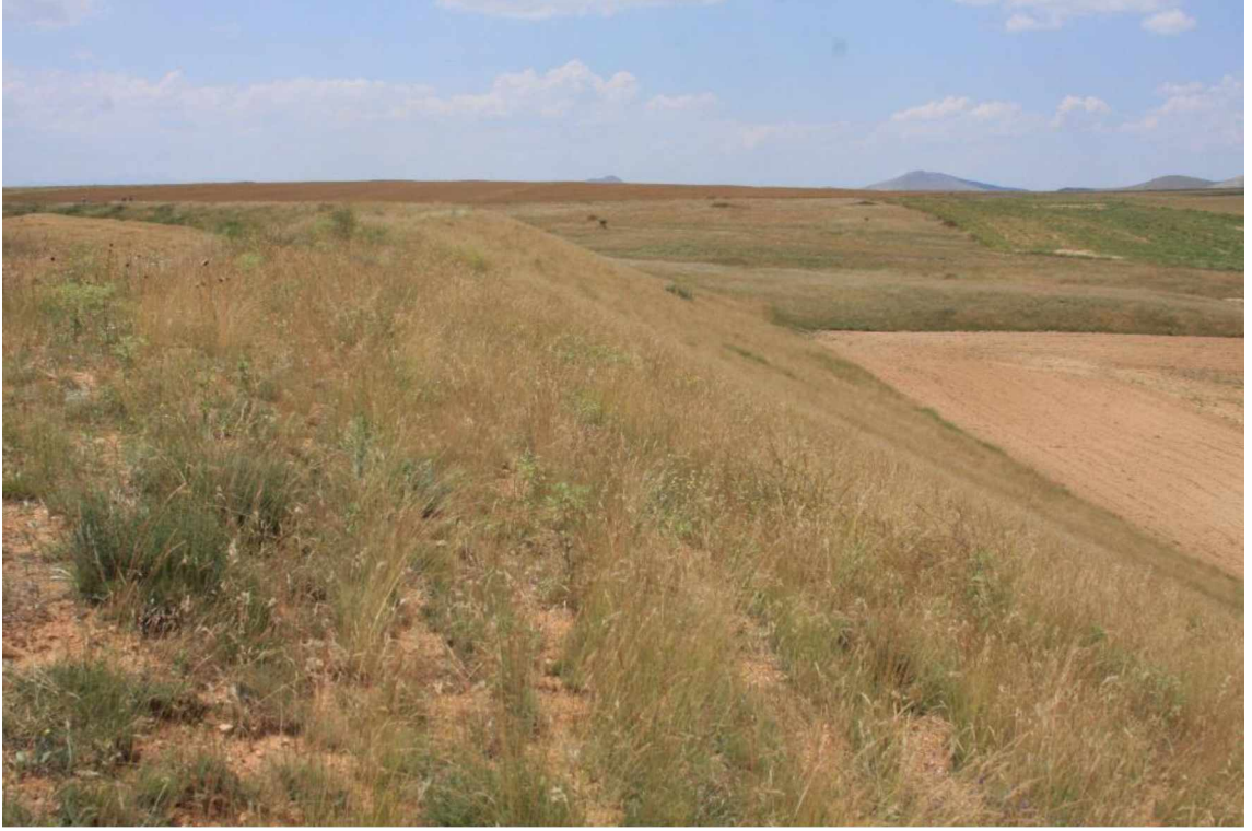
(Resim:127) Köylütolu Baraj Seddi. (Harmanşah ve Johnson 2015)
