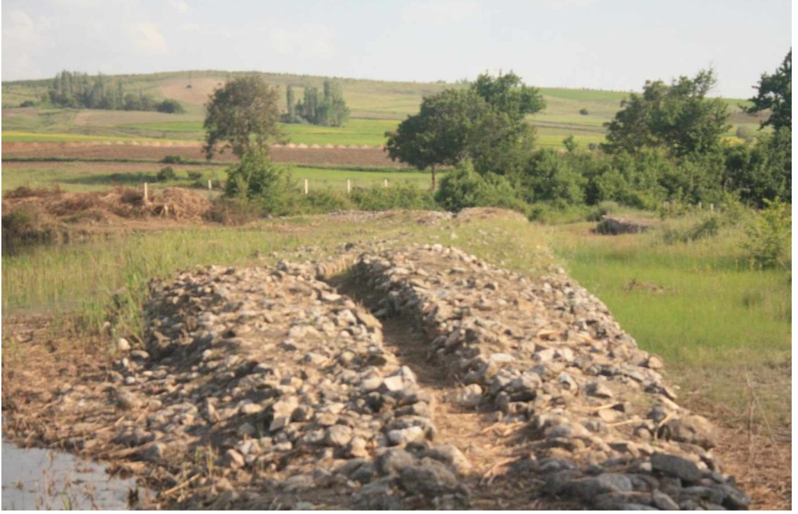
(Resim:7) Alacahöyük Hitit Barajı, şev duvarının örgü yapısı.(Ayşe Üke, arşiv)
