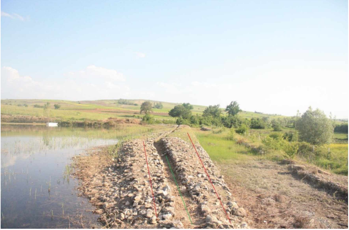
(Resim:9) Alacahöyük Hitit Barajı, kırmızı hat ile belirtilen yerler şev duvarları, yeşil hat ile ifade edilen bölge baraja ait savak yapısıdır.(Ayşe Üke, arşiv)
