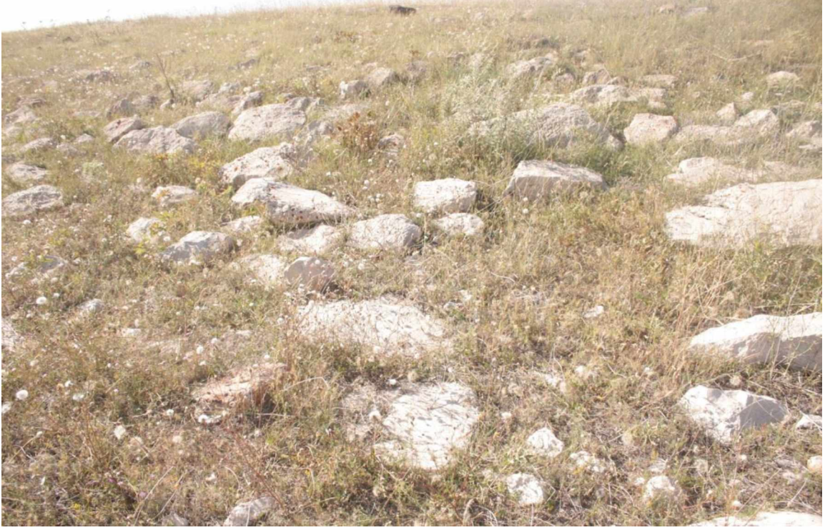
(Resim:41) Karakuyu Hitit Barajı set duvarının taş örgü yapısı ( Ayşe Üke, arşiv)
