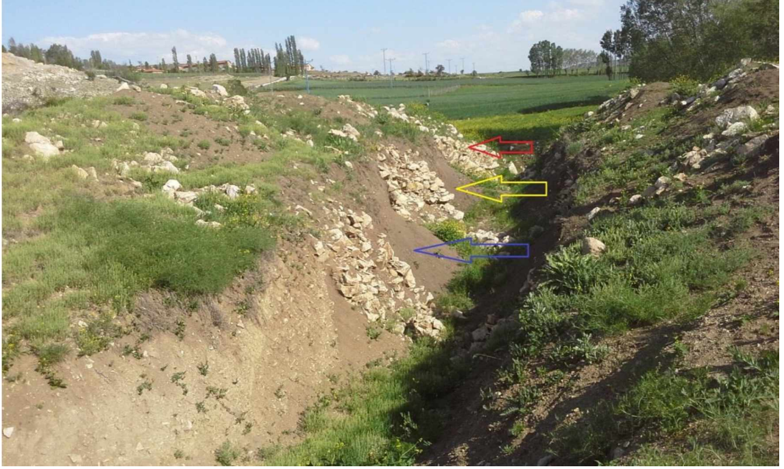
(Resim: 29) Çakır Köyü Hitit Barajı, kırmızı ok ile gösterilen alan baraj setinin taş dolgusunu, sarı ok ile gösterilen yer baraj setinin toprak dolgusu, mavi ok ile gösterilen alan kil çekirdek dokusunu göstermektedir.(Ayşe Üke, arşiv).
