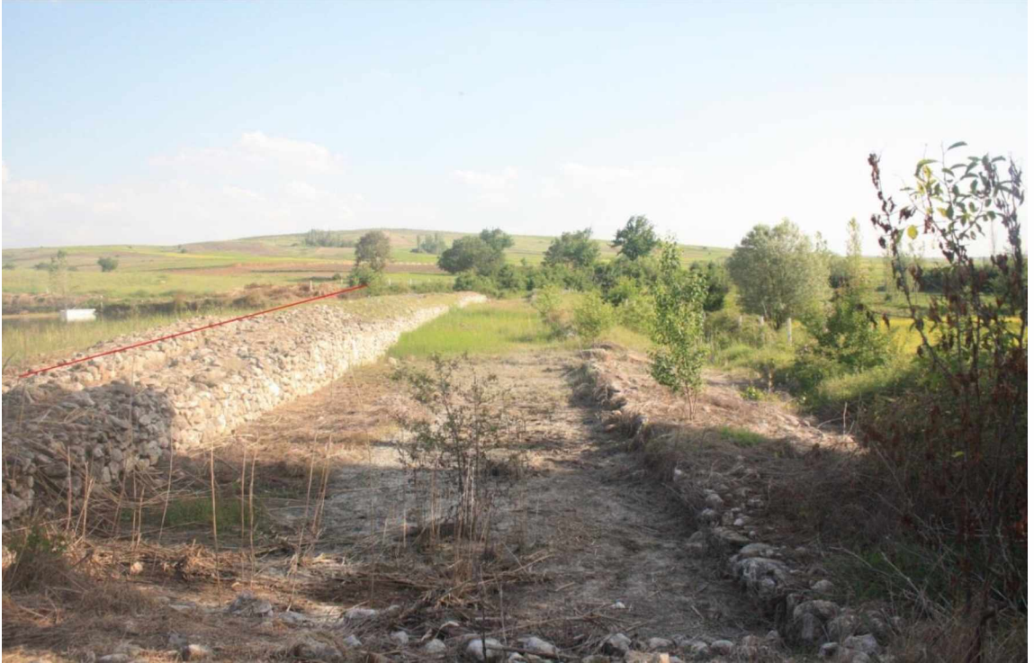
(Resim:6) Alacahöyük Hitit Barajı, şev duvarı kırmızı hat ile belirtilmiştir. (Ayşe Üke, arşiv).
