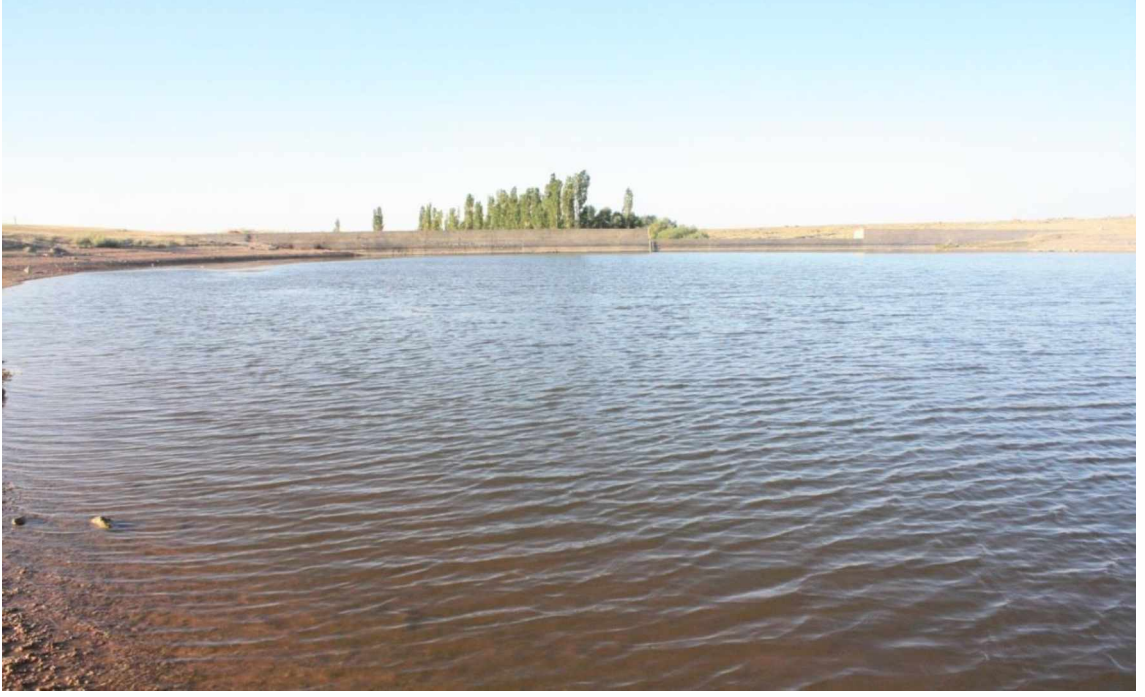
(Resim:59) Karakuyu Hitit Barajı yakınında bulunan doğal oluşum gölet yapısı ve DSI'nin inşa ettiği set duvarı.(Ayşe Üke, arşiv)
