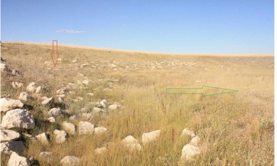
(Resim:42) Karakuyu Hitit Barajı, kırmızı ok ile gösterilen set duvarı, yeşil ok ile gösterilen yer su rezervuar alanı ( Ayşe Üke, arşiv)
