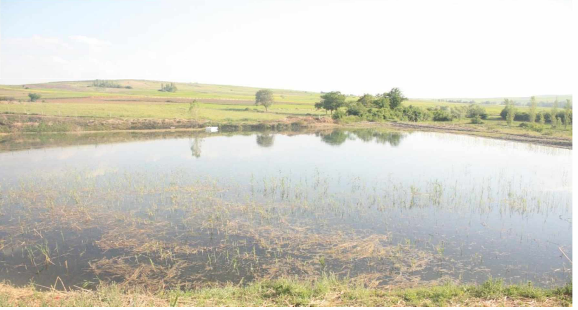
(Resim:1) Alacahöyük Hitit Barajı'ndan bir görünüm; günümüzde haznesinde hala su barındırmaktadır. (Ayşe Üke, Arşiv)
