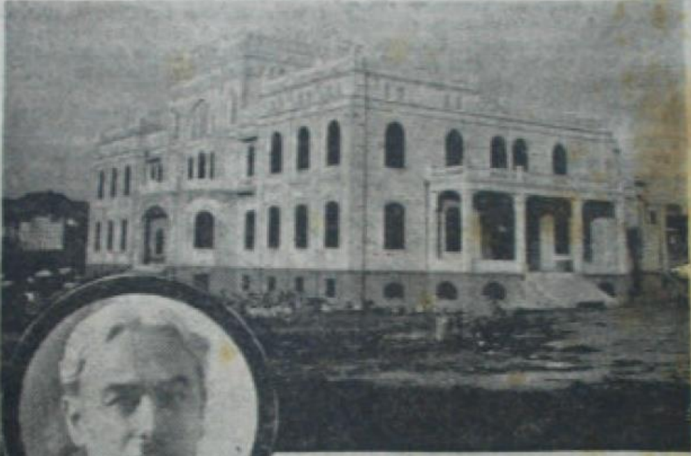
Fırkası Merkezi Umumisi ittihaz edilecek olan Ankara'da Türk Ocakları Merkez binası ile Ocaklar reisi Hamdulla Suphi B.
