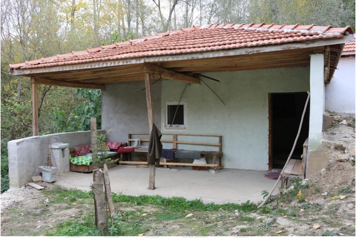
Fotođraf 33. Dođla Ky Ařık pařa trbe binası.
