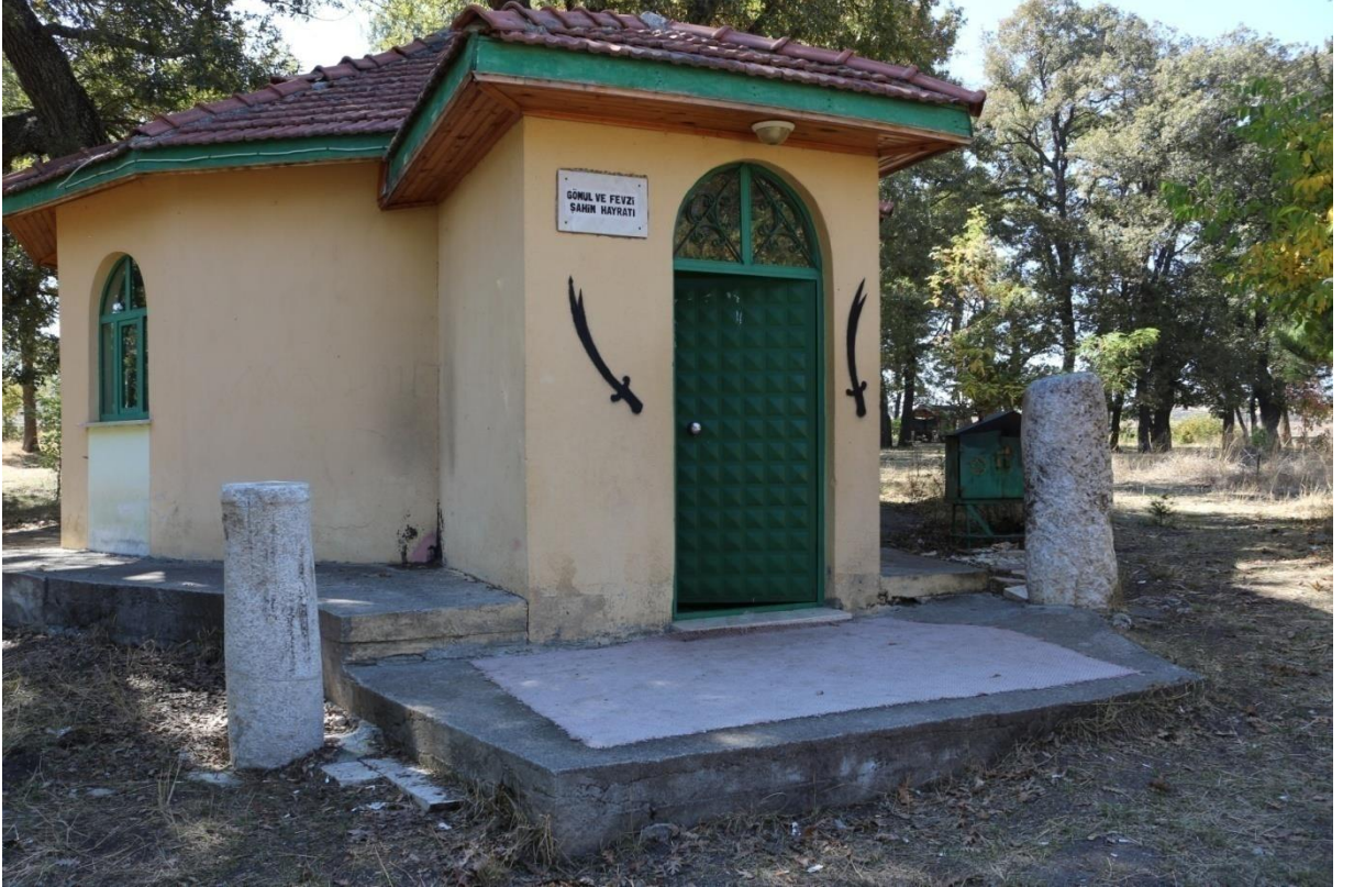
Fotoğraf 21. Dağsaray Köyü Topçam dede türbesi dıştan görünüm.
