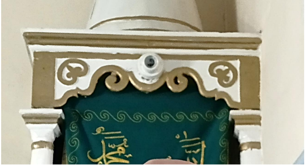
Fotoğraf 5.12.1.11: İnyetullah Camii Minberi Köşk Ve Köşk Tacı (Ön Cephesi).
