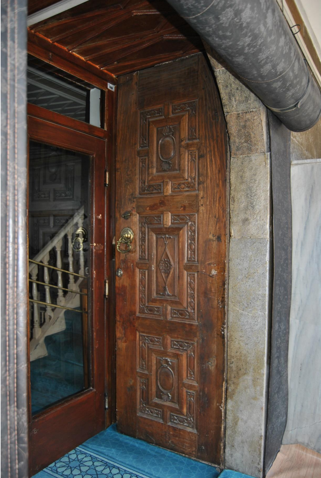
Fotoğraf 5.2.1.1.2: Ulu Camii Doğu Kapı Kanatları.
