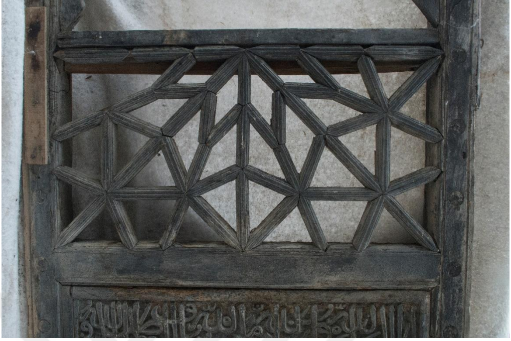
Fotoğraf 5.1.1.14: Muzaffer Paşa Camii Köşk Korkuluğu.
