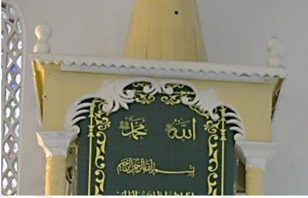
Fotoğraf 5.9.1.11: Kulaksız Camii Minberi Köşk Ve Köşk Tacı (Ön Cephe).
