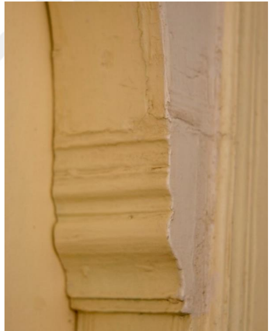
Fotoğraf 5.5.1.2: Kellegöz Camii Kapı Kemerinin Oturduğu Destekler.
