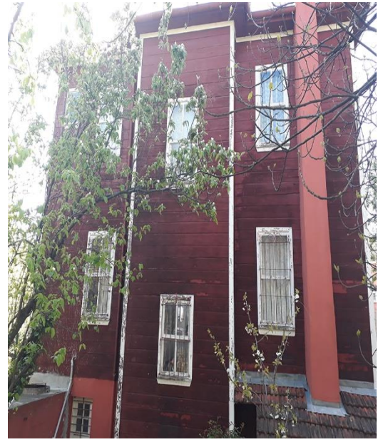
Resim 3.19.2. Zeynep Güleç evi doğu cephesi.
