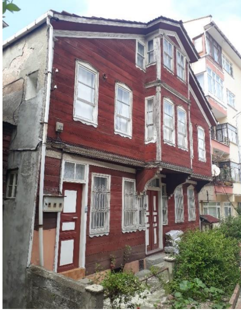
Resim 3.5.1. Şerife Demirkaya evi doğu cephesi.
