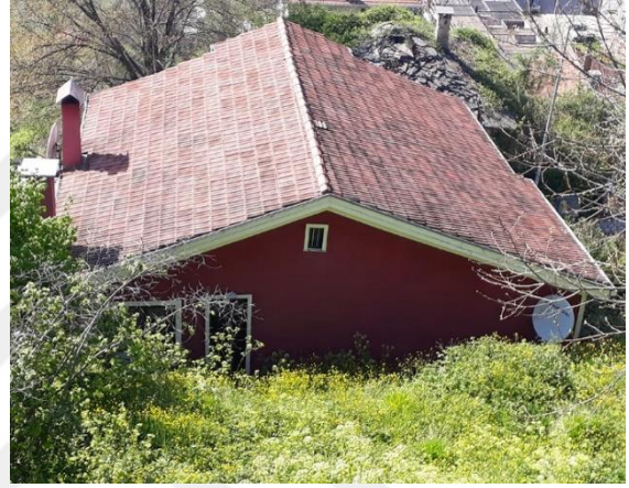
Resim 3.12.4. Makbule Uğuriş evi doğu cephesi
