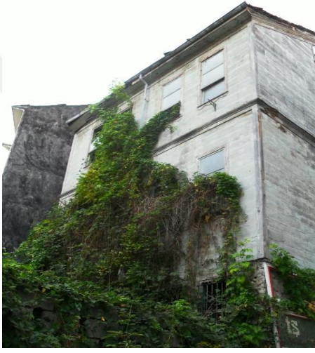
Resim 3.2.3. Gabak Gavur Konađı dođu cephesi
