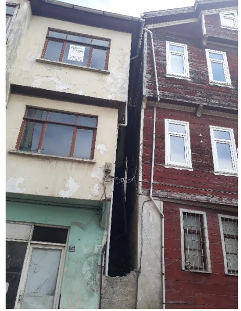
Resim 3.4.2. Huriye Aras evi kuzey cephesi..
