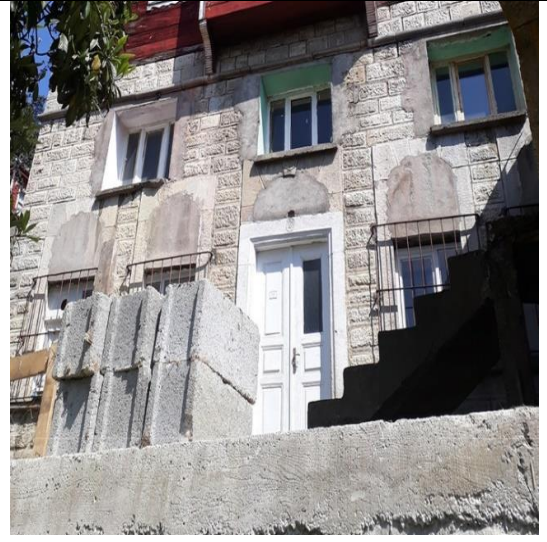
Resim 3.11.8. Mehmet ulkun evi bodrum kat kapısı.
