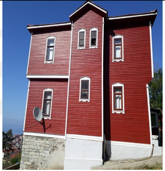
Resim 3.18.4. Yaşar Usta evi güney cephesi.
