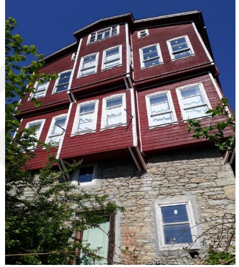
Resim 3.16.4 Melahat Helvacı evi batı cephesi.
