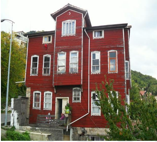
Resim 3.11.3. Mehmet ulkun evi kuzey cephesi.
