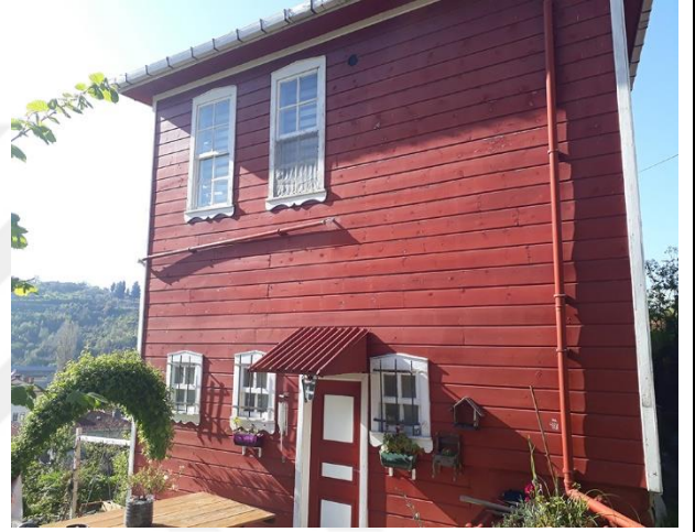
Resim 3.15.4. Faik Yurtseven evi güney cephesi.
