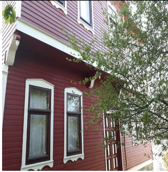
Resim 3.18.3. Yaşar Usta evi kuzey cephesi.
