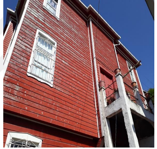
Resim 3.13.4. Erhan Şivetoğlu evi güney cephesi.
