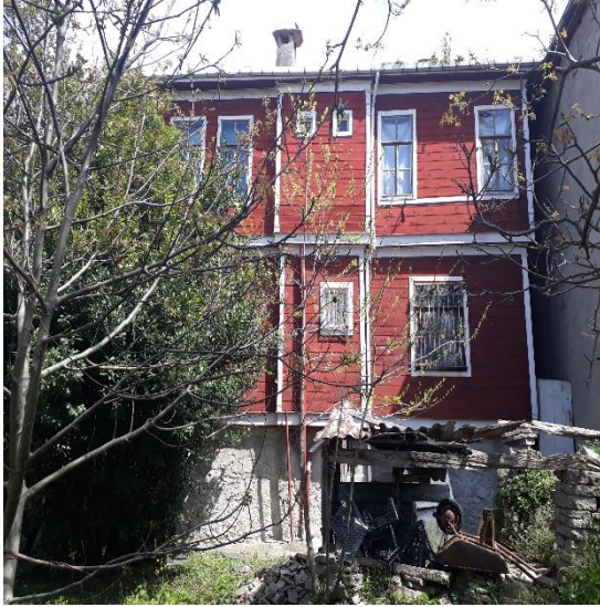
Resim 3.8.3. Azize Kırçalı evi batı cephesi.
