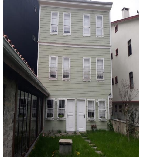
Resim 3.2.6. Gabak Gavur Konađı dođu cephesi.
