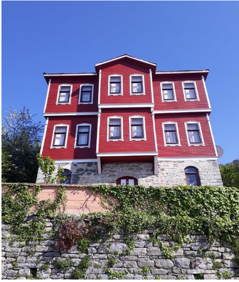
Resim 3.18.1. Yaşar Usta evi batı cephesi.
