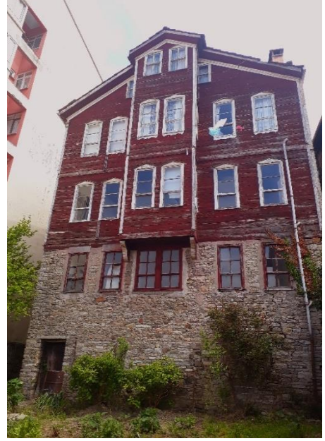
Resim 3.5.2. Şerife Demirkaya evi batı cephesi.
