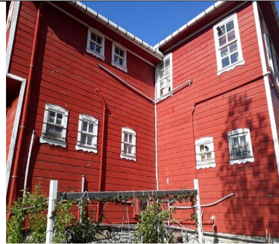
Resim 3.15.5. Faik Yurtseven evi güney cephesi.
