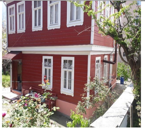
Resim 3.1.4. Aysel Okçu evi kuzey cephesi.
