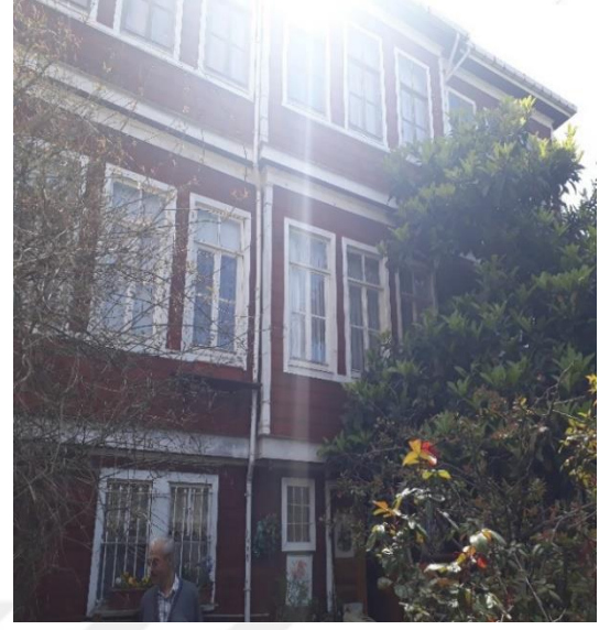
Resim 3.8.2. Azize Kırçalı evi uzey cephesi.
