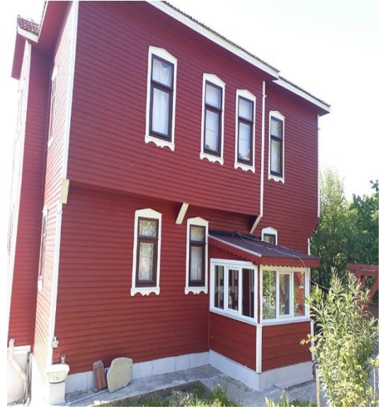
Resim 3.18.2. Yaşar Usta evi doğu cephesi.
