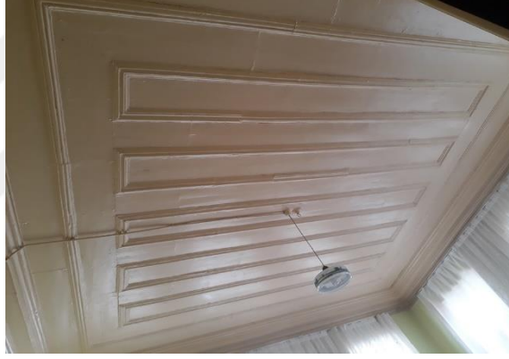
Resim 13.1.9. Aysel Okçu evi kuzeydoğu odanın tavanı.
