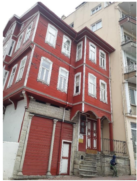
Resim 3.3.2. Kayıkçı Mustafa Konağı batı cephesi.
