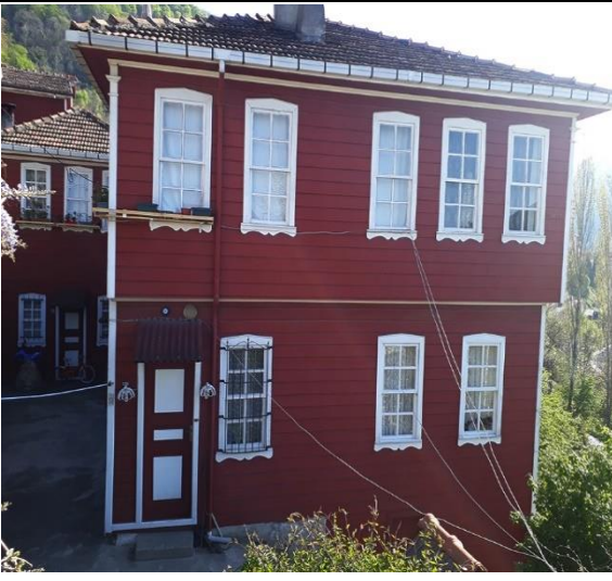
Resim 3.15.1. Faik Yurtseven evi kuzey cephesi.
