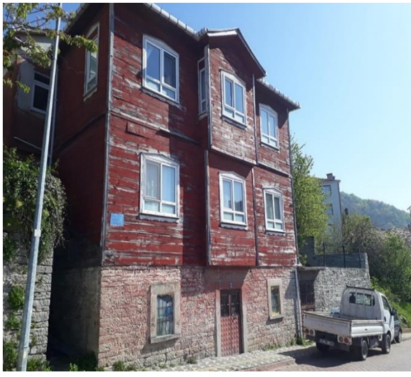
Resim 3.17.1. Veli Tok evi batı cephesi.
