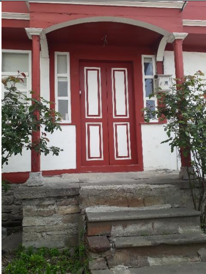
Resim 3.3.5. Kayıkçı Mustafa Konağı zemin kat kuzey kapısı.
