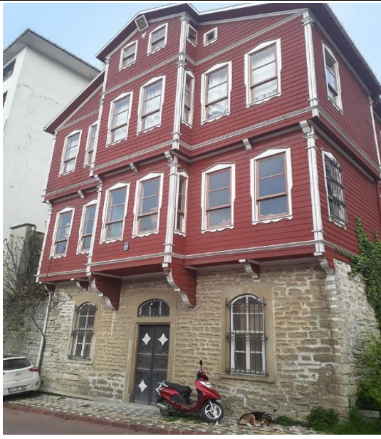
Resim 3.14.1. Ferruh Hücümenoğlu batı cephesi.
