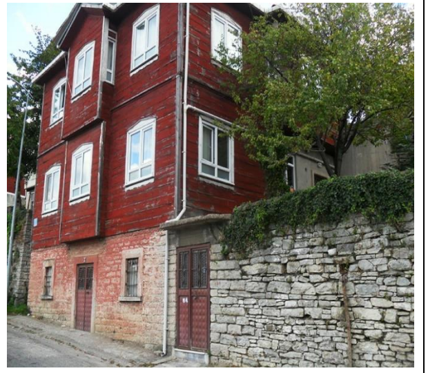
Resim 3.17.2. Veli Tok evi güney cephesi.
