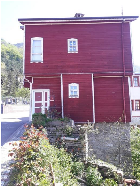
Resim 3.16.1. Melahat Helvacı evi kuzey cephesi.
