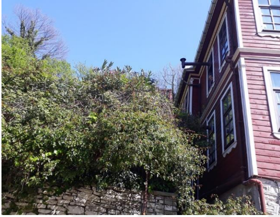
Resim 3.12.3. Makbule Uğuriş evi kuzey cephesi
