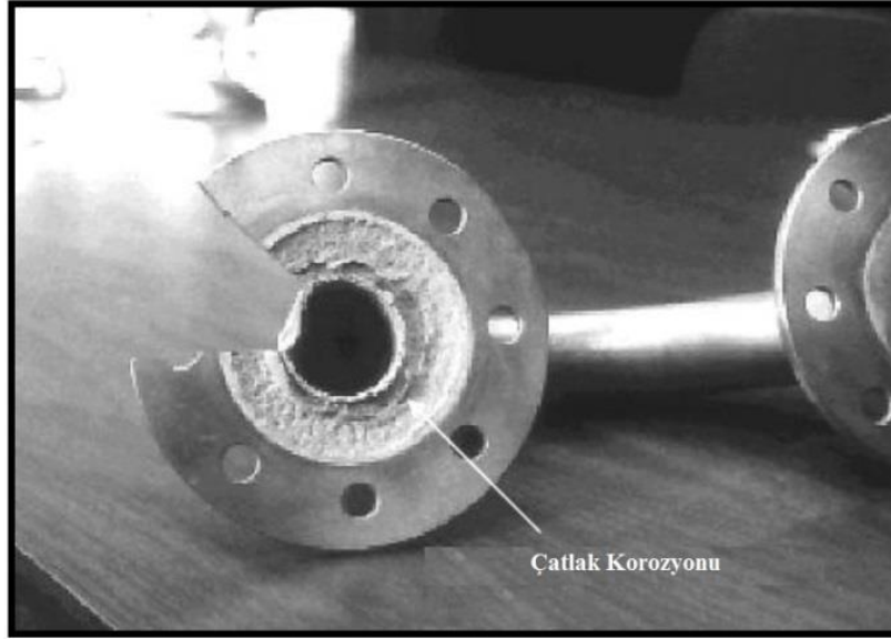
Resim 2.5. Titanyum bir kanat üzerinde çatlak korozyonu (Anonim, 2008)
