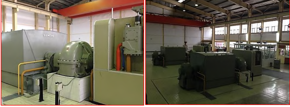
Resim 1.2. Termik elektrik santrali buhar türbini
