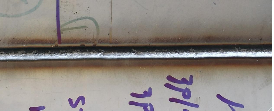
Resim E1.8. 4 numaralı kaynak kep bölgesi görünüm
