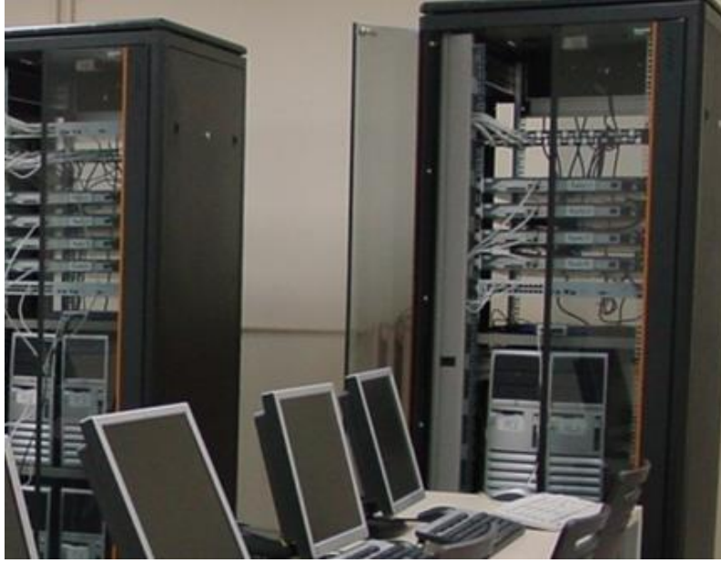
Şekil 2.1. Yönlendiriciler, anahtarlar, KVM anahtar, bilgisayarlar ve kablolar ile oluşturulmuş modüler bir kabin.
