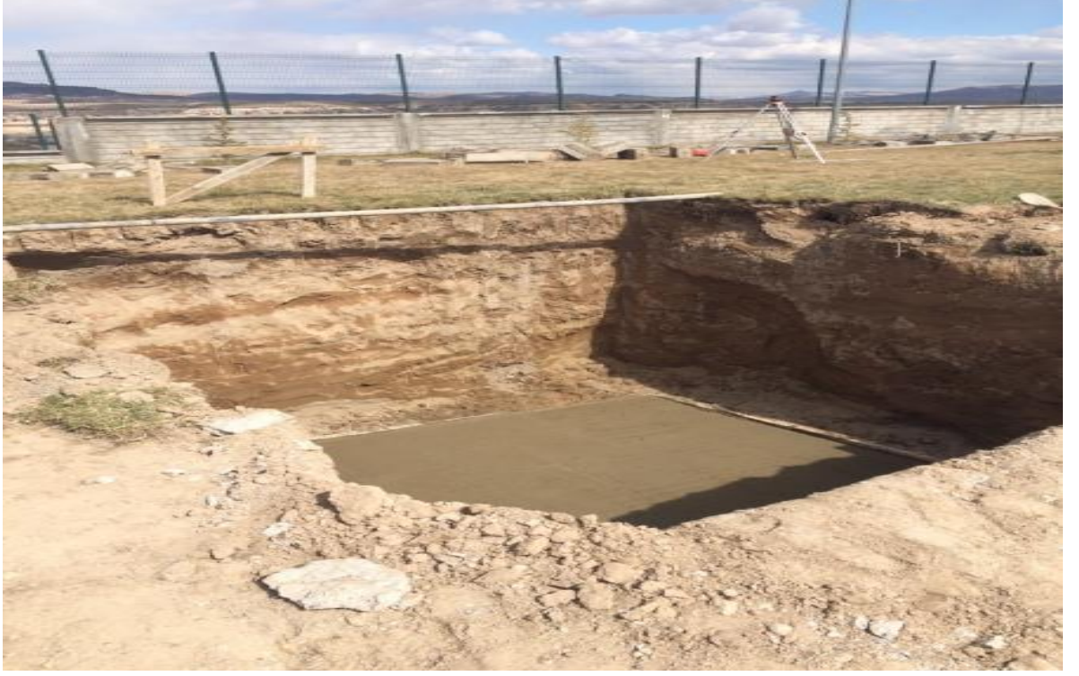
Şekil 3.1: Şantiye kurulumuna hazırlık tesis içinde bir çukur.
