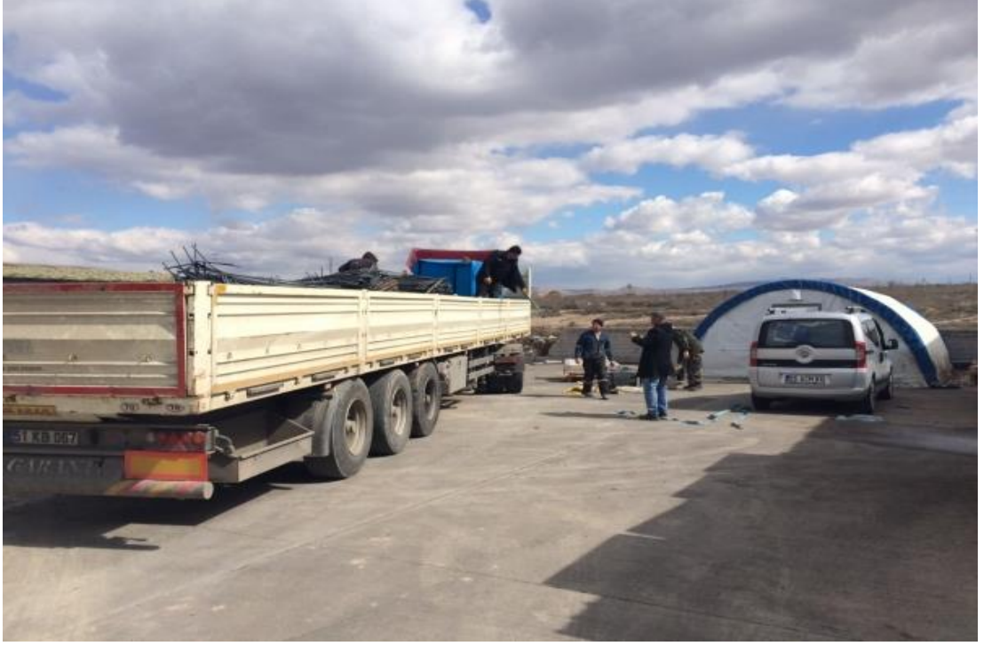
Şekil 3.6: Şantiyeye gerekli malzemelerin taşınması
