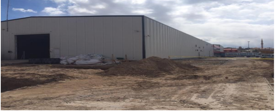
Şekil 3.2: Şantiyede mobilizasyon birimleri kurulumu.
