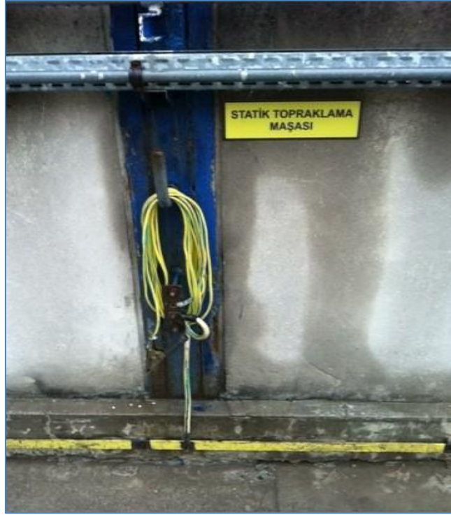
Şekil A.8.4 : Kimyasal madde taşıyıcı aracın yük boşaltımı sırasında kullanılan topraklama maşası
