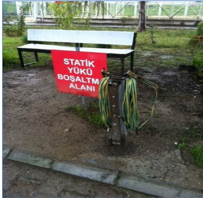
Şekil A.8.1 : Statik elektrik deşarj noktası.
