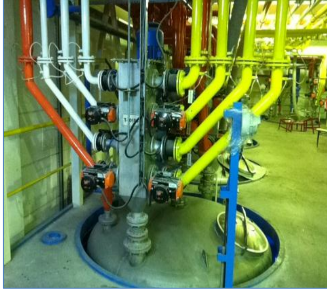
Şekil A.8.11: Pnömatik sistem sıvı transferi ve flanşlar arası iletken kablo ile statik deşarj topraklama örneđi
