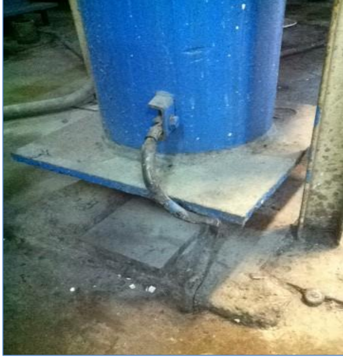
Şekil A.8.9: Yarı mamul kimyasal madde deposu topraklama örneği
