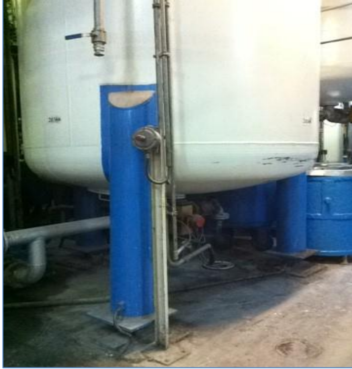
Şekil A.8.10: Depo topraklama örneği
