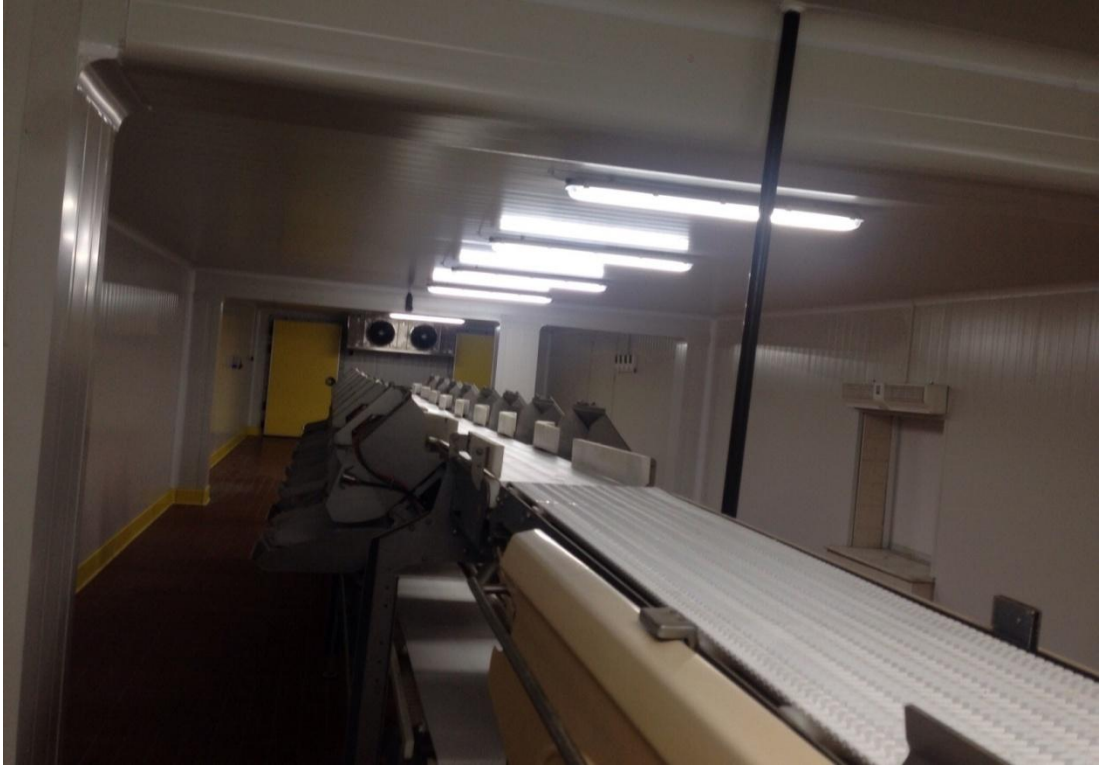
Şekil 3.3 Balık üretim tesisi paketlenme ünitesi
