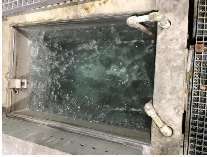
Şekil 2. 15: Akar Yıkama Havuzu
