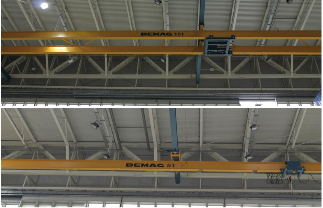
Resim 75: Hangar tavanlarında bulunan vinçler (kreyner)
