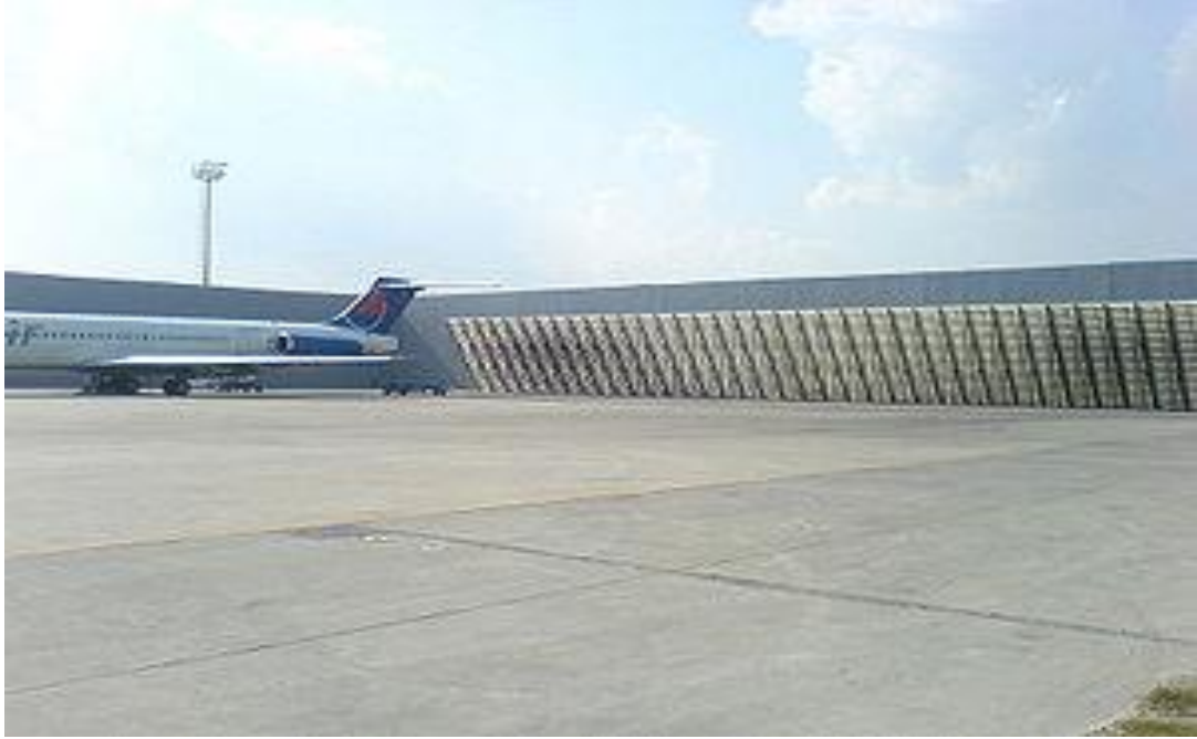
Resim 81 : Motor testlerinin yapıldığı bremze alanı
