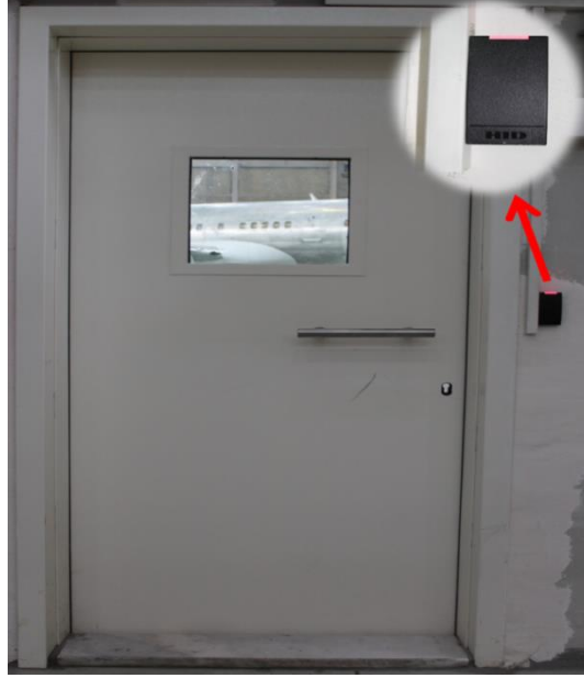
Resim 86: Kartlı sistemle çalışan boya hangarı giriş kapısı
