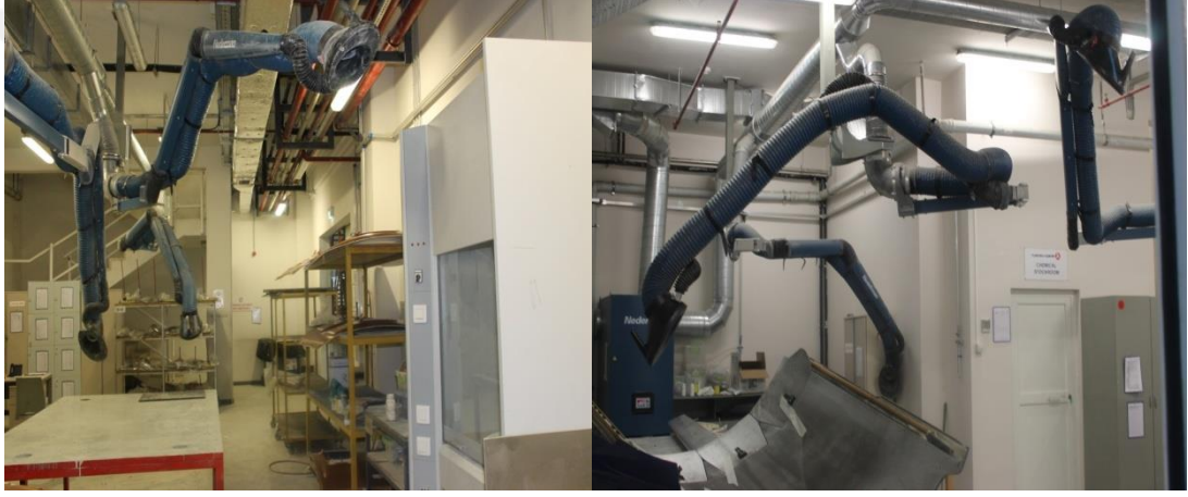
Resim 92: Ahtapot kollu toz emiř sistemi kaplama, kompozit ve panel atölyelerinde kullanılır
