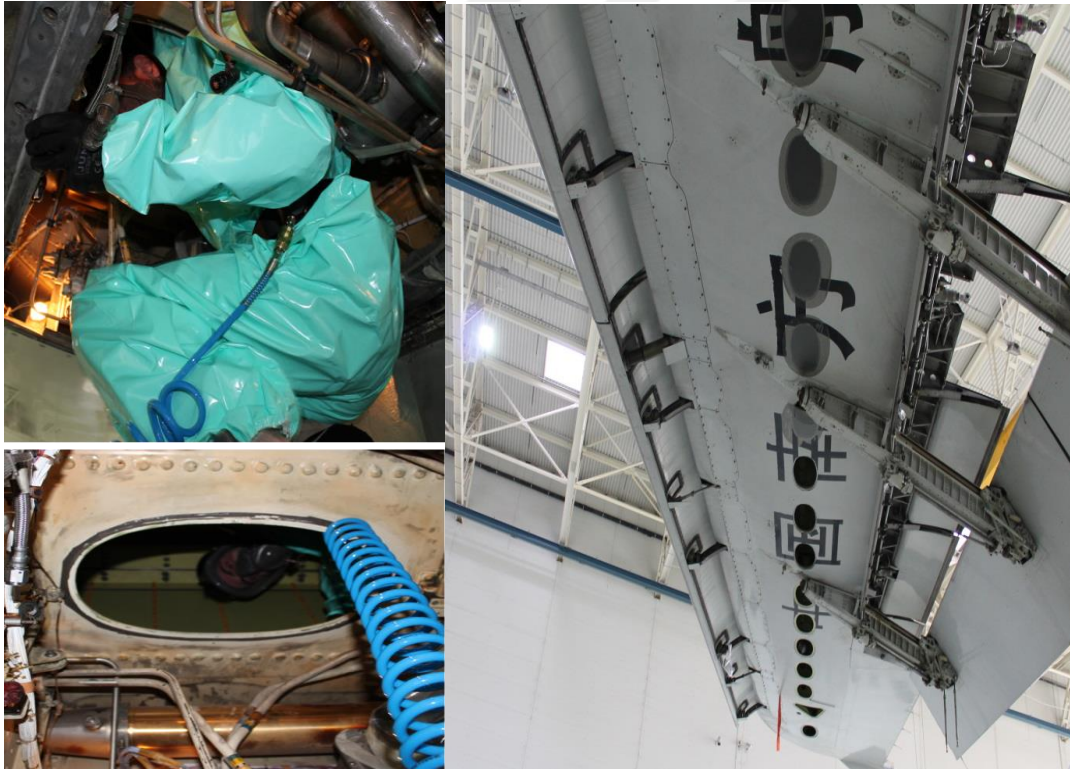
Resim 136: Kanatta bulunan yakıt tanklarına ait giriş kapakları
