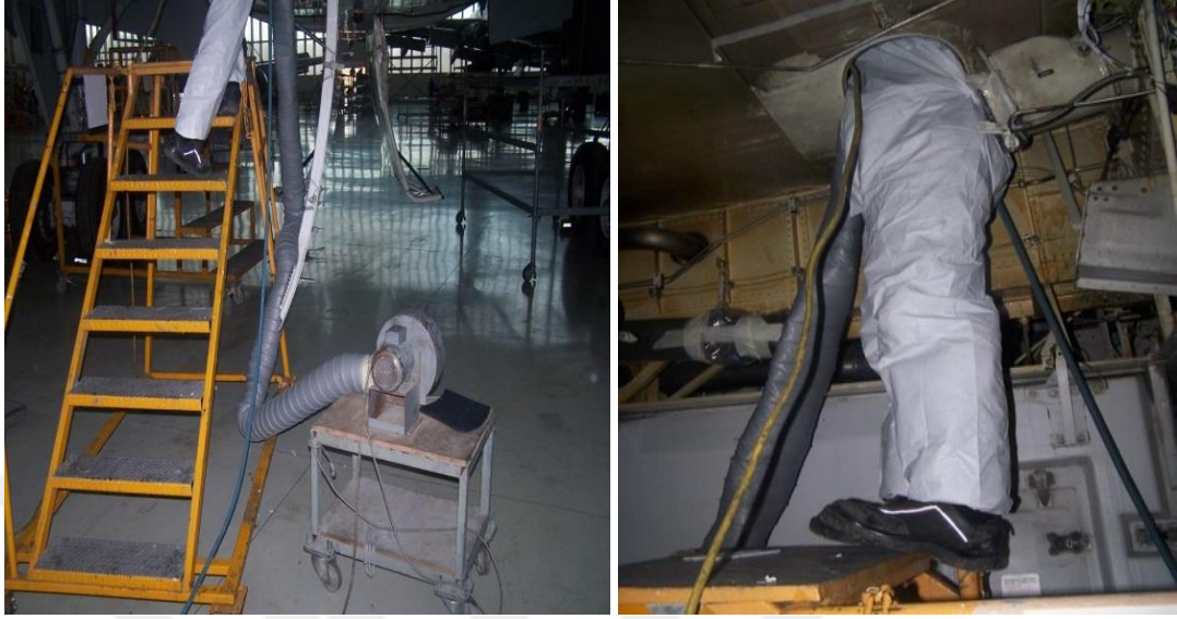
Resim 59: Yakıt tankı havalandırması Resim 60: Anti – statik tulum ve ekipmanlar
