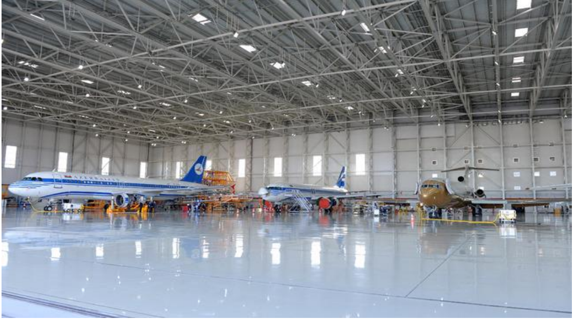
Resim 35: Doğal ışık kaynağı, zemin ve çatı dizaynı ile aydınlatılmış uçak bakım hangarı
