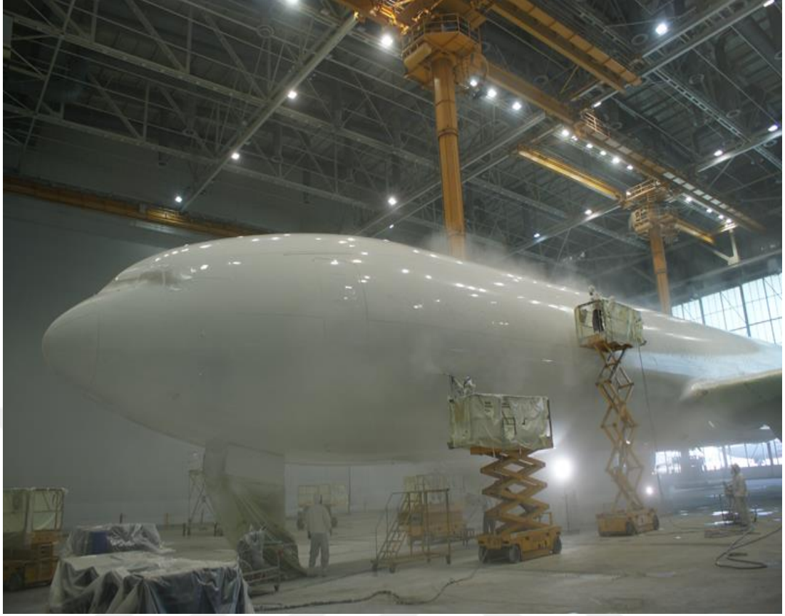
Resim 7: Uçak boya hangarı
