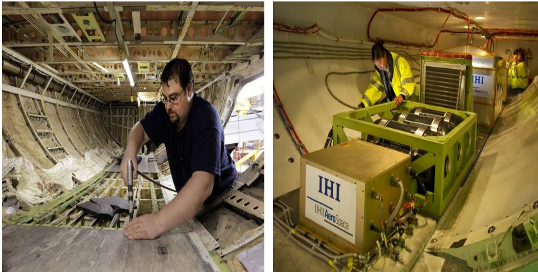
Resim 121: Kargo kısmında yapılan bazı çalışmalar
