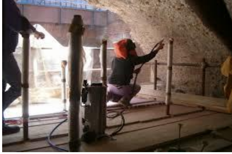
Resim 3.1 Kumlama İşlemi Sırasında Çalışanın Durumu
