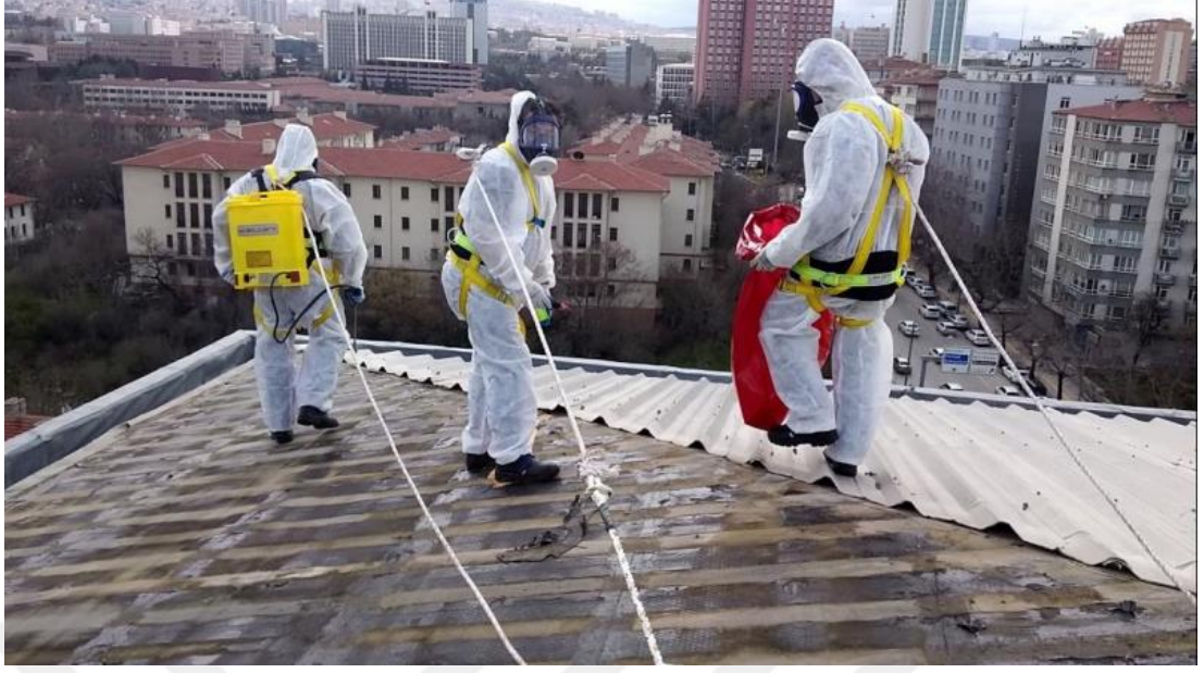
Resim 3. 2 Çatıda Asbest Temizleme İşlemi Yapan Çalışanlar
