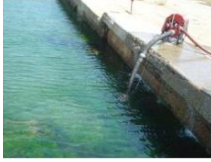
Resim-2.4. A tipi hortumun kullanımı(İBB,2013)
