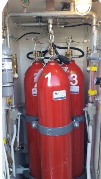
Resim-4.2. Sabit CO 2 sisteminde kullanılan çelik çekme tüpler (11 Aralık 2016 tarihinde çekilmiştir)
