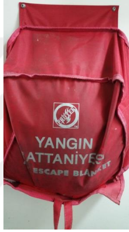
Resim-5.9. Mutfakta kullanılan yangın battaniyesi (25 Aralık 2016 tarihinde çekilmiştir)
