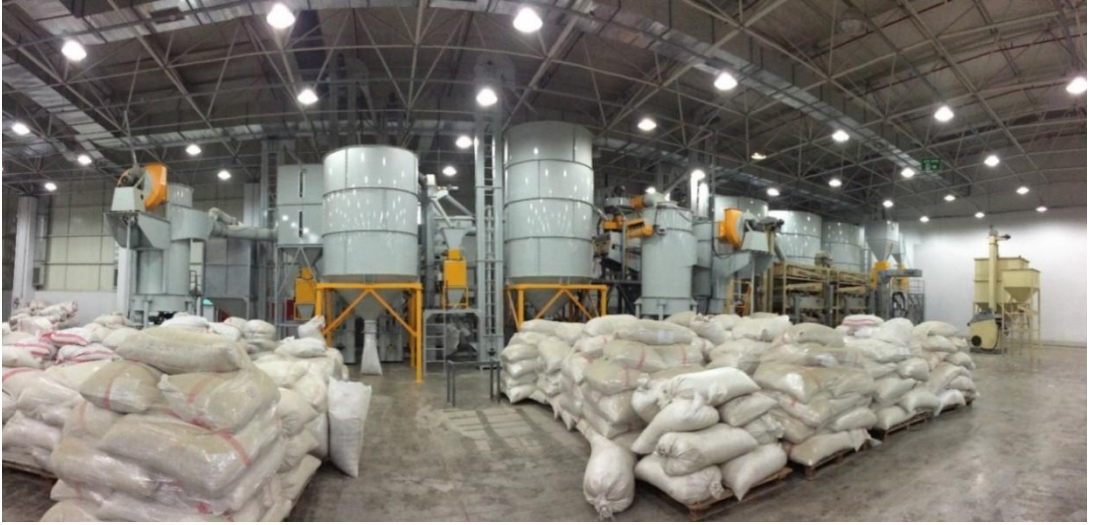
Şekil 2. 1: Eleme ünitesi tesisi
