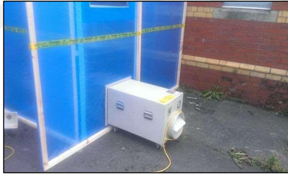
Resim 8.3 Negatif basınç ünitesi (İSGÜM,2016).
