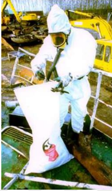
Resim 9.3b Hollanda'daki gemi ayrıştırma tesislerinde uygun kıyafetle ve ekipmanla asbest ayrıştırılması. (Vardar ve Harjono, 2002)
