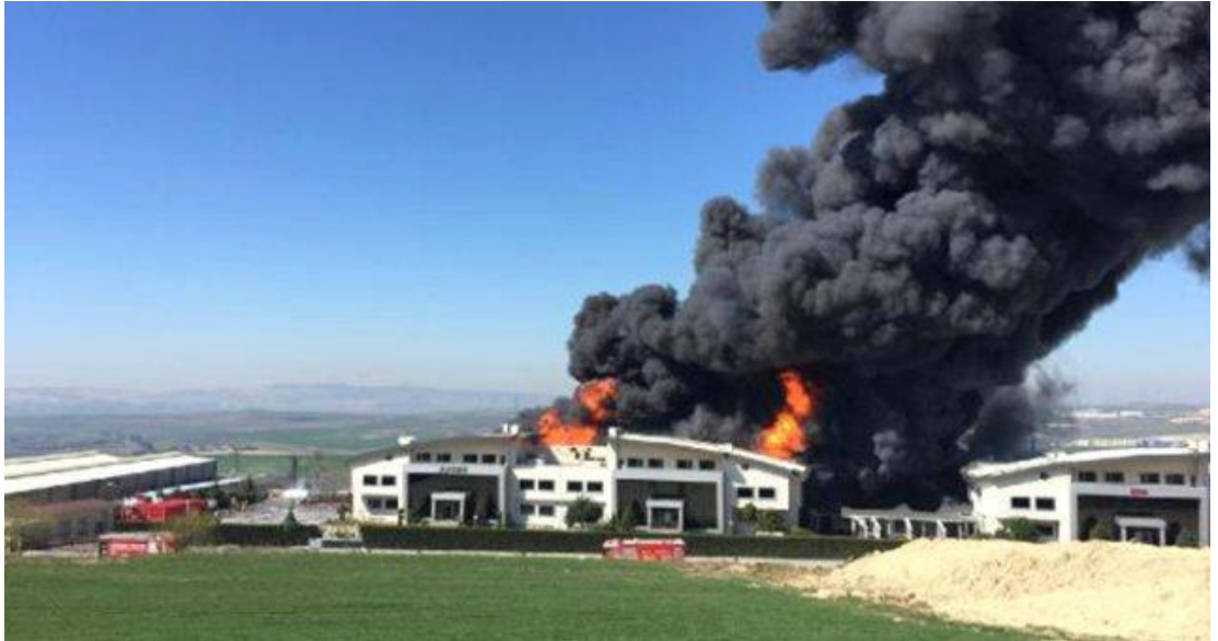
Şekil 2.3: Hadımköy'de 3 katlı fabrikada patlama
