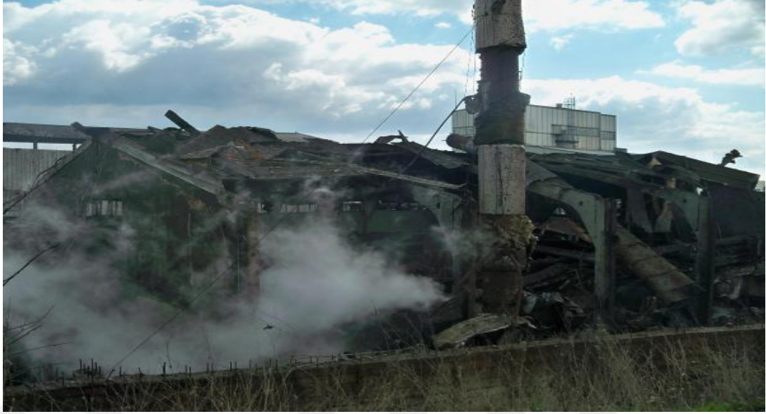
Şekil 2.7: Malkara'daki süt fabrikasında buhar kazanı patladı
