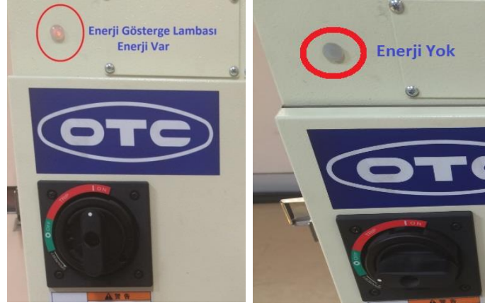
Şekil 4. 36 Yanan ve Sönmüş Kapasitif Gerilim Gösteren Ünite Lambası
