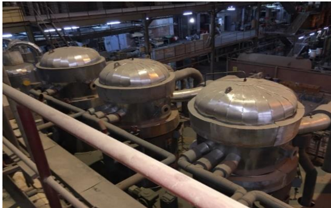
Şekil 3.11: Alçak ve Yüksek Basınç Isıtıcıları
