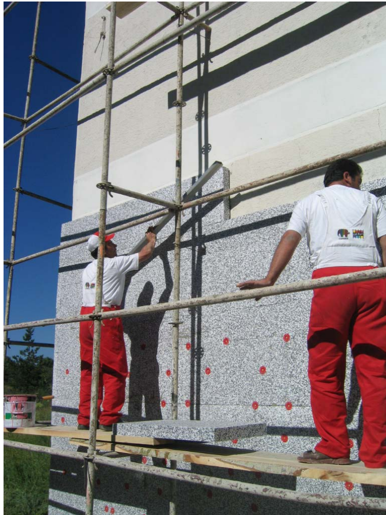
Şekil 3.21 8 cm kalınlığındaki levhalar teraziye alınırken
