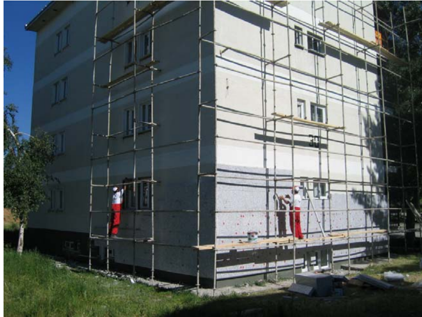
Şekil 3.20 30. Blok mantolama uygulaması (kuzeybatı görünümü)
