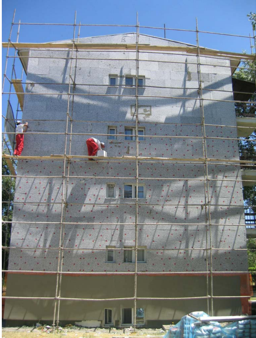
Şekil 3.22 Batı cephesinde dübelleme işleminden bir görünüm
