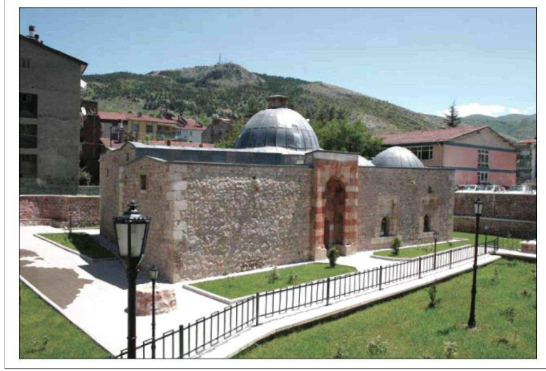
3.2.8.1.6. Halef Sultan Zaviyesi
