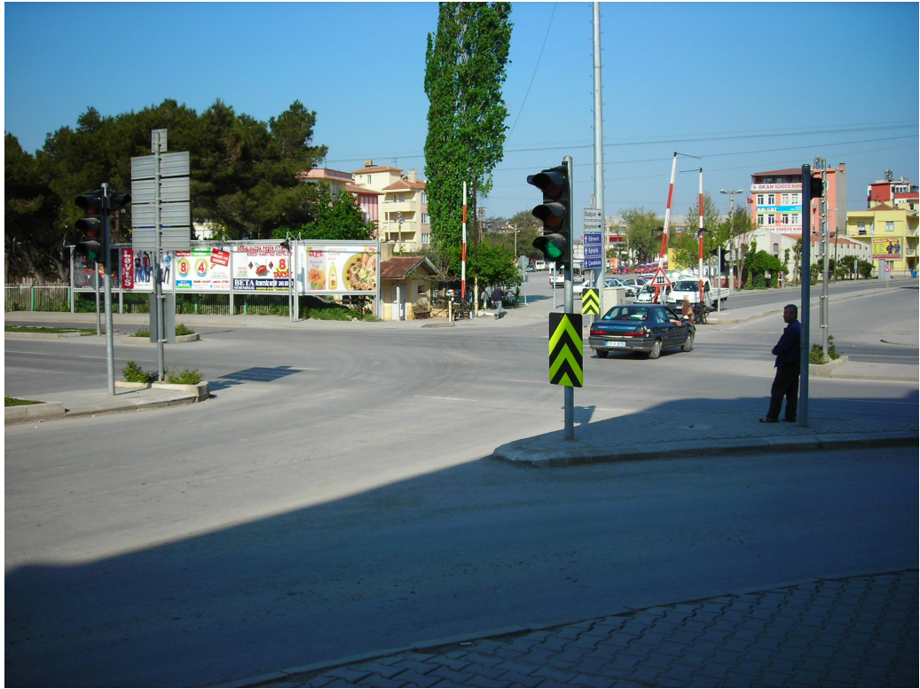
Şekil 8.11.(a) Doğumevi (Uğur Mumcu) Kavşağı Fotoğrafı
