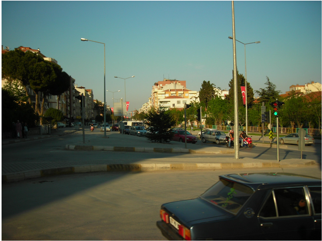
Şekil 8.27.(a) Basri Otel Kavşağı Fotoğrafı
