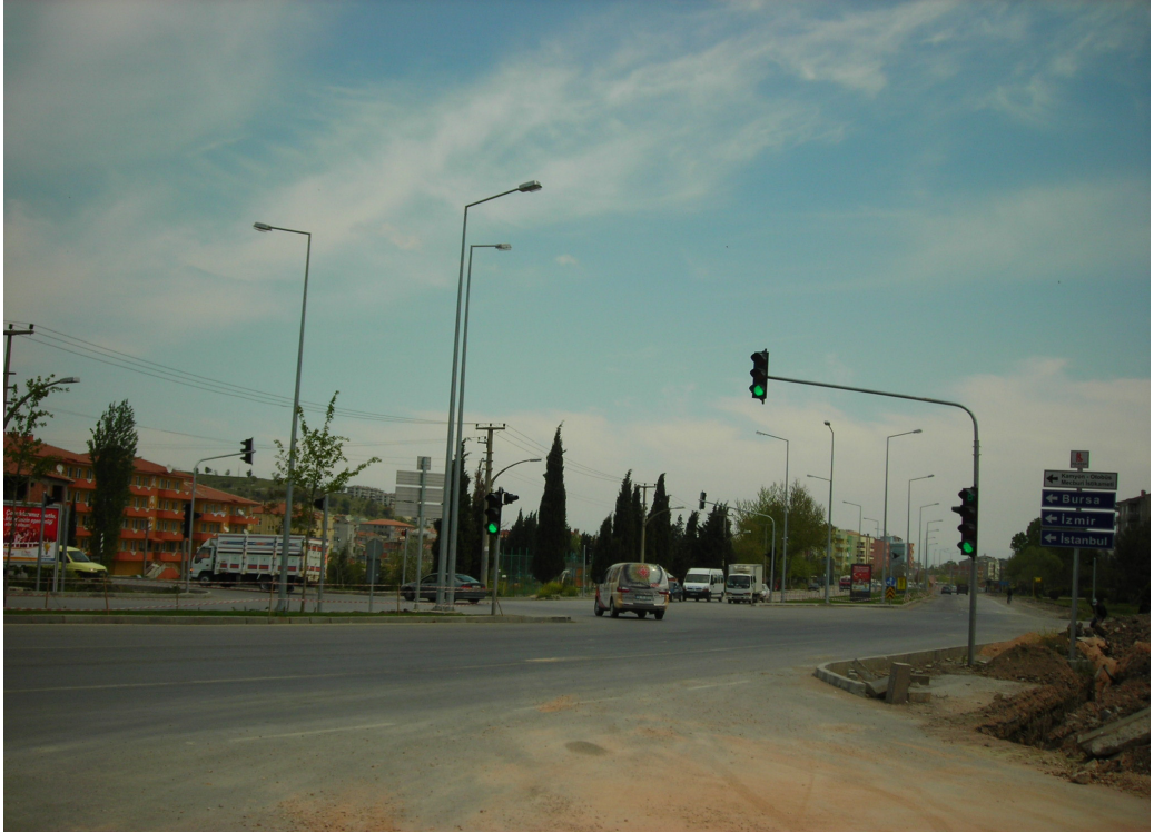
Şekil 8.47.(b) Edremit Çevre Yolu Kavşağı Fotoğrafı
