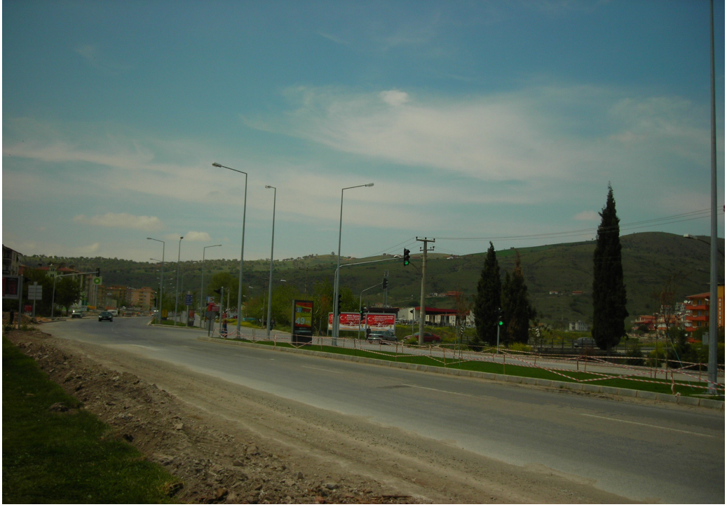
Şekil 8.47.(a) Edremit Çevre Yolu Kavşağı Fotoğrafı
