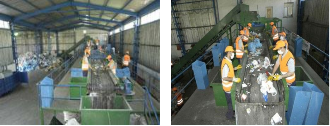
Şekil 2.3. Belediye geri dönüşüm tesislerinde atıkların ayrıştırılması
