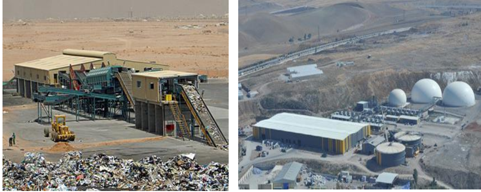
Şekil 1.2. Mamak Belediyesi katı atık geri dönüşüm tesisi
